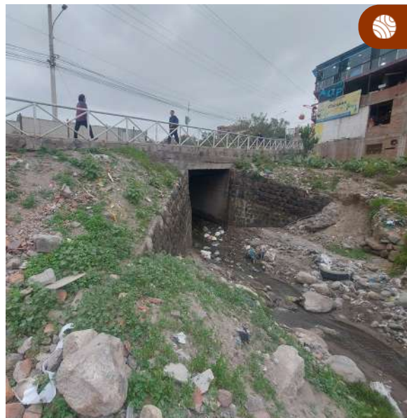
Figura 27. Puente peatonal y vehicular de sección reducida ubicado entre el límite del núcleo urbano Pueblo Tradicional de Paucarpata y Cooperativa Cristo Rey.
