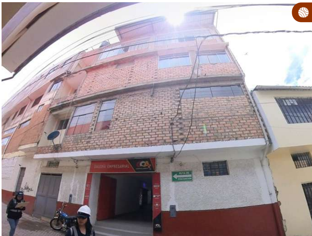
Edificación con voladizos de cuatro niveles con múltiples muros de ladrillo pandereta sin arriostre.
