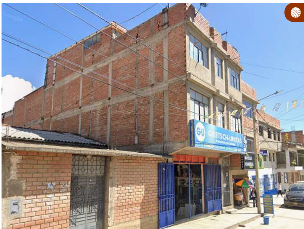
Edificación de cuatro niveles con muy buen estado de conservación; no obstante, los muros portantes fueron cortados para el paso de tubería, quedando parcialmente sin arriostramiento.
