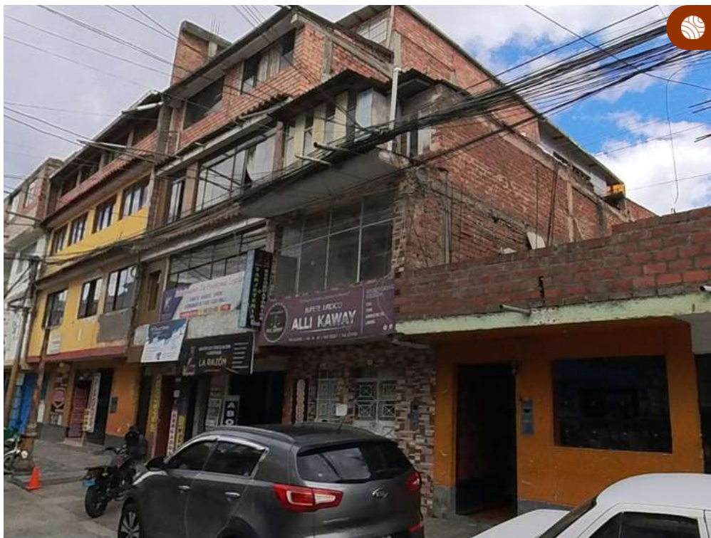
Edificación con regular estado de conservación de tres niveles, con presencia de columna discontinua y muro sin arriostre.
