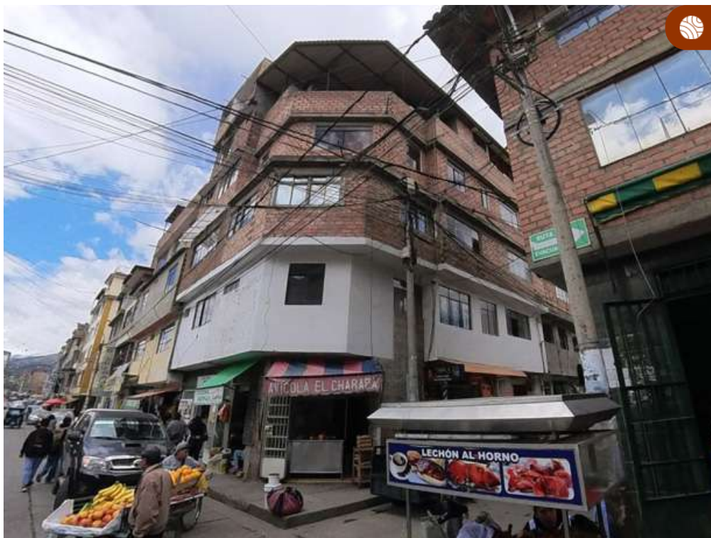
Edificación con voladizos de cinco niveles con múltiples muros sin arriostre utilizada para negocios y vivienda multifamiliar. Esta estructura es recurrente en la zona comercial.
