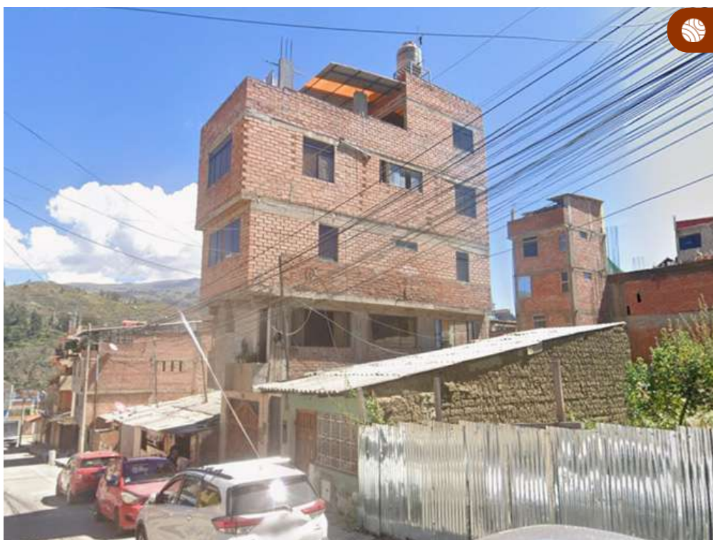
Edificación de cinco niveles con múltiples voladizos, materiales heterogéneos y muros sin arriostre.
