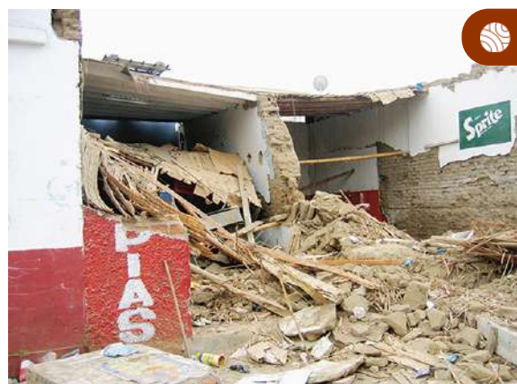
Figura 25. Colapso del techo de material liviano; en contraste, el techo de madera no sufrió daños.
