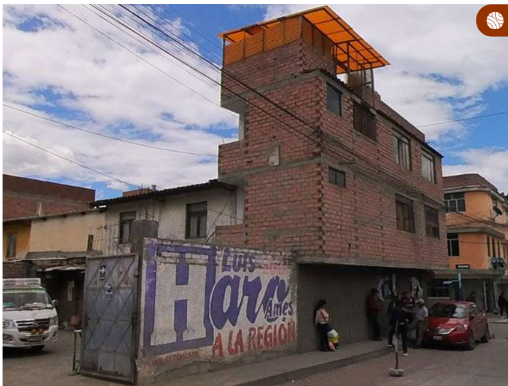
Edificación de tres niveles con presencia de voladizo y muros de ladrillo pandereta sin arriostre.
