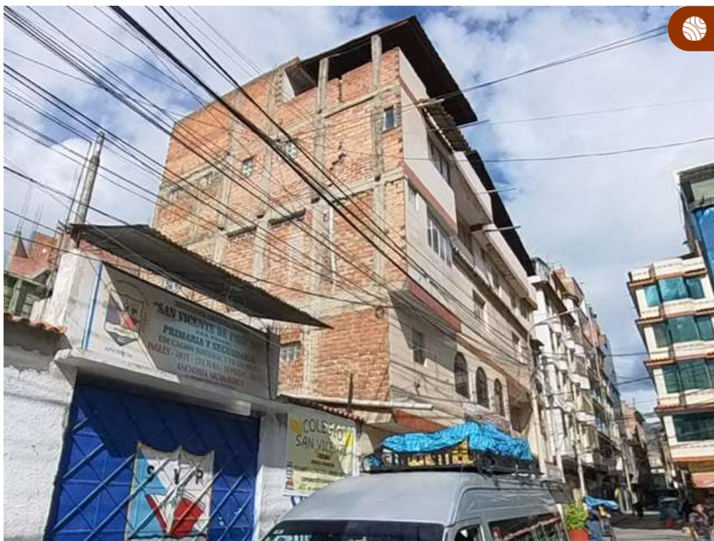
Edificación con estado de conservación regular de cinco niveles, con columnas discontinuas y muros heterogéneos.
