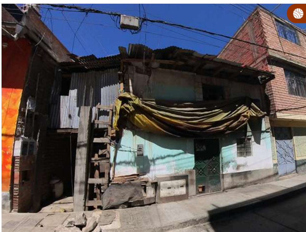
Edificación de adobe de dos niveles en muy mal estado de conservación. El techo de calamina se encuentra igualmente en condiciones deficientes.
