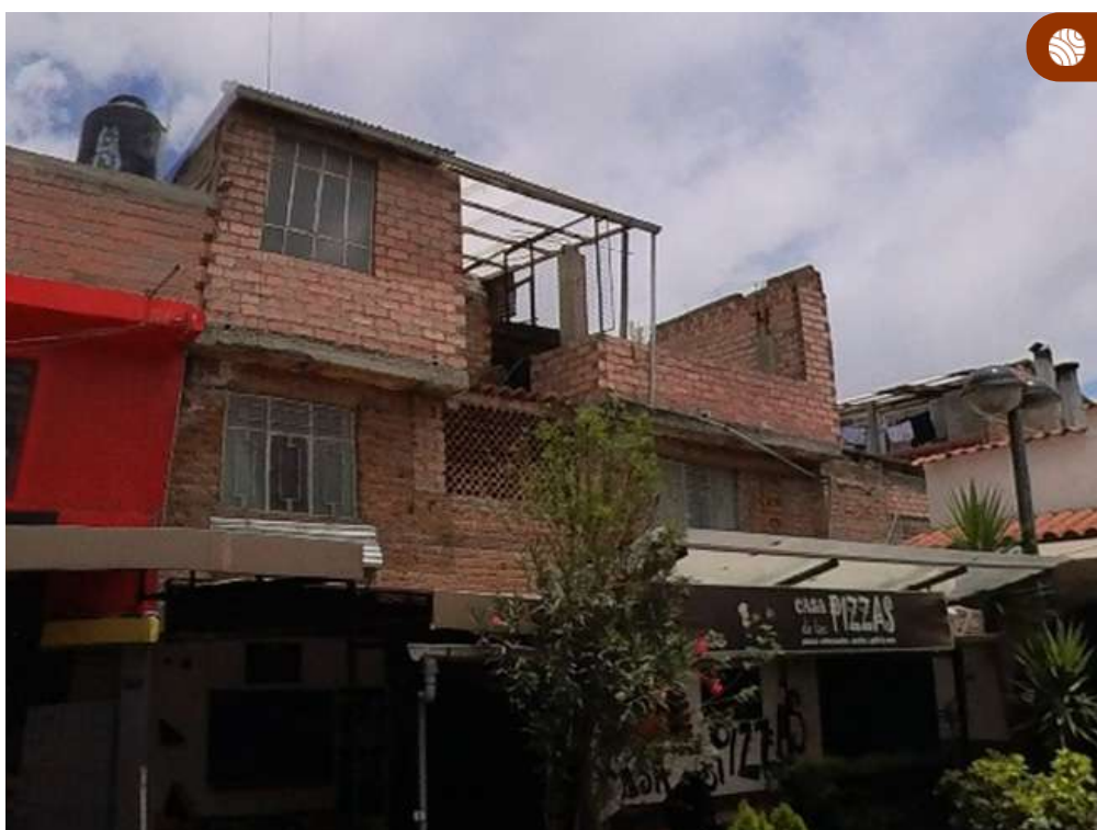
Edificación de tres niveles con estado de conservación regular y una configuración irregular, sin arriostre de muros.
