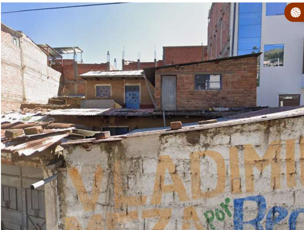
Edificación con primer nivel de adobe y segundo nivel construido en albañilería de ladrillo.
