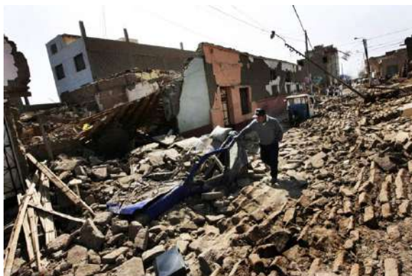
Figura 21. Viviendas de adobe desplomadas en el sismo de Pisco de 2007 (Peña, 2016).
