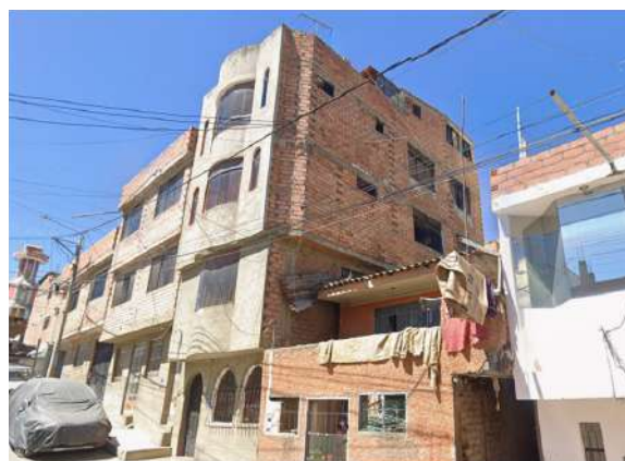
Figura 34. Vivienda de cinco niveles con muros de ladrillo pandereta y sin arriestre (Google Street View).
