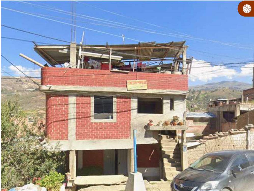
Edificación de dos niveles con presencia de piso débil.
