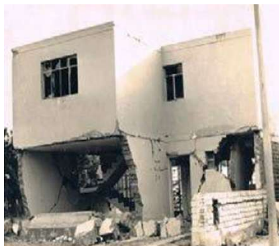
Figura 22. Vivienda con ausencia de columnas de concreto (Kuroiwa, 2016).
