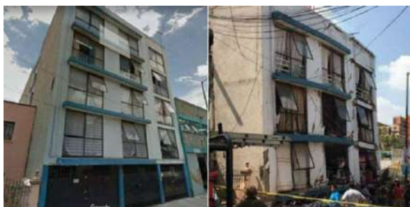
Figura 24. Error por piso blando después del sismo de México en 2017 (Pablo, 2017).
