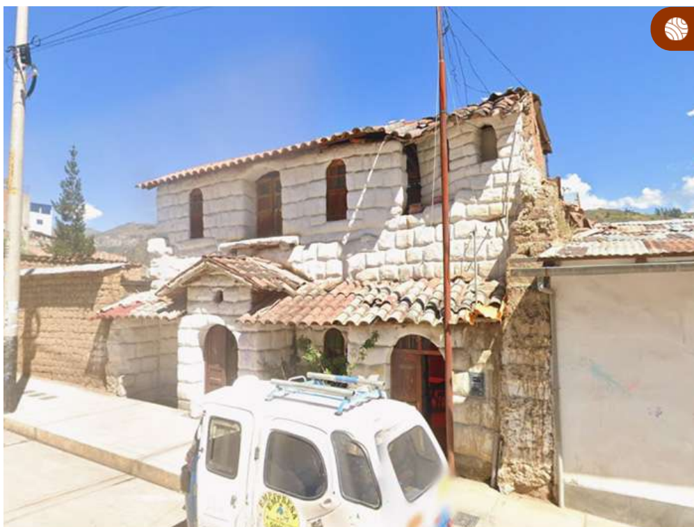
Edificación antigua de adobe de dos niveles, con el techo en mal estado de conservación.
