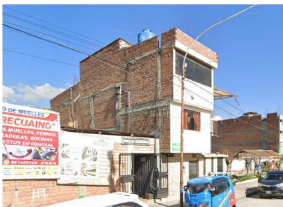
Figura 33. Vivienda multifamiliar con discontinuidad de vigas y columnas (Google Street View).
