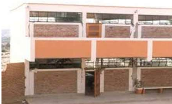
Figura 23. Colegio con presencia de columna corta después del sismo de Nazca en 1996.
