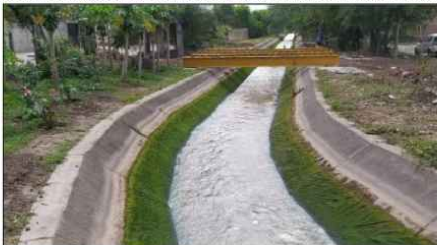
Figura 27. Canalización de cauce de la Qda. Martita con sección trapezoidal
