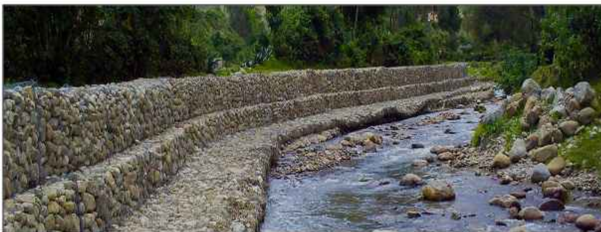
Figura 25. Defensa ribereña en el río Marta (La Morada) con Gaviones
