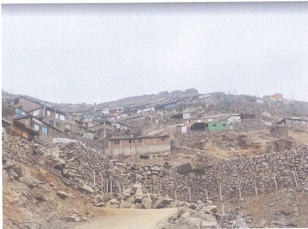
Viviendas asentadas sobre pircas, con material precario en AF Los Sauces
