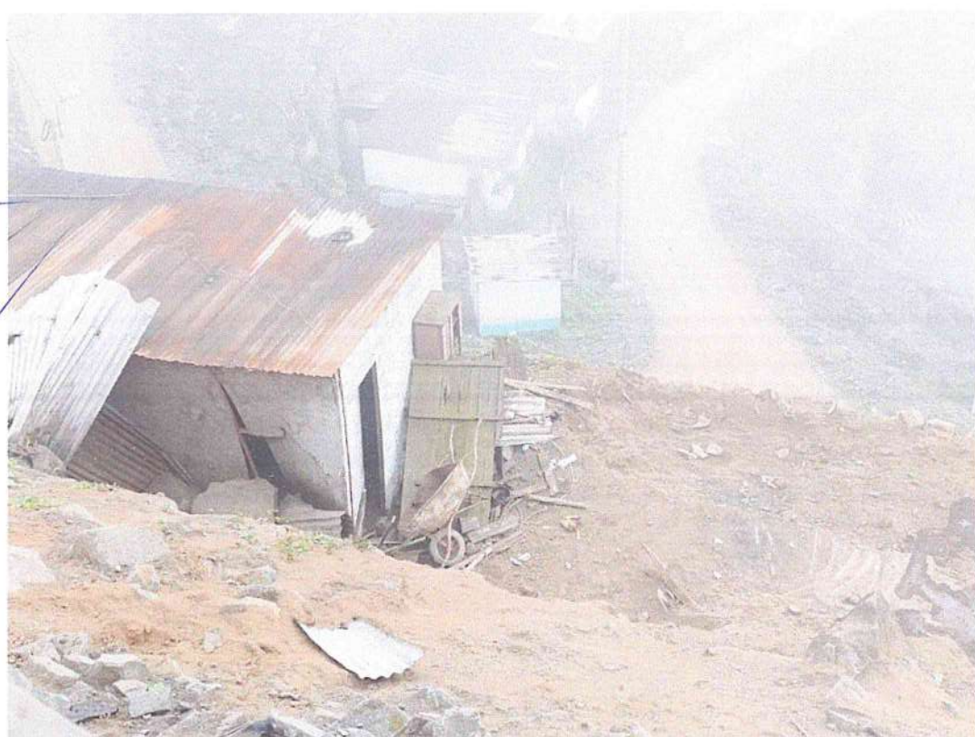
Viviendas con techos de Eternit y paredes de triplay en AAFF Los Jardines de Casa Blanca
