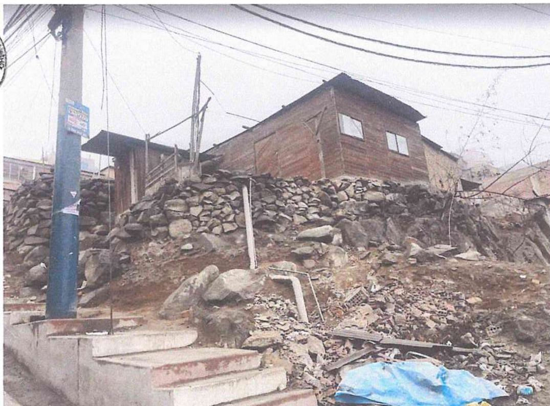
Tuberías expuestas fuera de la vivienda en el AAHH Caja de Agua
