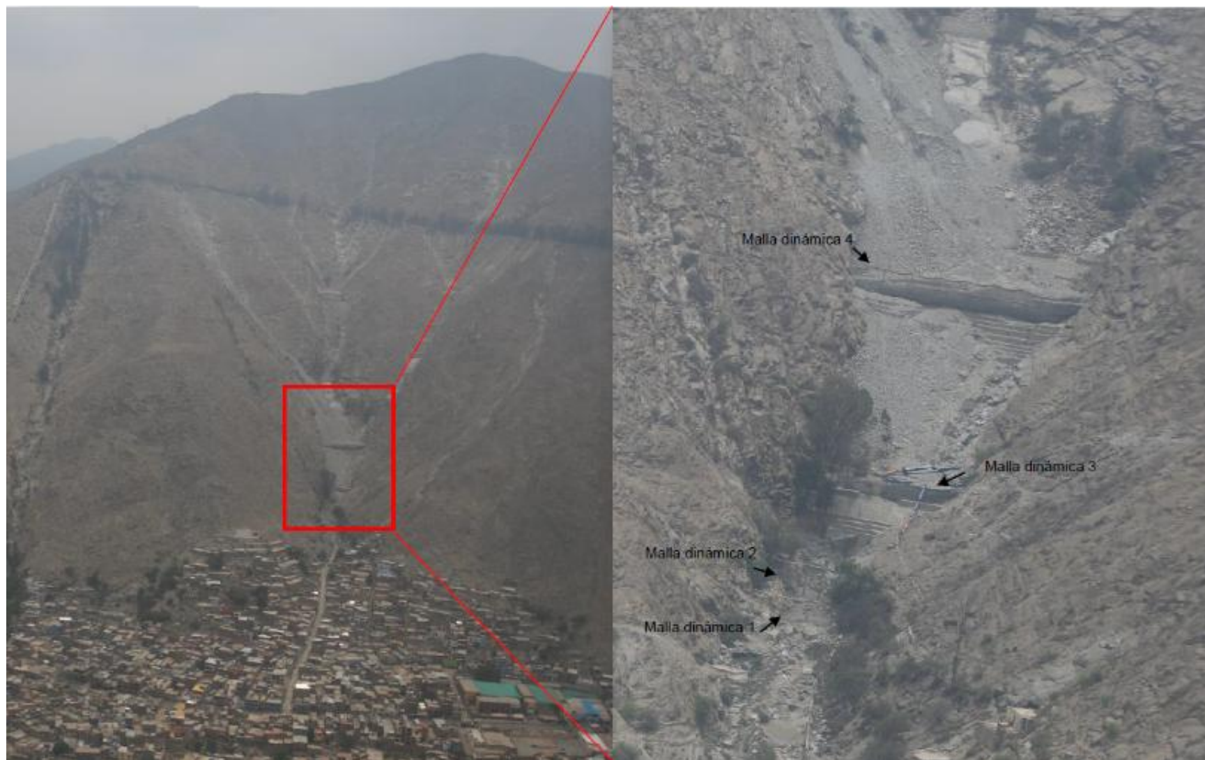
Figura N°11: Fotografía RPAS, Quebrada Carosio. Se observa la colmatación de las barreras dinámicas.
