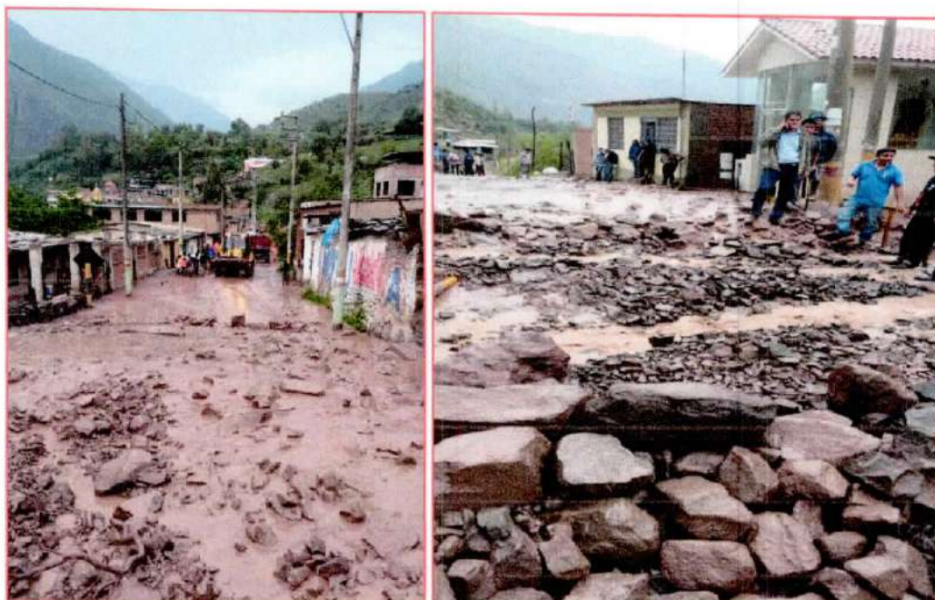
Fotografía 9. Activación de quebradas en el distrito de Cocachacra
