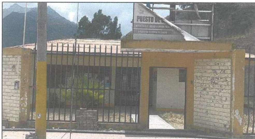
Fotografía 2. Puesto de Salud de Huachupampa
