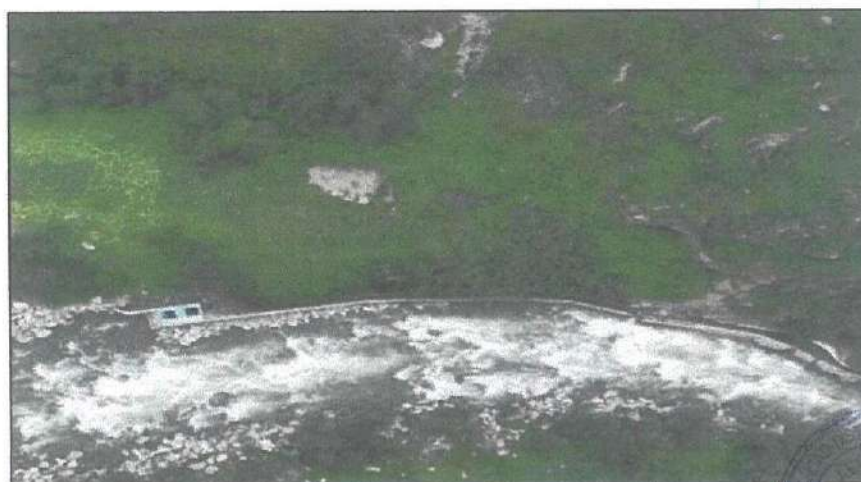
Fotografía 8. Peligro por Huayco, Autisha - Huachupampa
