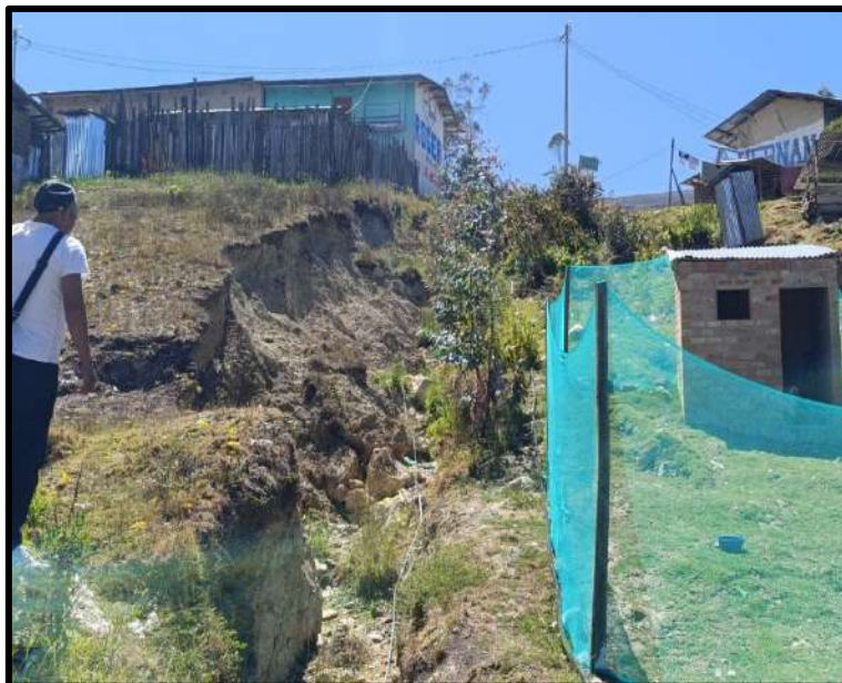
Ilustración 23. Presencia de reptación y deslizamiento del suelo en el centro poblado Colpa.
