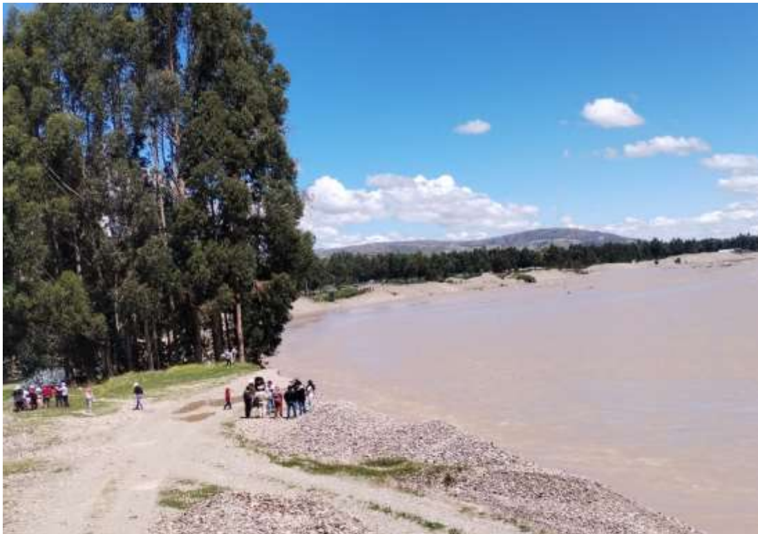
Vista del punto crítico por el borde del rio Mantaro sector Shicchahuaran
