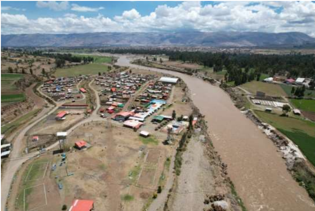
Vista del punto crítico por el borde del rio Mantaro sector Los Puquiales
