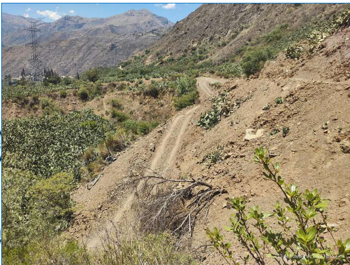
Figura 9: Vista del deslizamiento de Norte a Sur
