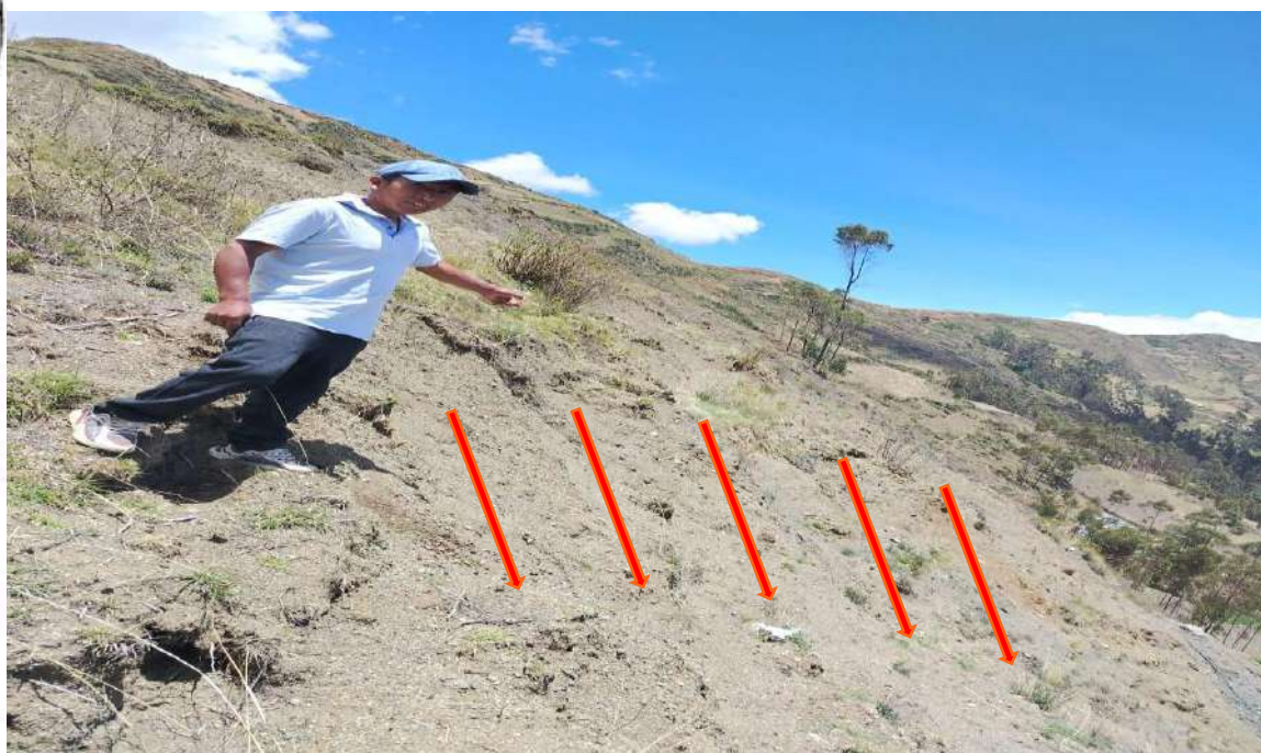
Figura 4: Zona de peligro en la parte superior del caserío de Huellap
