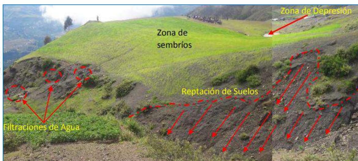
Figura 5: Se Zona de depresión donde se acumula el agua y luego se filtra en suelos
