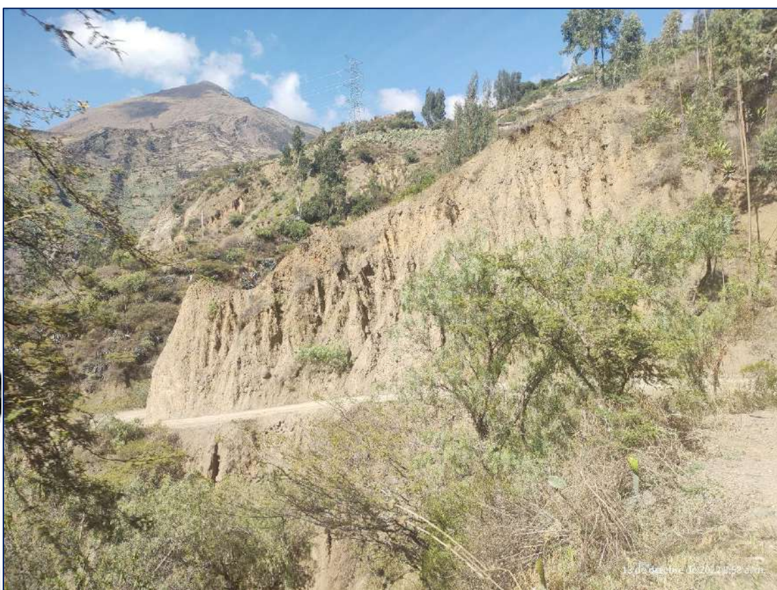
Figura 12: Erosión de laderas, con afectación a la carretera
