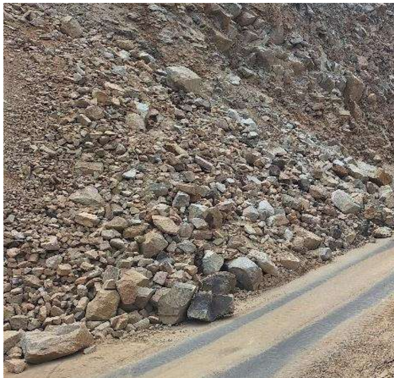
Figura 21 Fotografía del deslizamiento ocurrido en el sector Pasarón
