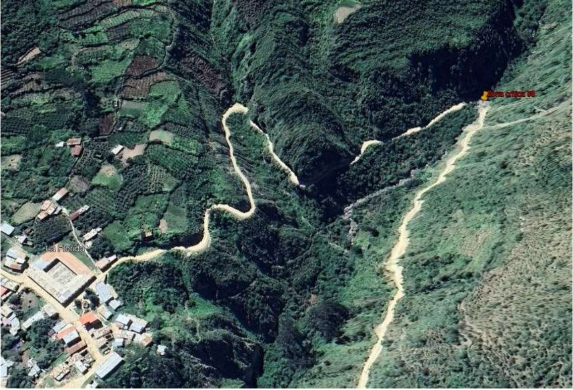
Figura 35 Imagen de la ubicación del sector 08 quebrada Pallcamayo con coordenadas UTM 8749034 N, 304439 E
