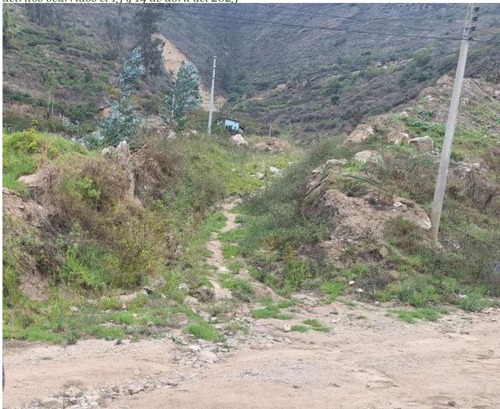
Figura 24 Fotografía de la quebrada Quinchuira y el material disgregado que resultó del flujo de detritos ocurridos el 13 y 14 de abril del 2023
