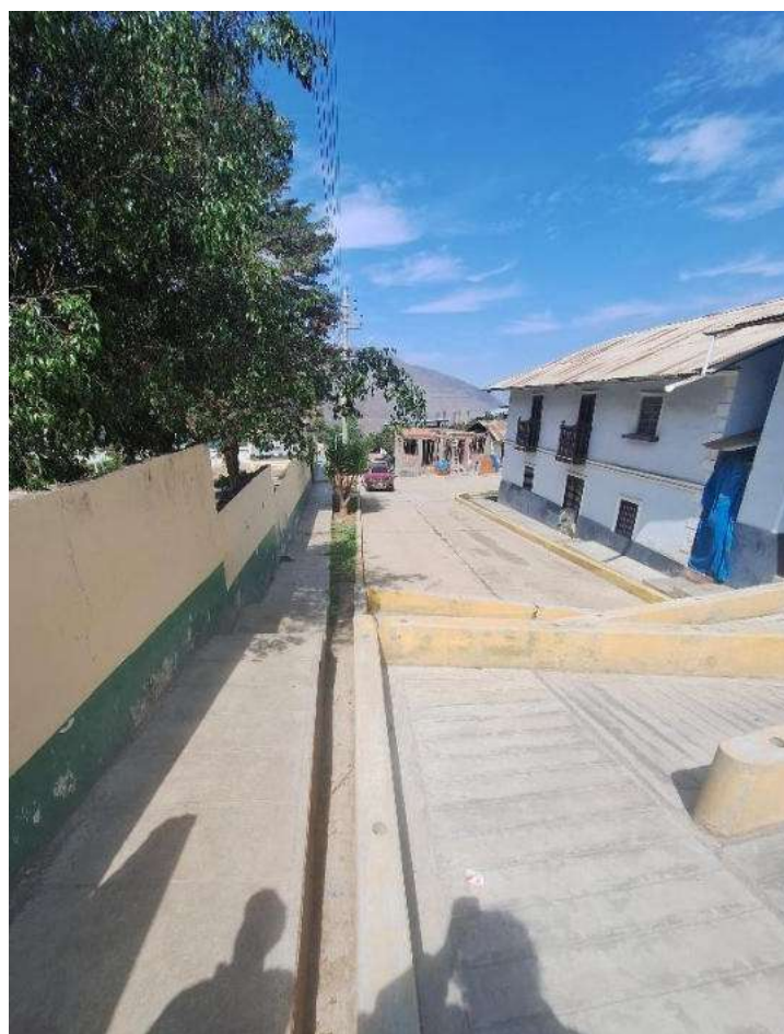
Figura 30 Fotografía del sector del centro poblado San Agustín de Huayopampa asentado sobre la quebrada inactiva Huayopampa
