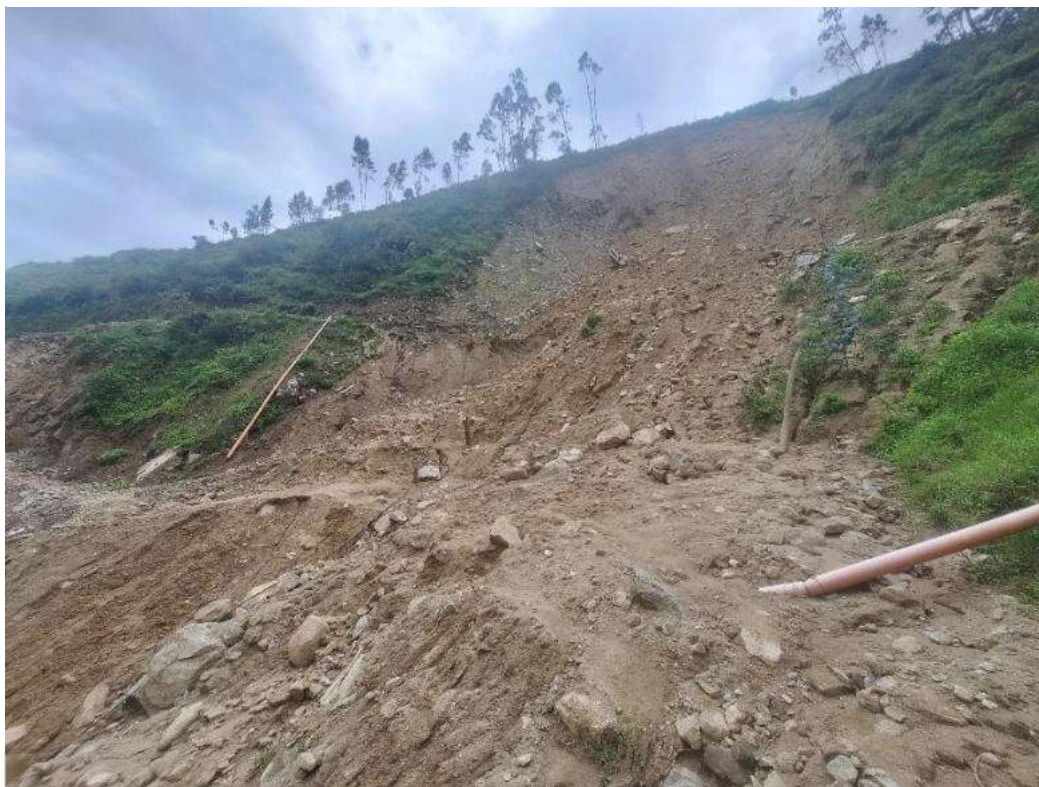
Figura 23 Fotografía del deslizamiento y flujo de detritos ocurrido en el sector de la quebrada Quinchuira
