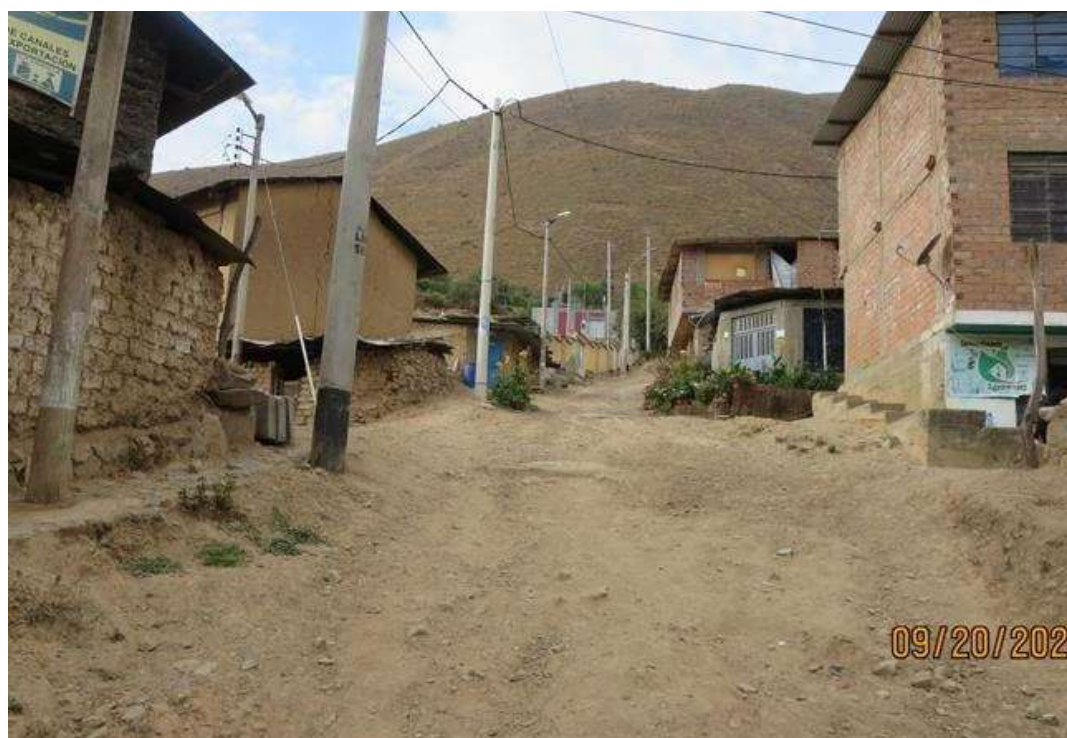
Figura 26 Fotografía del sector del centro poblado San Agustín de Huayopampa asentado sobre la quebrada inactiva Rampe II
