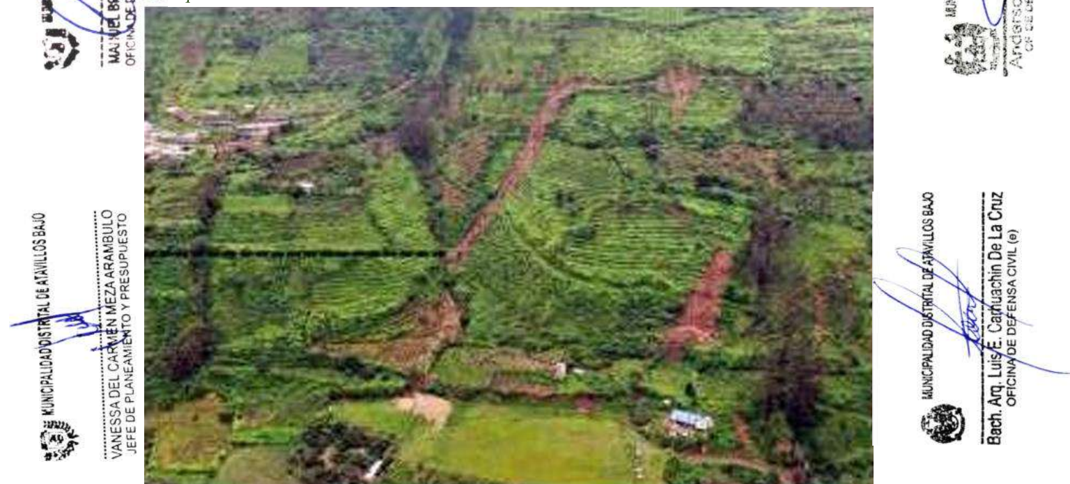
Figura 32 Fotografía del sector del centro poblado La Perla asentado sobre la quebrada inactiva Pichiquillín
