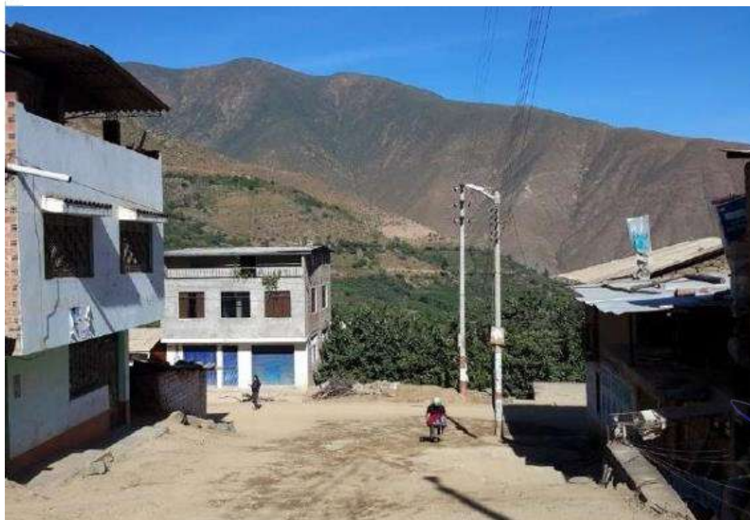
Figura 28 Fotografía del sector del centro poblado San Agustín de Huayopampa asentado sobre la quebrada inactiva Rampe I
