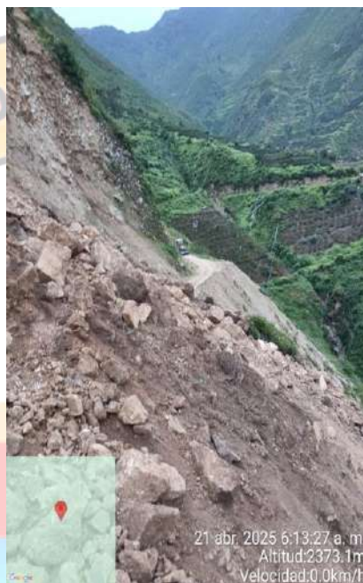
Figura 43 Desastres ocurridos en la zona crítica - El Fraile
