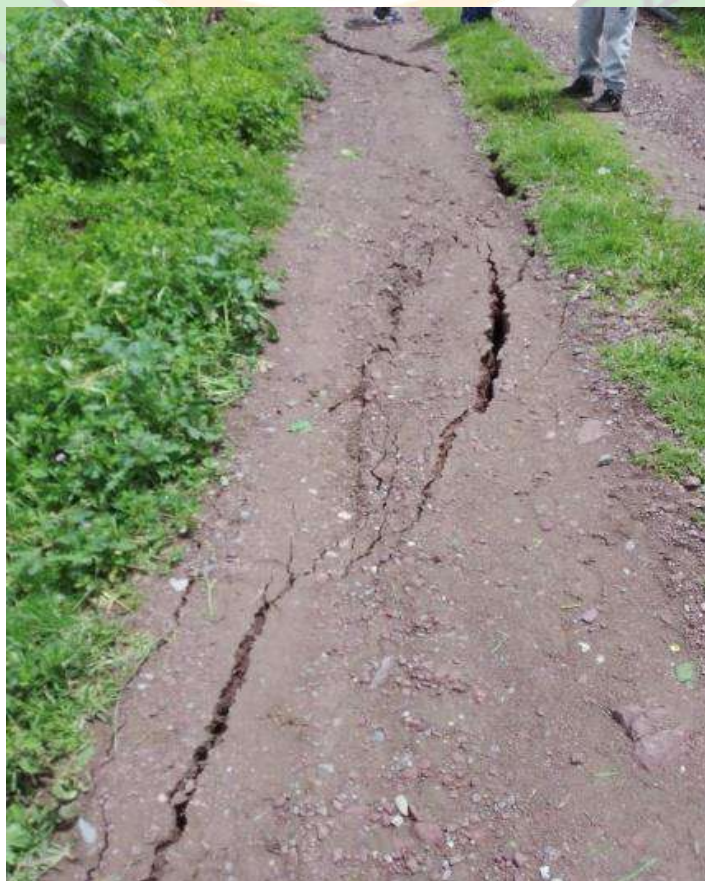
Figura 58 Desastres ocurridos en la zona crítica - Alpamachay
