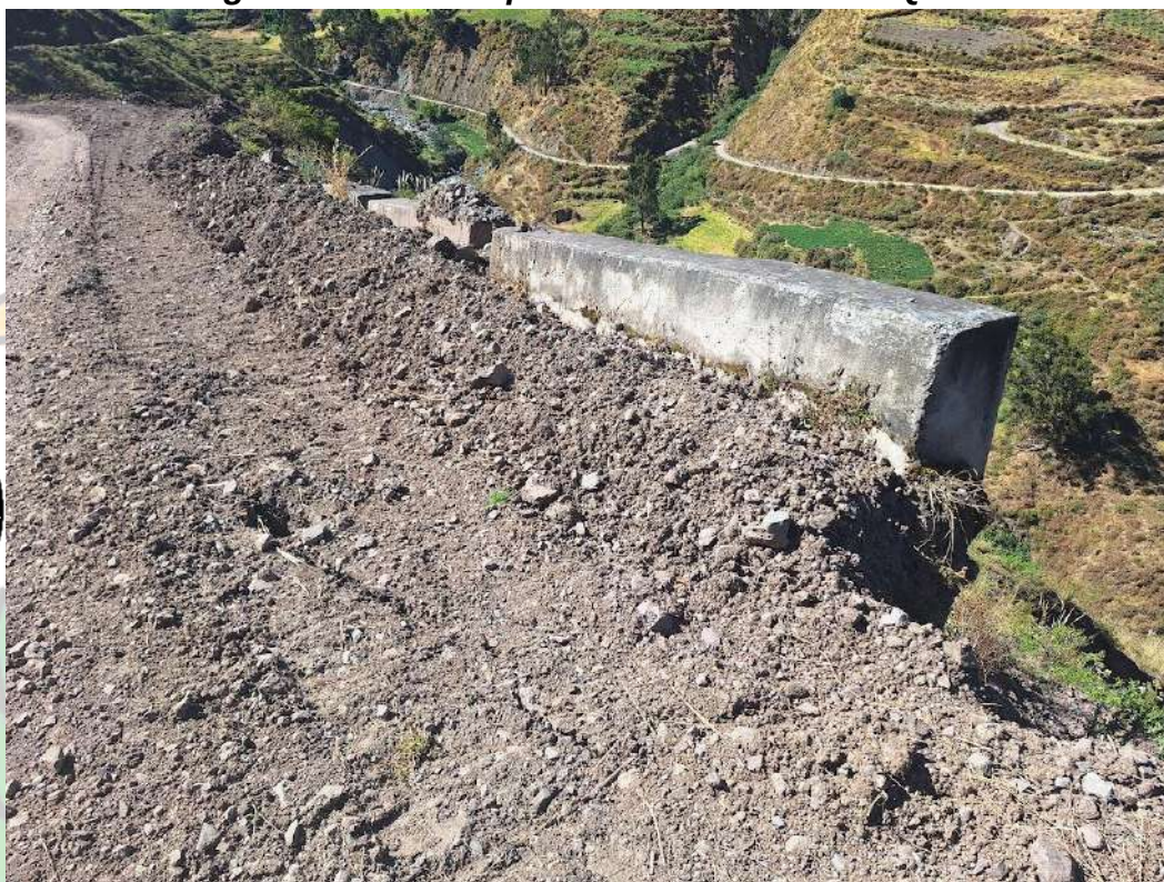
Figura 60 Vista amplia de la zona crítica - Quirma
