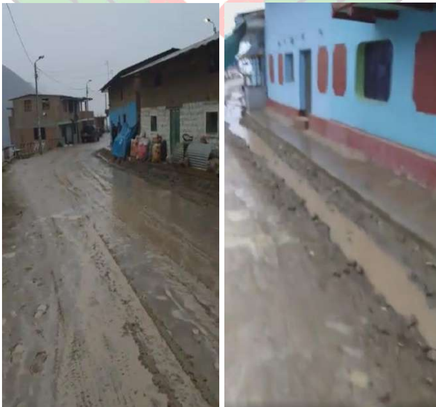
Figura 37 Afectaciones ocurridas en la zona crítica - Pueblo de Paran
