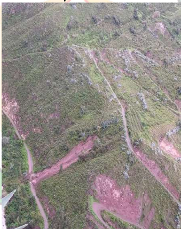
Figura 54 Vista amplia de la zona crítica - Churiac
