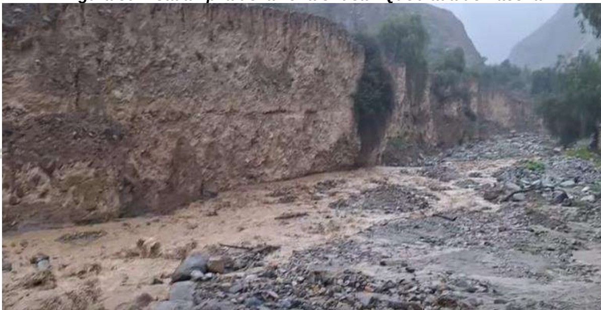
Figura 39 Vista amplia de la zona crítica - Quebrada de Paccha
