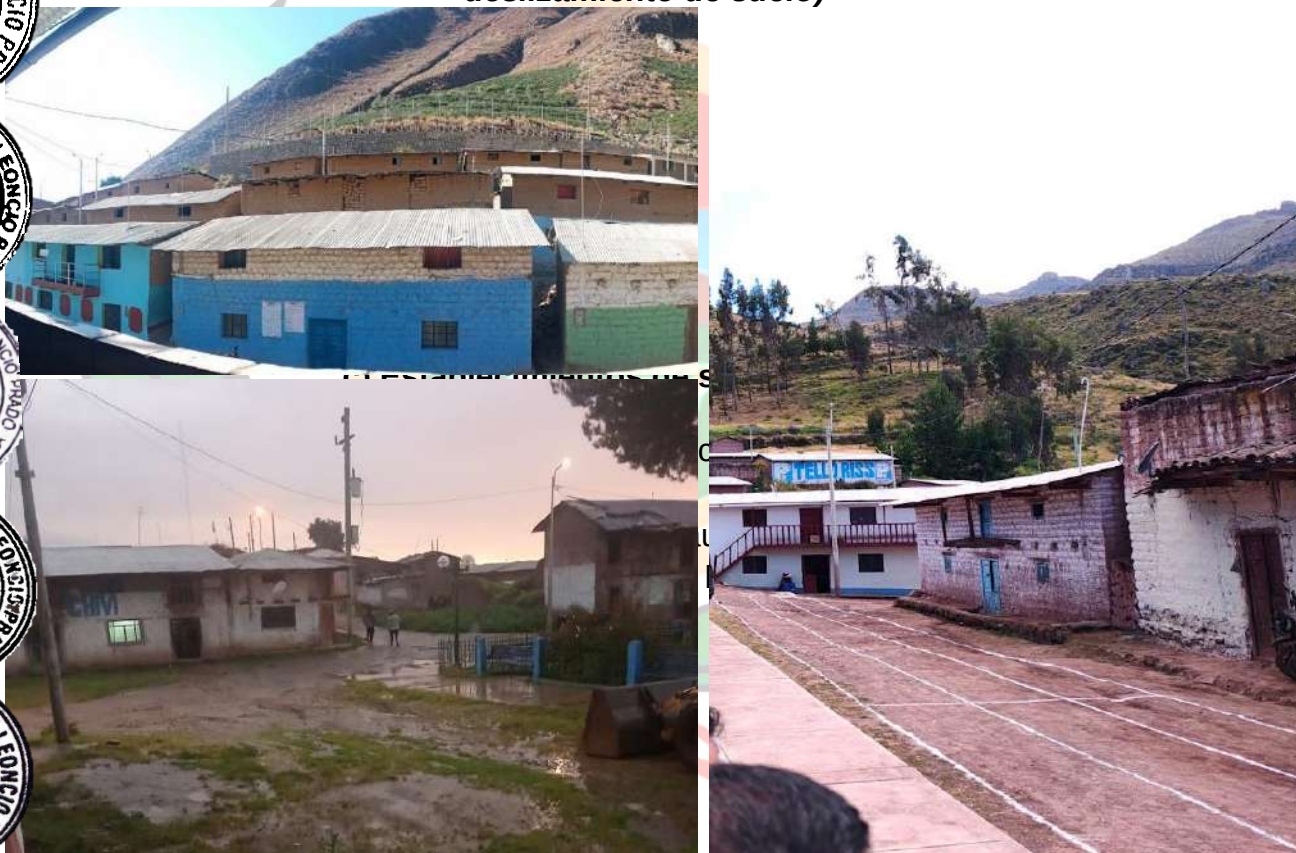
Figura 70 Viviendas expuestas a movimientos en masa (flujo de detritos, lodo, deslizamiento de suelo)
