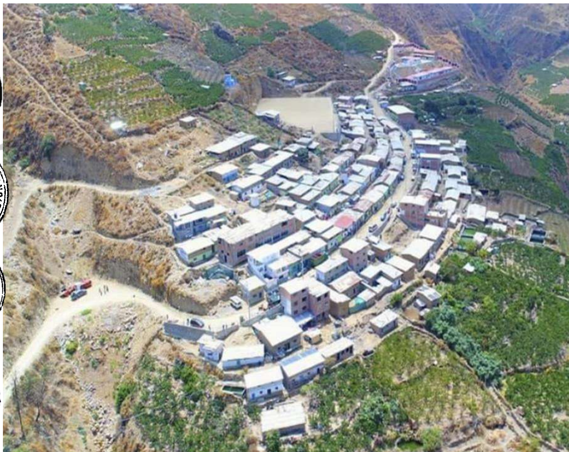
Figura 36 Vista amplia de la zona crítica - Pueblo de Paran
