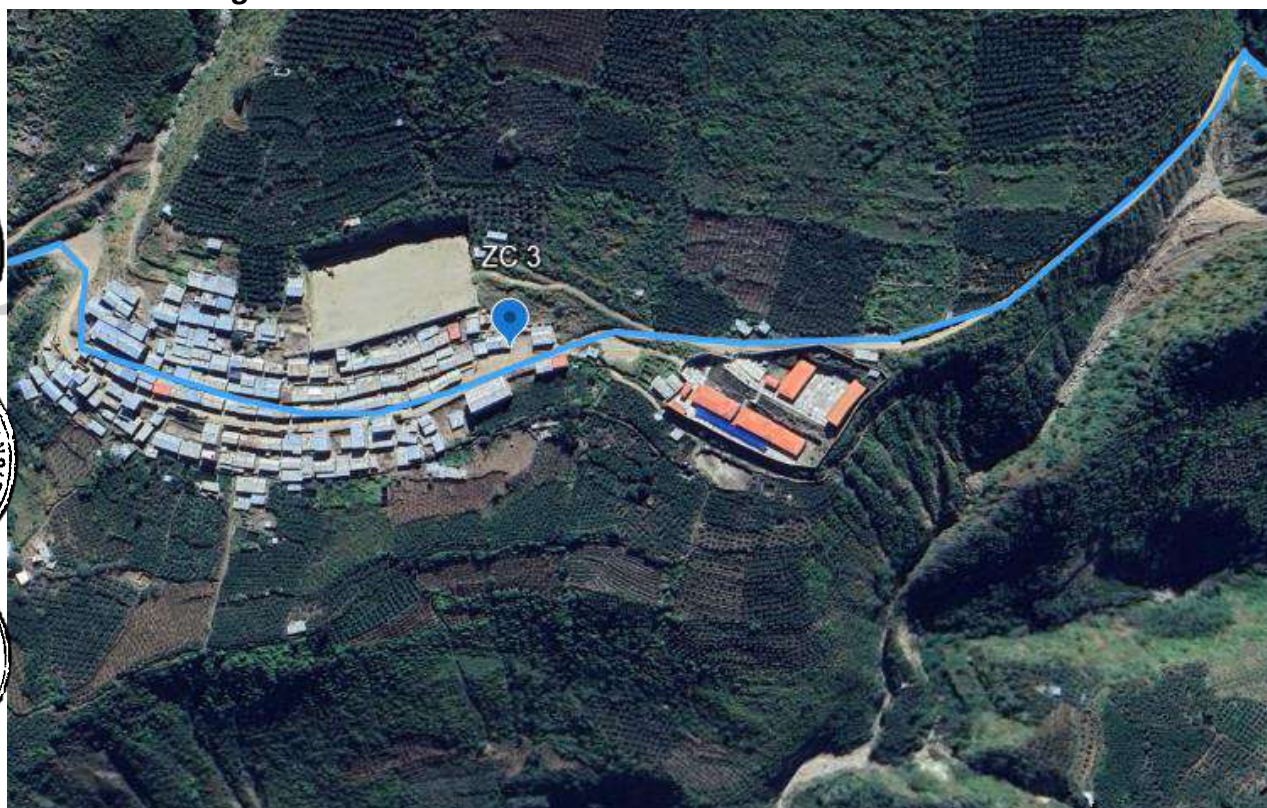
Figura 35 Ubicación de la zona crítica - Pueblo de Paran
