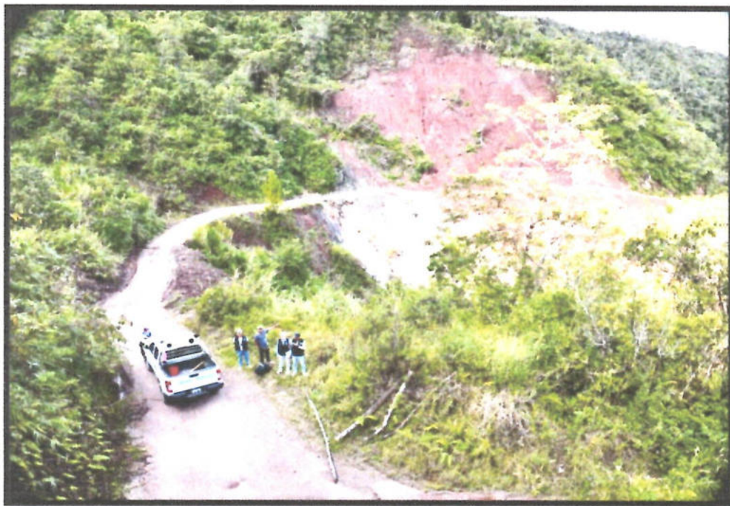
Foto N° 27: Equipo técnico en el sector La Suiza Alta
