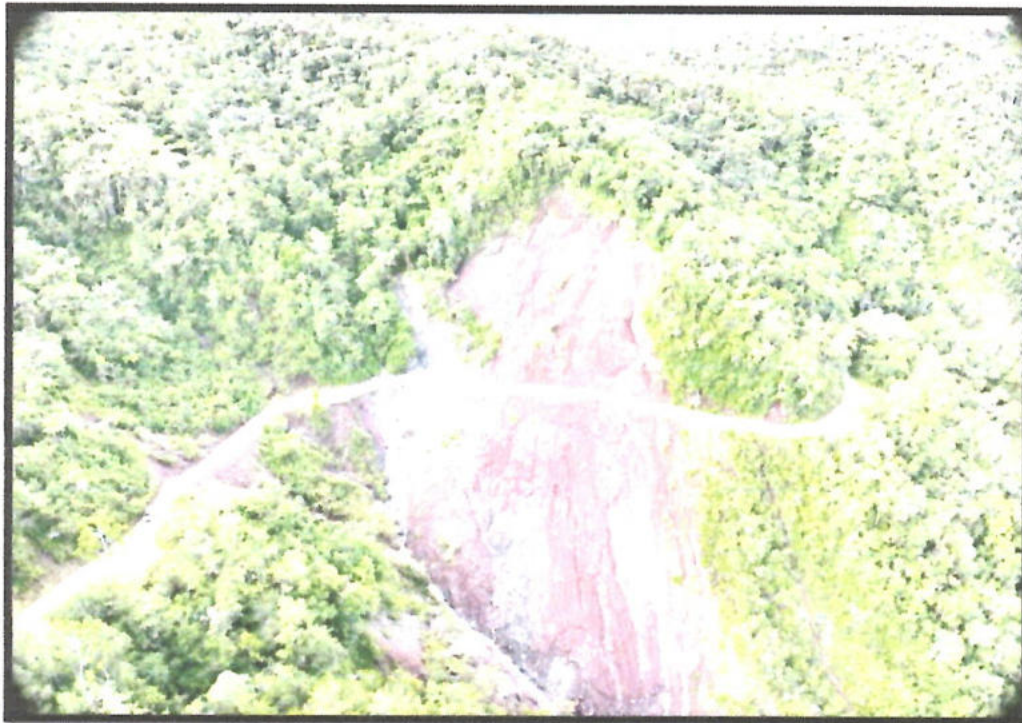
Foto N° 25: Vista aérea del estado de la carretera al sector La Suiza Alta
