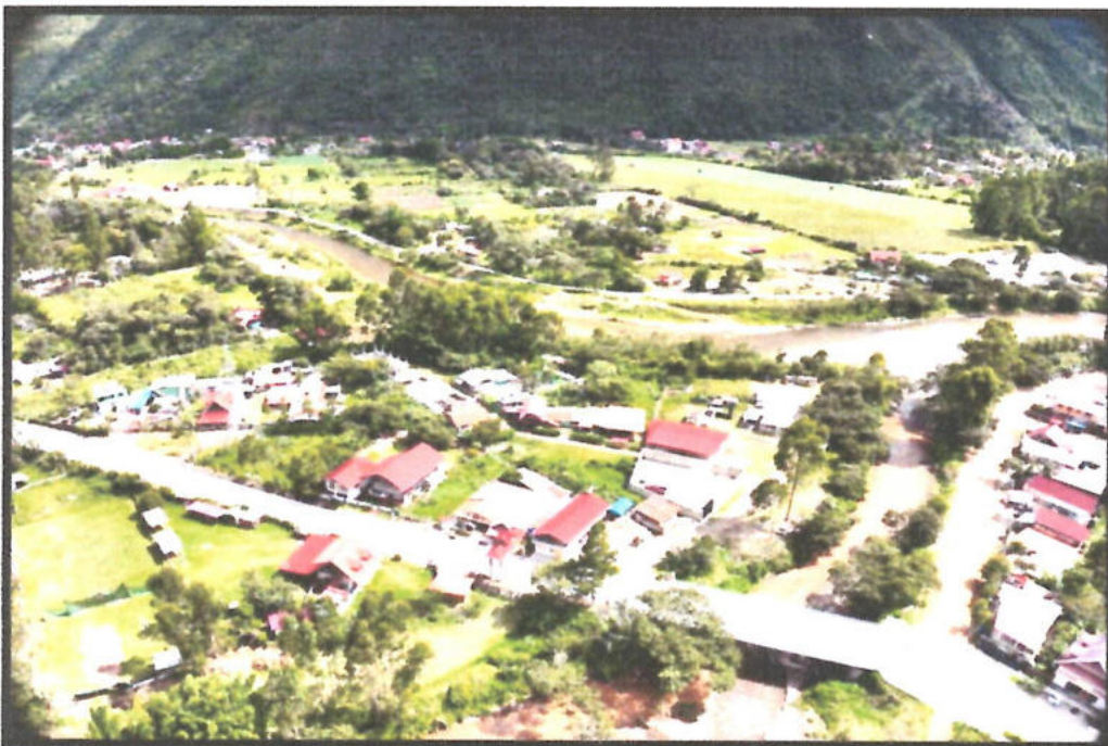
Foto N° 20: Vista aérea de las quebradas Llamaquizu, esperanza y rio Chorobamba
