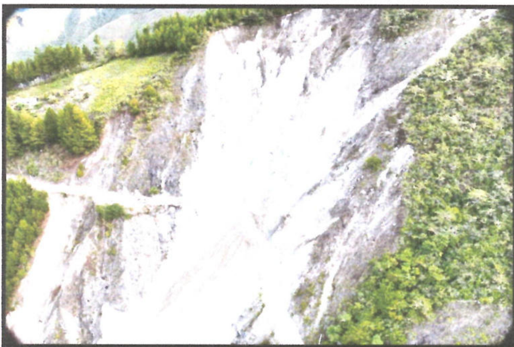
Foto N° 29: Vista aérea del estado de la carretera al sector Torrebamba
