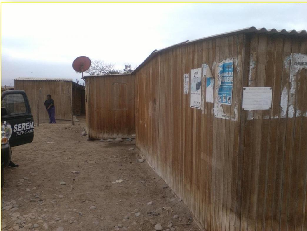
*Se puede apreciar los módulos de madera en el sector mencionado, los cuales cuentan con techo de calamina, los cuales no serían la protección suficiente ante esta próxima temporada de lluvias intensas.*
