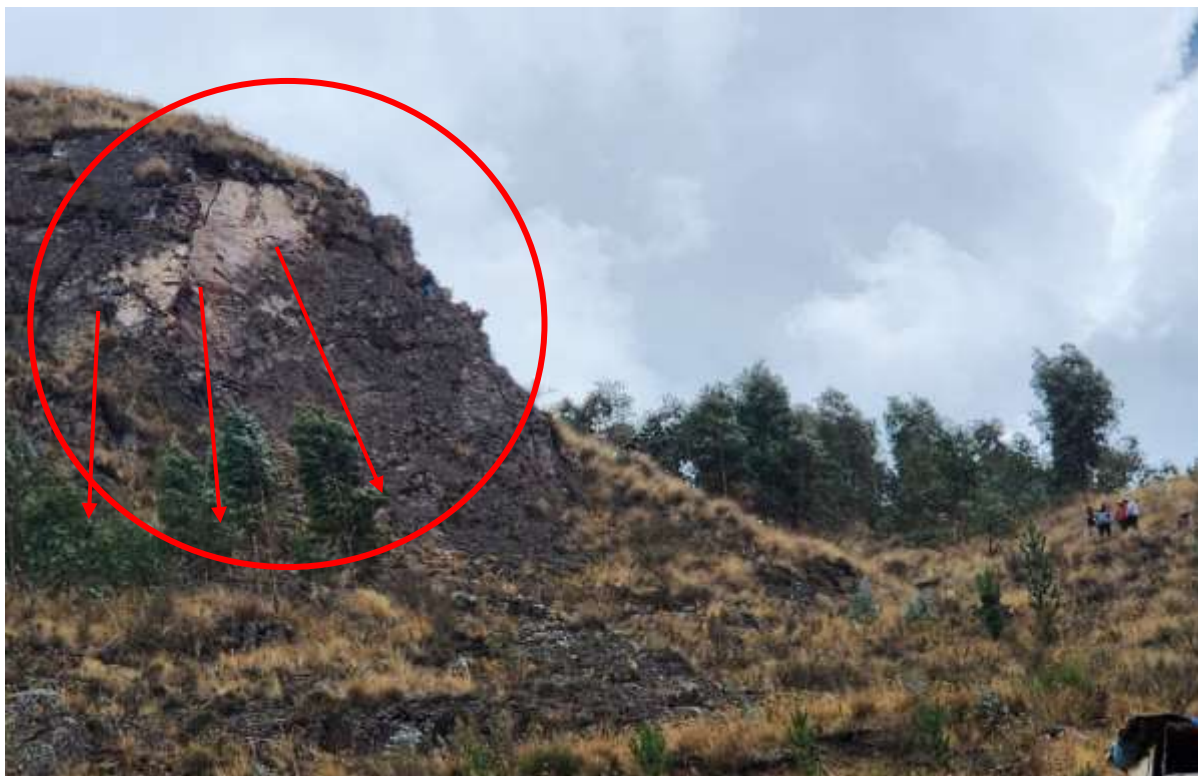
Imagen 04: Se visualiza la roca que se encuentra en desprendido y también se encuentra rajaduras.
