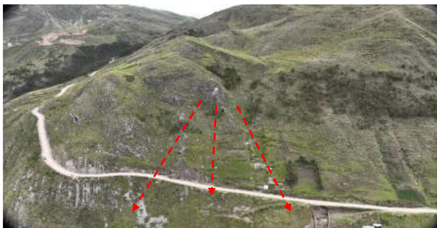
Fotografía 5. Zona de deslizamiento y caída de rocas.
