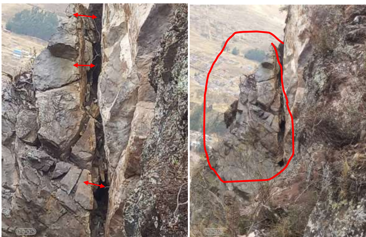
Imagen 05: Se visualiza la separación de la roca donde se encuentra expuesta a una caída afectando a las viviendas y las personas que se encuentran en la parte baja.
