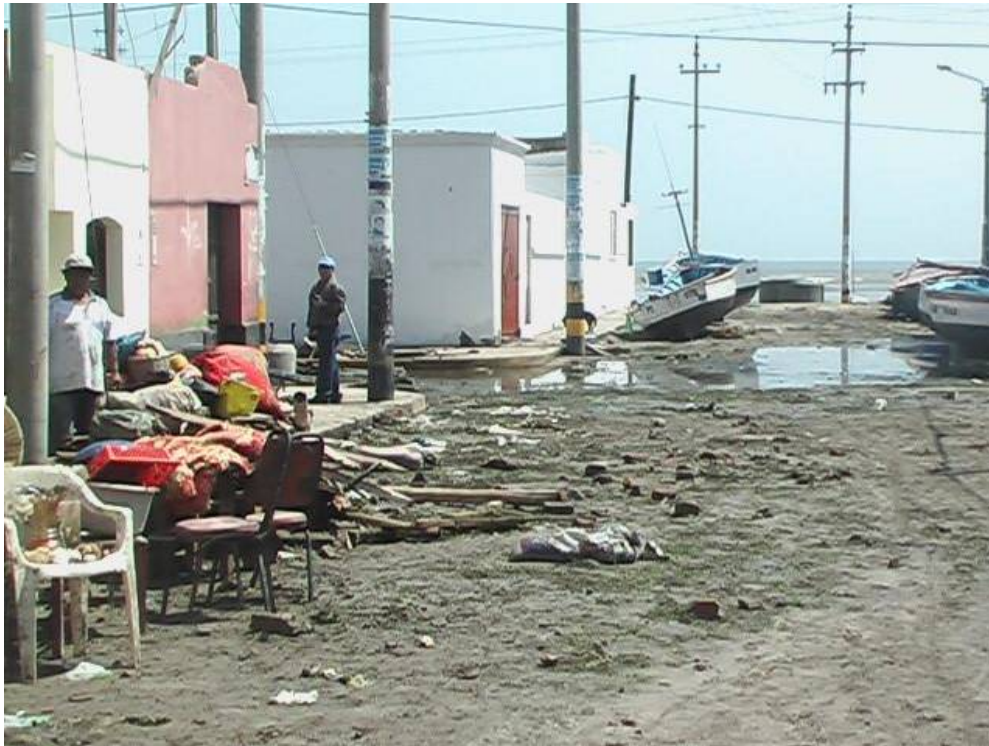
Daños ocasionados a los pobladores en las zonas costeras de Pisco (Sismo año 2007). Fuente: DHN, 2010.
