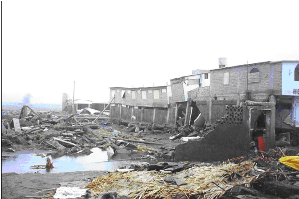
Balneario de "La Punta Vieja", en Camaná: se observa la inundación dejada por el tsunami y el colapso de la cimentación de las viviendas. Fuente: DHN, 2010
