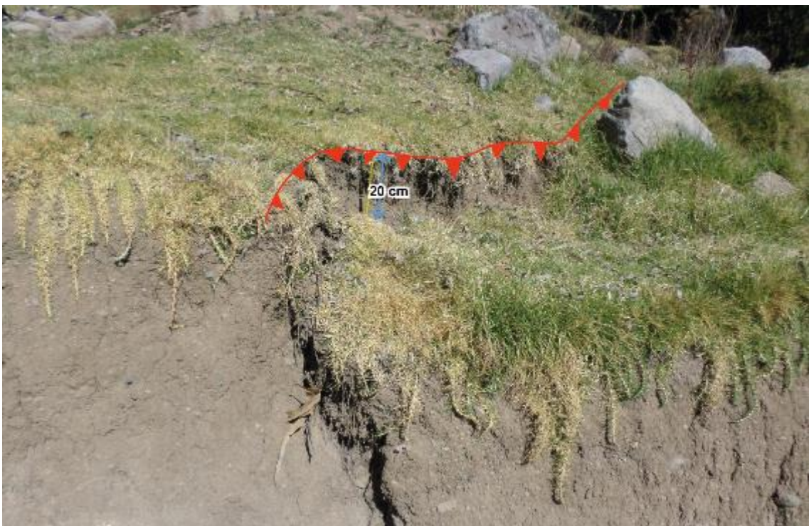
Figura 8: Agrietamientos con aberturas entre 5 cm, presenta desnivel de 20 cm en terrenos de pastizales, dentro del cuerpo del deslizamiento en proceso de reactivación.
