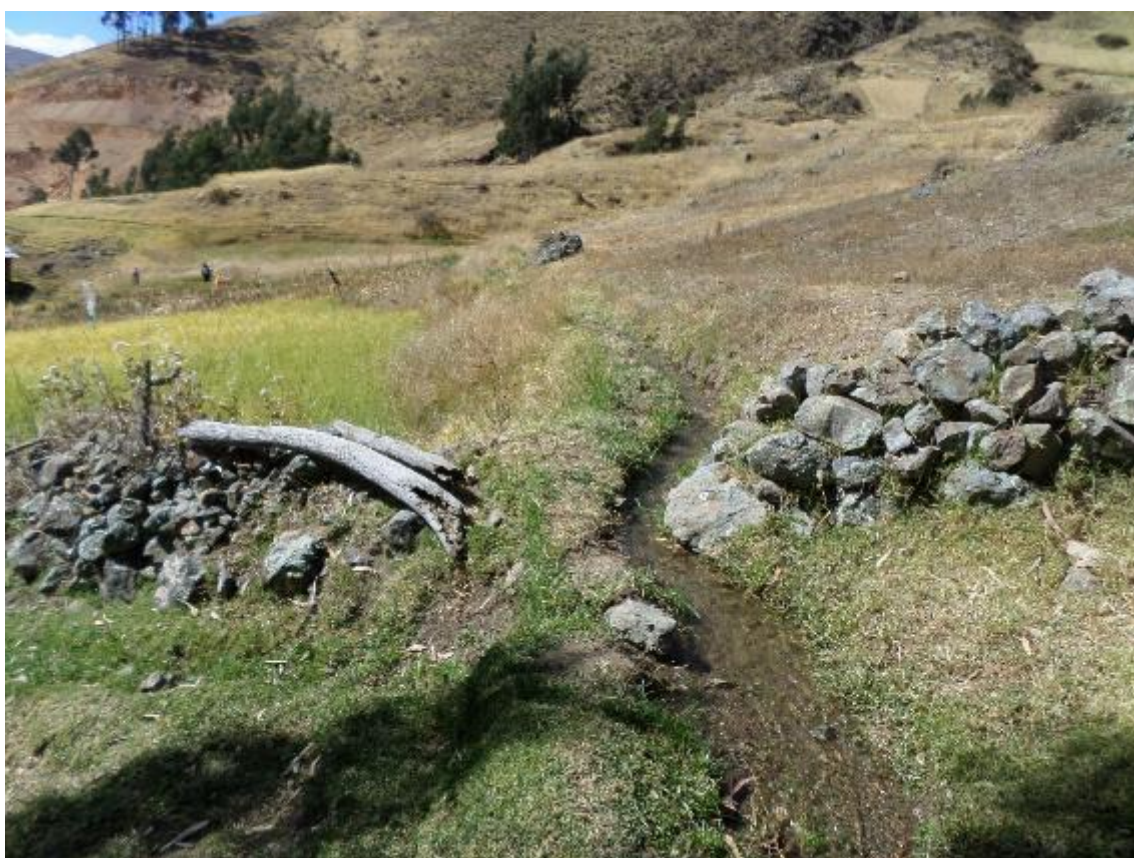
Fotografía 8 y 9: Vista de canales de riego rústicos no impermeabilizados distribuidos en el cuerpo del deslizamiento antiguo.
