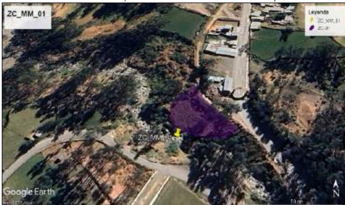
Ilustración 7: Zona Crítica por deslizamiento en el sector Tavin del distrito de Cajatambo.
