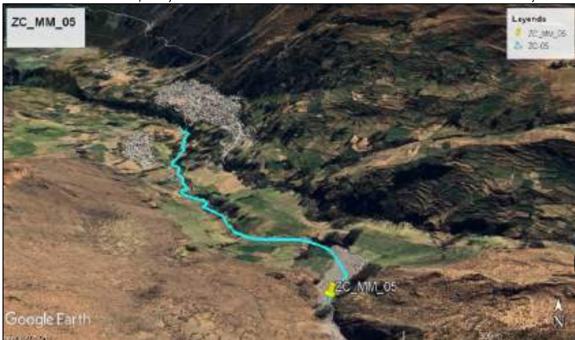
Ilustración 15: Zona crítica por flujo de detritos en el sector Macanacota - Puente Cuchichaca del distrito de Cajatambo.
