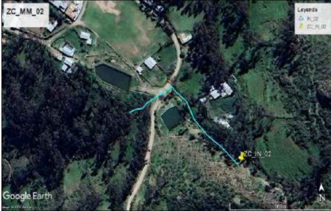
Ilustración 29: Zona crítica por inundación fluvial en el sector Utcas del distrito de Cajatambo.
