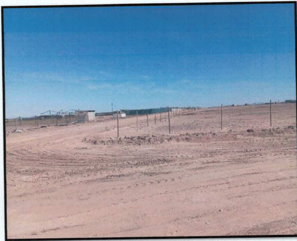
Fotografía 05: De la visita a campo se ha observado que no existen peligros como deslizamiento o flujos de detritos
