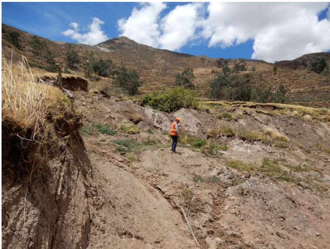
Fotografía 5. Corona del deslizamiento activo. Presenta forma semicircular.
