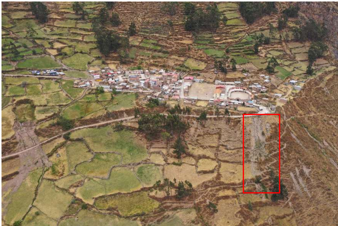
Figura 15. Vista de derrumbe producido en la ladera suroeste de Santa Catalina, debajo de la trocha que conduce a dicho poblado.
