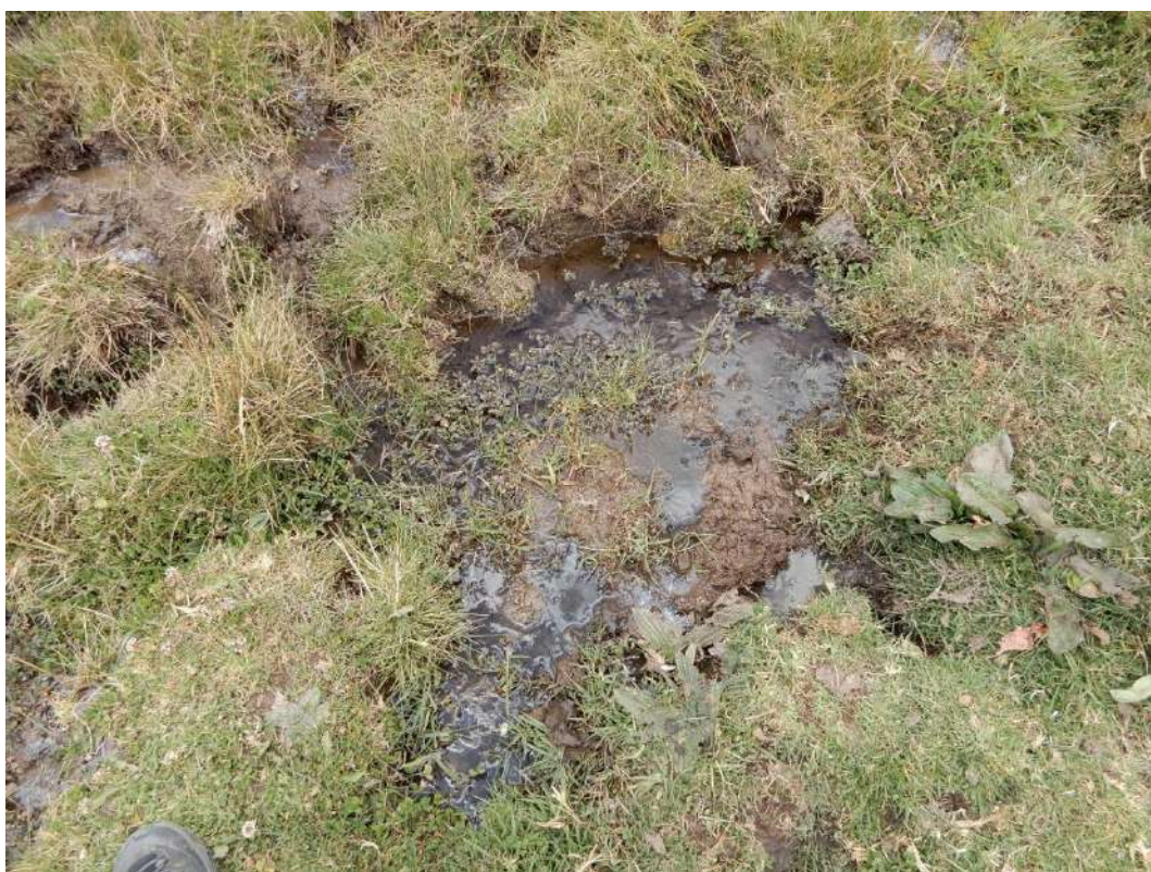
Fotografía 6. Almacenamiento de agua al pie del escarpe del deslizamiento - flujo.
