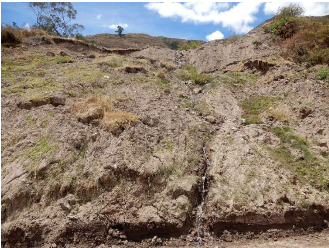
Fotografía 7. El agua proveniente de la parte alta, discurre ladera abajo por el cuerpo del deslizamiento - flujo.
