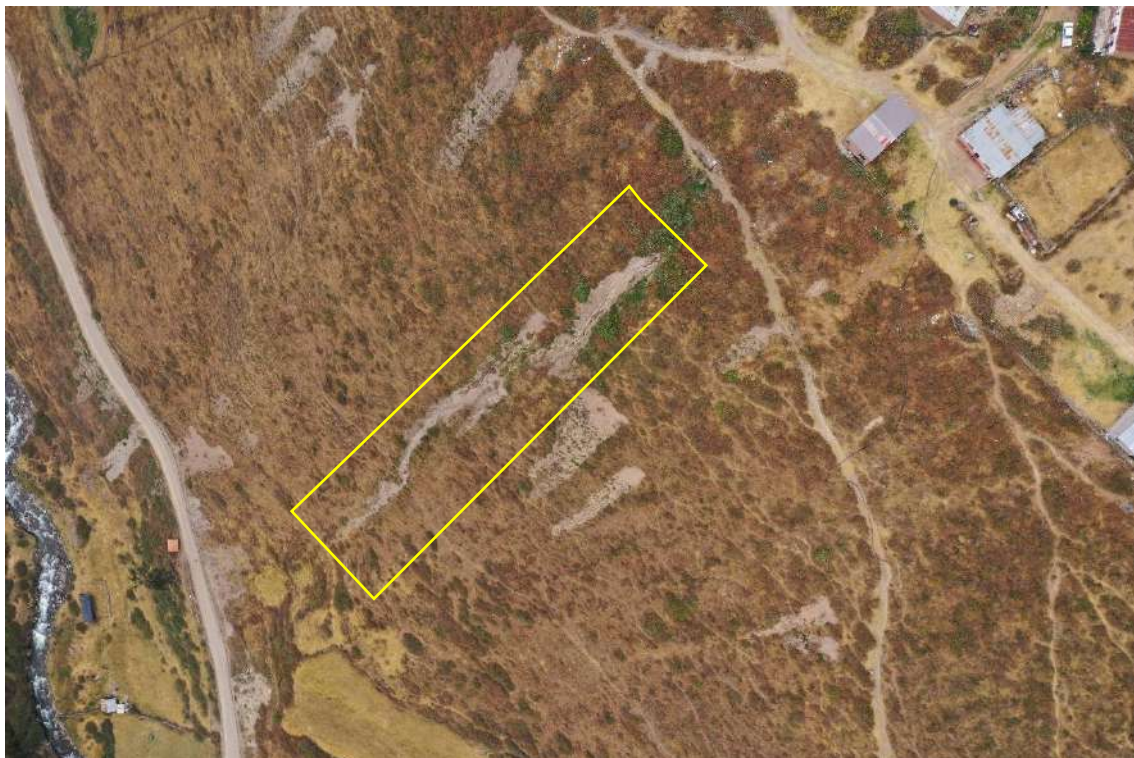
Figura 16. Vista de derrumbes desencadenado por la presencia de surgencias de agua.
