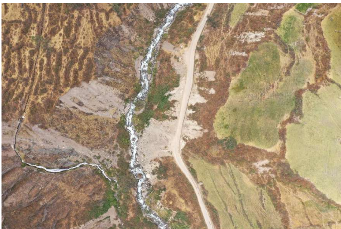
Fotografía 9. Derrumbes producidos en la parte baja de Santa Catalina.
