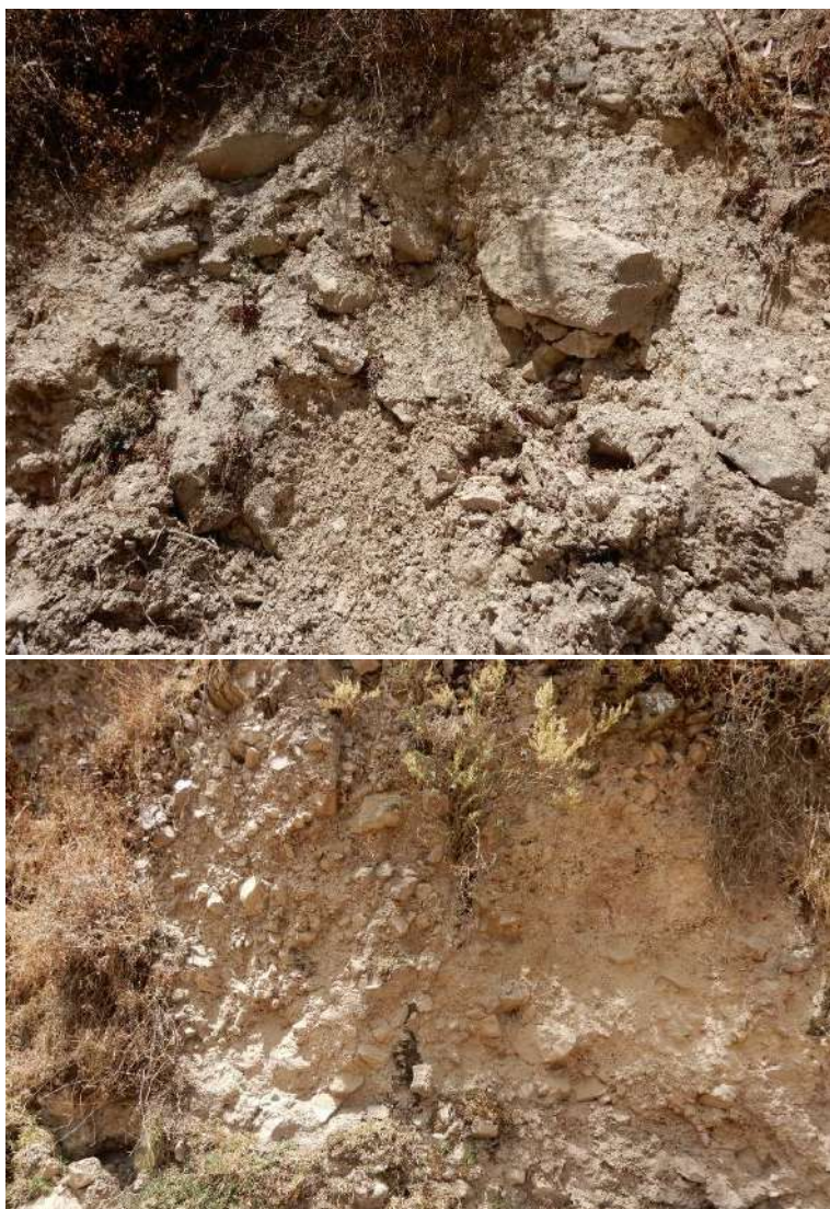
Figura 5. Depósito coluvio deluvial conformado por bloques, gravas, arenas, limos y contenido de arcillas, que se formó producto de la ocurrencia del deslizamiento en la comunidad campesina Santa Catalina.
