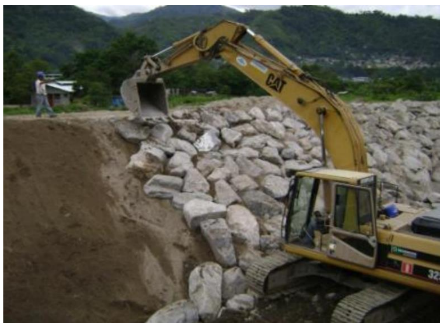
Figura 2.4. Protección de riberas mediante enrocados.
