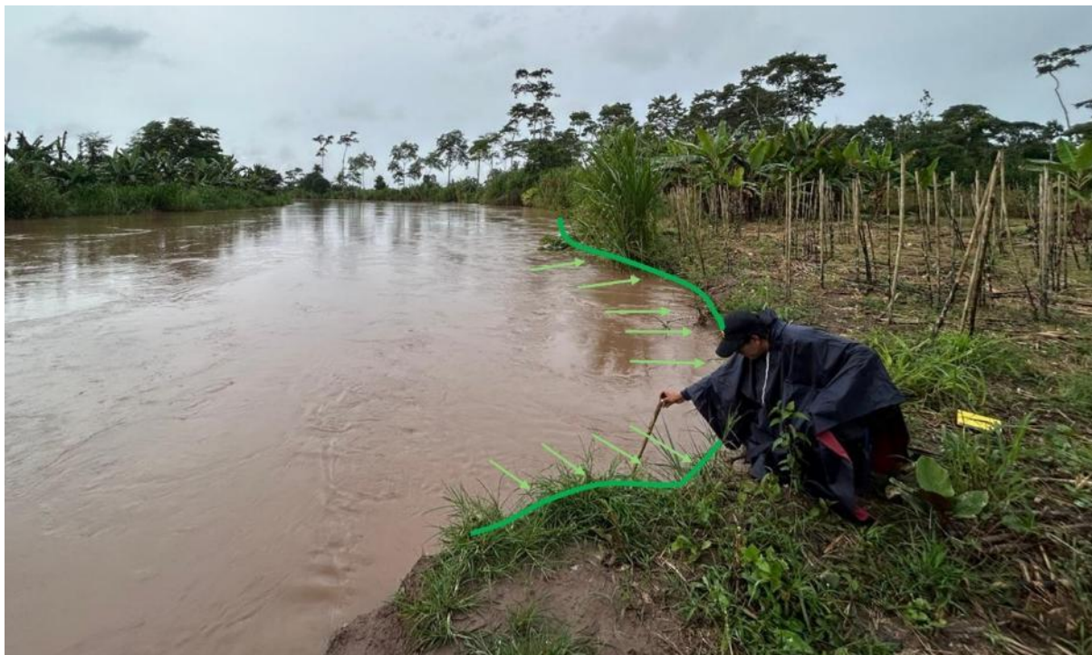
Figura 18. Proceso de erosión fluvial en la margen derecha del río Tonchima. Coordenadas UTM E: 262335; N: 9336444.
