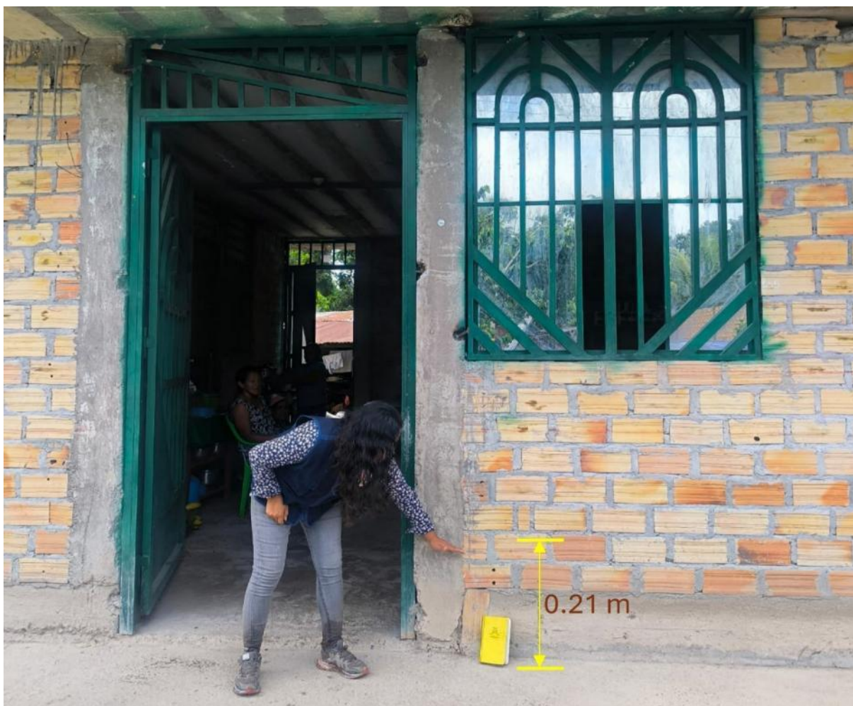
Figura 19. Vivienda afectada por la inundación ocurrida el año 2022, la altura del agua en este punto alcanzó los 0.21m.
