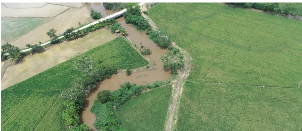
Fotografía 5. Quebrada Tangumi (≈17m de ancho), se desborda en épocas de lluvias afectando a la población de Faustino Maldonado. Coordenadas UTM E: 263675; N: 9336379
