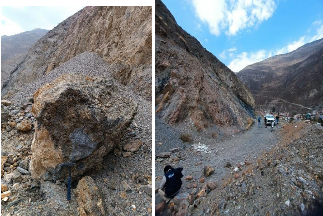
Figura 21. Izquierda: Bloque rocoso de aproximadamente 1.5 m de diámetro compuesto de arenisca que obstruye la vía. Derecha: Bloques de caída de rocas recientes.
