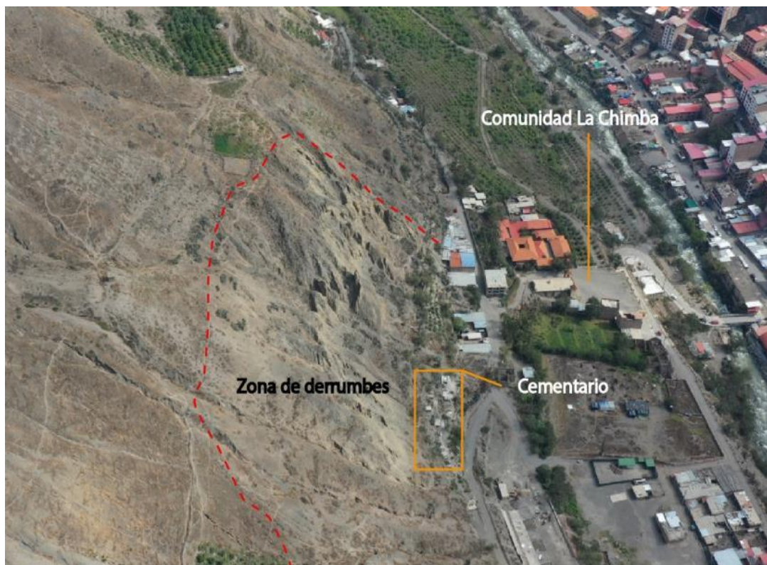
Figura 20. Derrumbe identificado sobre la comunidad La Chimba que afecta directamente al cementerio de la comunidad, así como también a ciertas viviendas.
