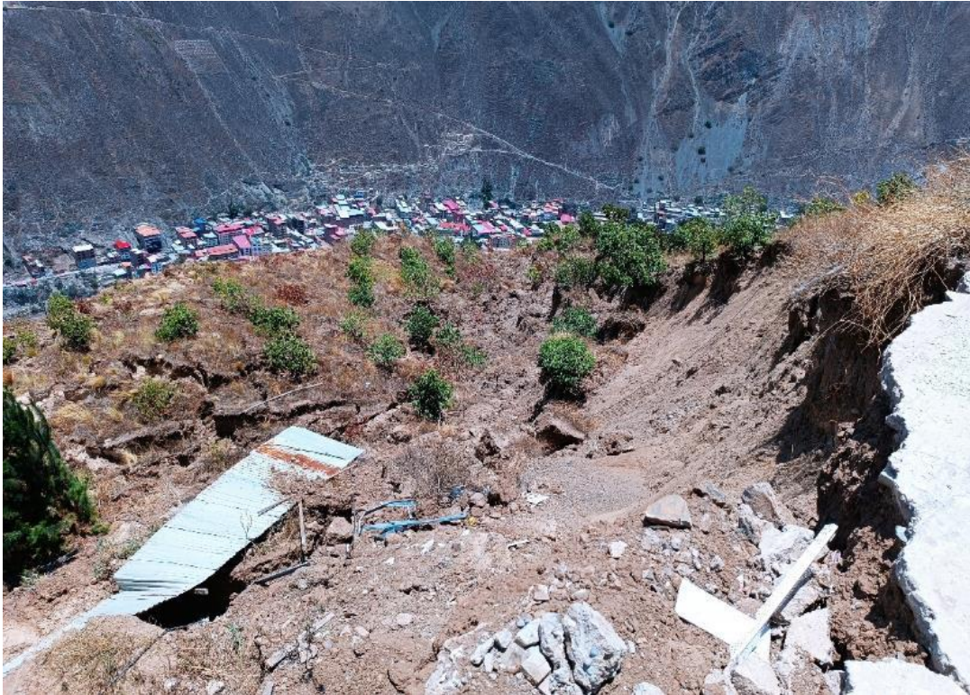
Fotografía 4. Terrenos de cultivo de palta afectados por el deslizamiento – caída de rocas en el sector Yesojurgunan. Coordenadas UTM 8804491 N; 294288 E.
