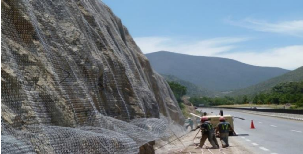
Fotografía 1. Mallas de protección con anclajes para caída de rocas o derrumbes tanto en detritos como roca alterada.
