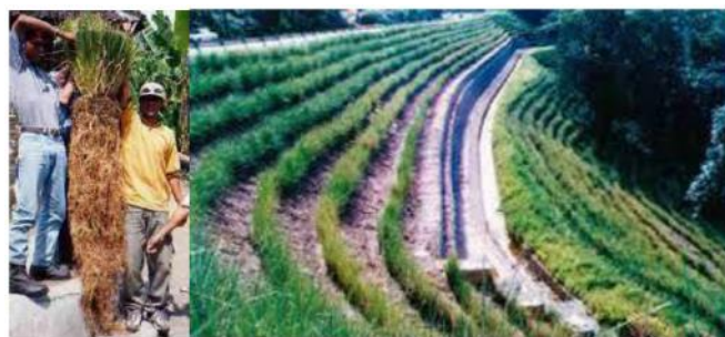
Figura 12. Izquierda: Estabilización de taludes mediante revegetación.
