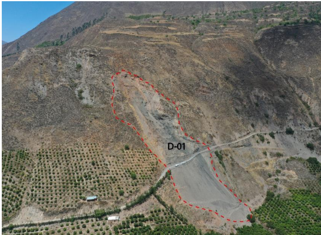
Figura 15. Vista aérea del deslizamiento D-01, en el sector Wasurumi. Se observan plantaciones de palta hacia los márgenes y pie del deslizamiento, así como también la vía La Chimba – Andajes que atraviesa dicho deslizamiento.
