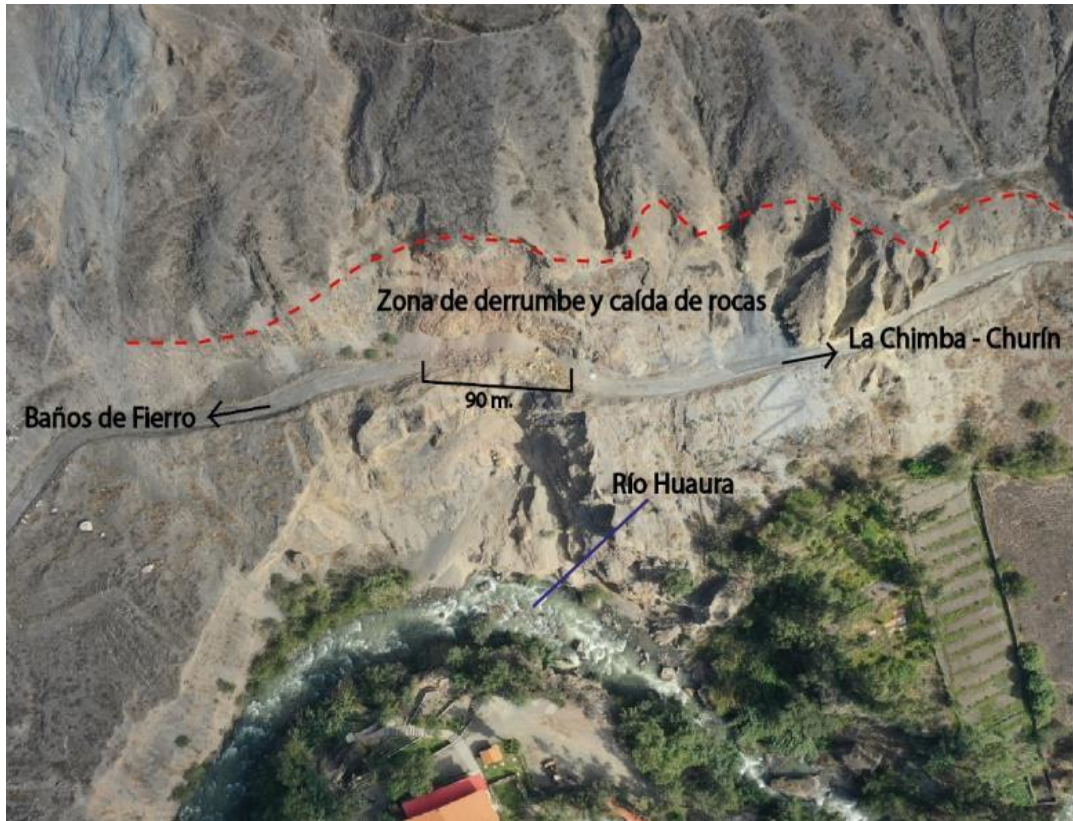
Figura 19. Derrumbes y caída de rocas que afecta un tramo de 90 m. de la vía hacia los baños termales de Fierro.
