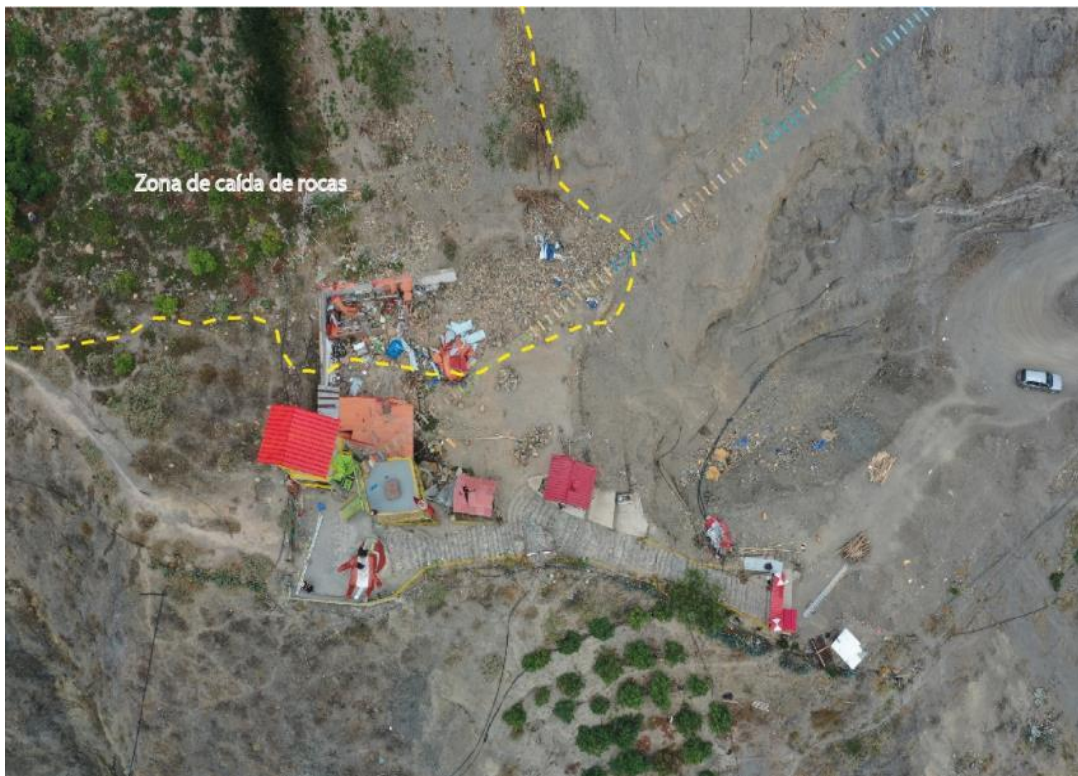
Figura 22. Vista aérea de afectación de caída de rocas en el mirador turístico y sembríos de palta en el sector de Siverapata.
