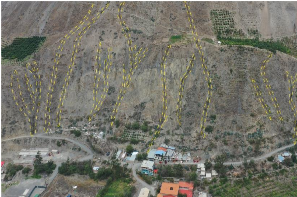
Figura 25. Erosiones en cárcava sobre la Comunidad La Chimba
