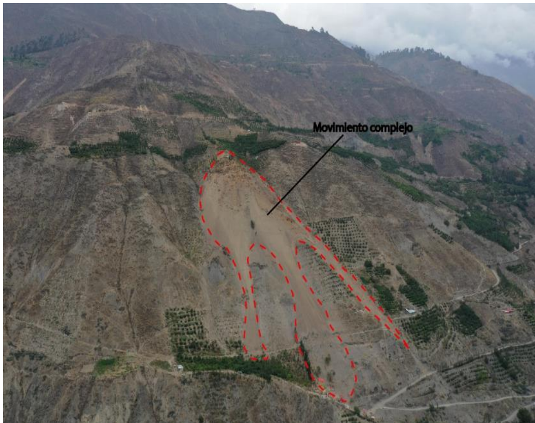
Figura 21. Vista aérea del movimiento complejo afectando los sectores de Yesojurgunan y Siverapata.
