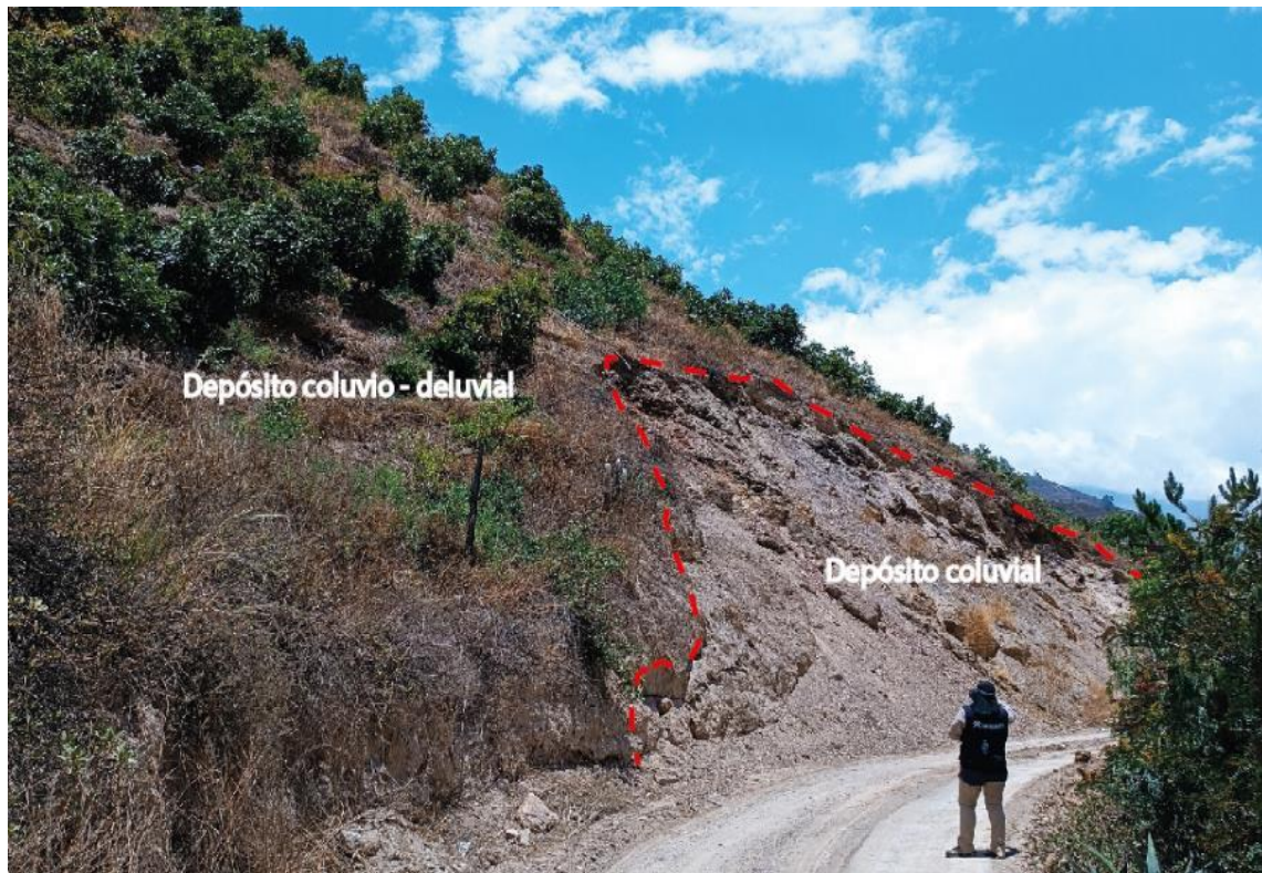
Figura 10. Detalle de depósitos coluvio-deluviales usados para sembríos de palta. Como consecuencia, se tiene un deslizamiento (depósito coluvial) que afecta la vía La Chimba - Andajes.
