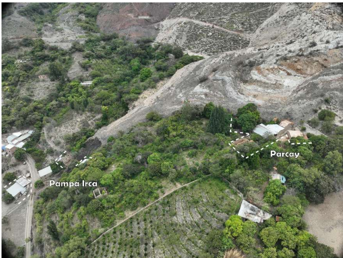
Figura 09. Comportamiento tipo flujo lento al pie del evento, afectando viviendas de los sectores de Parcay y Pampa Irca.
