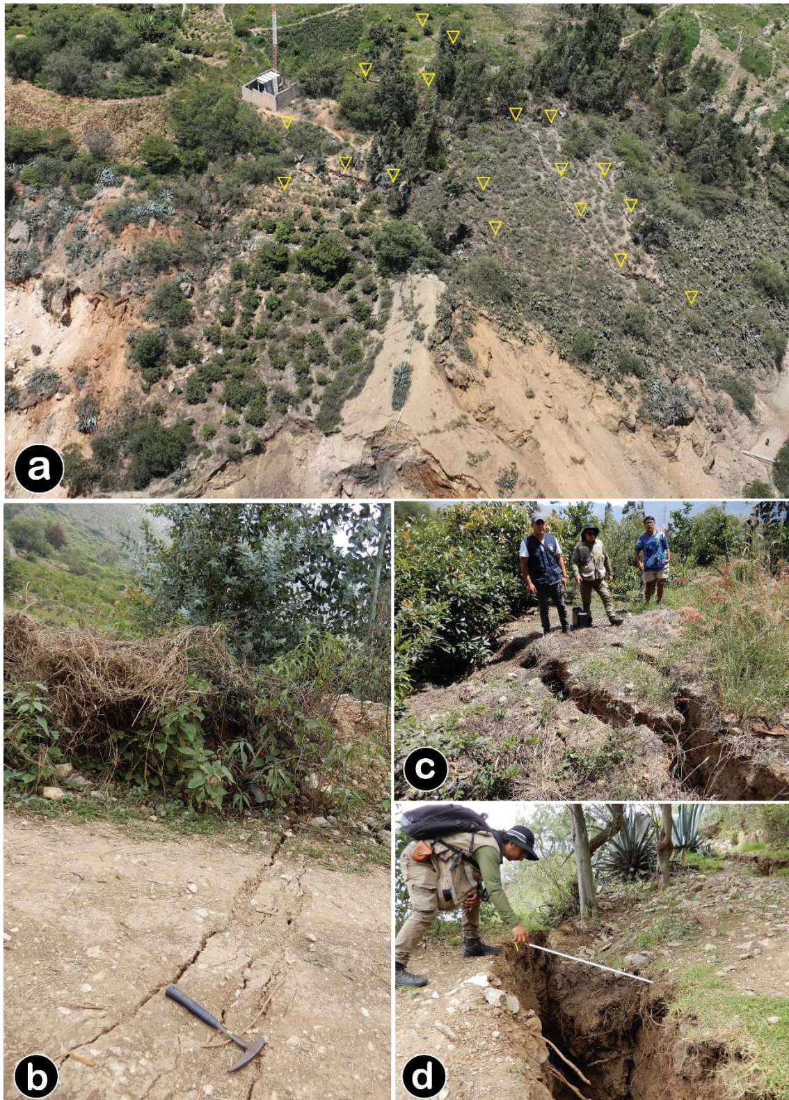
Figura 11. a. Múltiples agrietamientos subparalelos al escarpe principal, señalados con un triángulo amarillo. b. Agrietamientos en la carretera. Coordenadas UTM: 181947 / 9033766, Zona 18. c. Agrietamientos en zonas de cultivo. Coordenadas UTM: 181788 / 9033910, Zona 18. d. Agrietamiento con aberturas de hasta 1.2 m. Coordenadas UTM: 181841 / 9034259, Zona 18.
