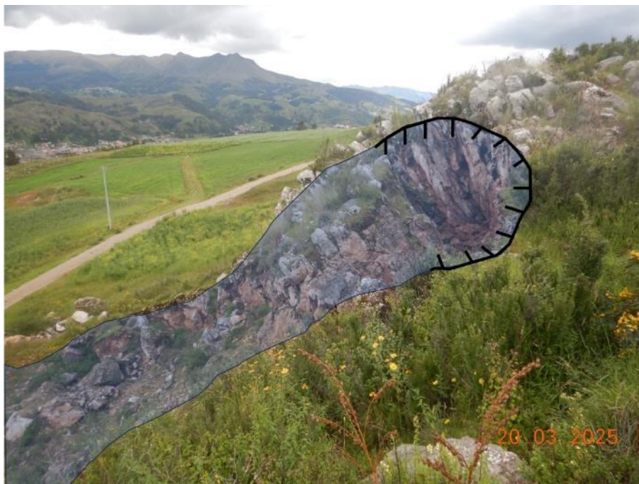
Figura 11: Derrumbe A con corona de 25 m de longitud, sus materiales caídos pueden llegar al carretea comunal.
