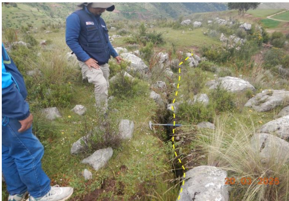
Figura 12: Grieta tras la corona del derrumbe A con apertura de 35 cm.
