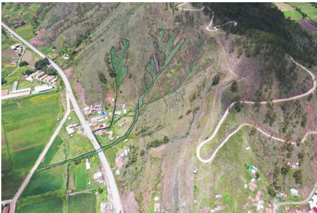
Figura 18: Se aprecia la cárcava 3 con cambios en la dirección de su canal, además, la cantidad de materiales que trasladó casi obstruye e inunda al pasar por la vía Panamericana Sur.
