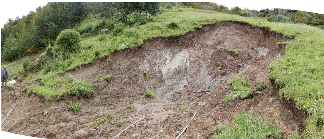
Fotografía 12. Escarpe principal del deslizamiento activo. Nótese el salto del escarpe cerca de 2.5 m de desnivel y la surgencia de agua subterránea que quedó descubierta. Vista mirando al norte.
