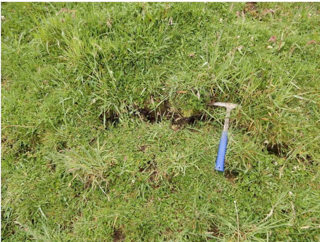
Fotografía 14. Grietas de tracción ubicadas de manera oblicua con respecto al escarpe principal del deslizamiento. Presentan una abertura de 8 a 10 cm de ancho y un desnivel de 5 cm.
