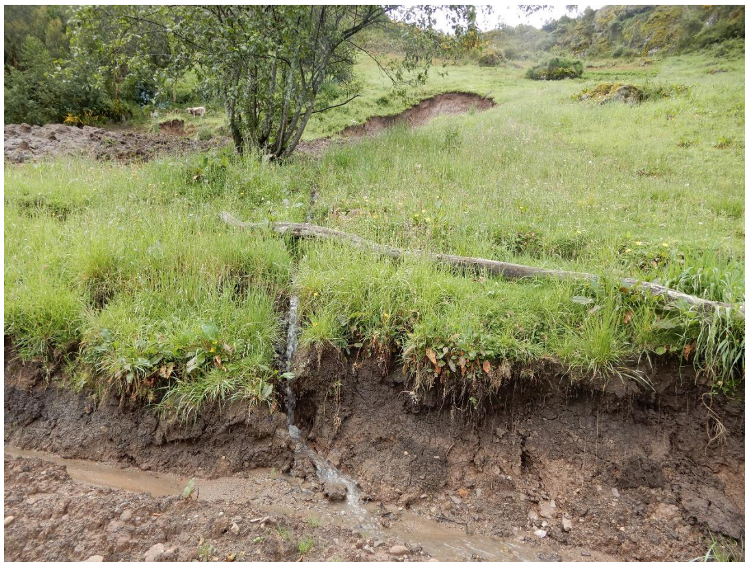
Fotografía 21. Surgencias de agua que discurren sobre material limo arcilloso que posteriormente se vierten hacia canales sin revestimiento.
