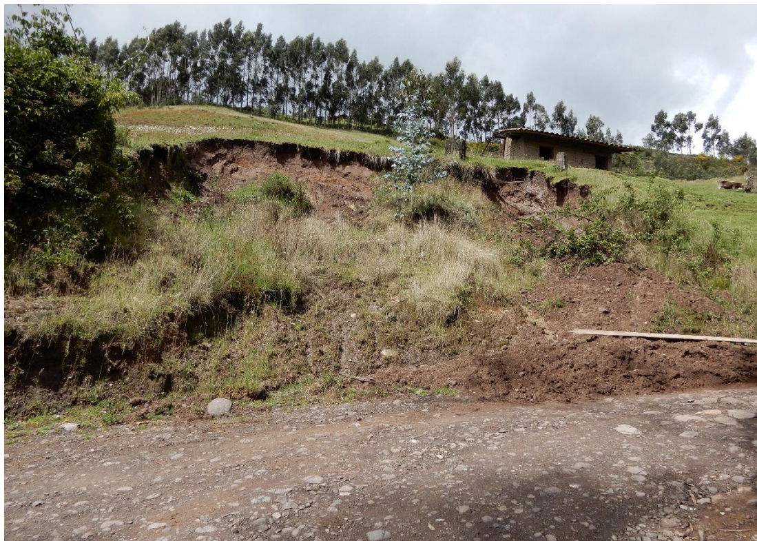
Fotografía 15. Derrumbe de pequeña magnitud ubicado adyacente a la trocha carrozable que afectó parte de ella. Vista mirando al norte.
