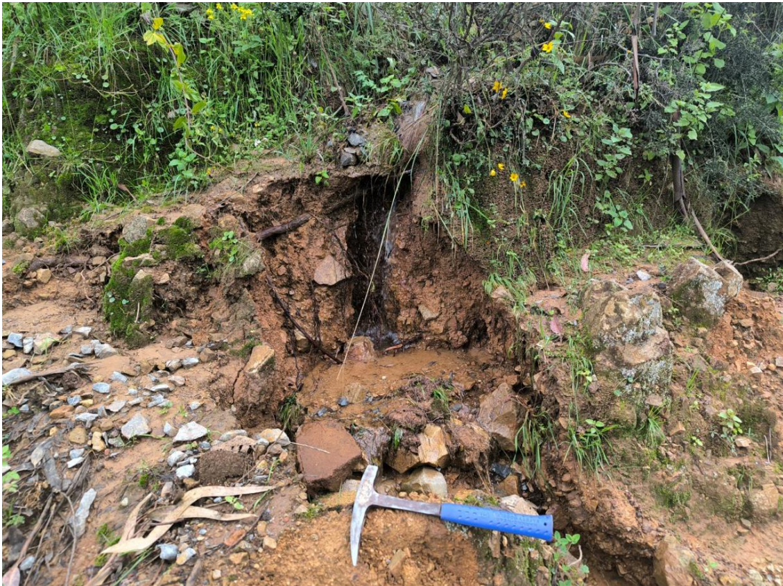
Fotografía 5: Depósitos coluvio deluviales con evidencias de manantes de agua en Accomarca.
