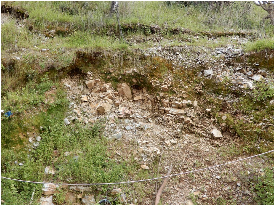
Fotografía 1: Areniscas fracturadas de la Formación Labra cubiertas por depósitos coluvio-deluviales en el área de estudio.
