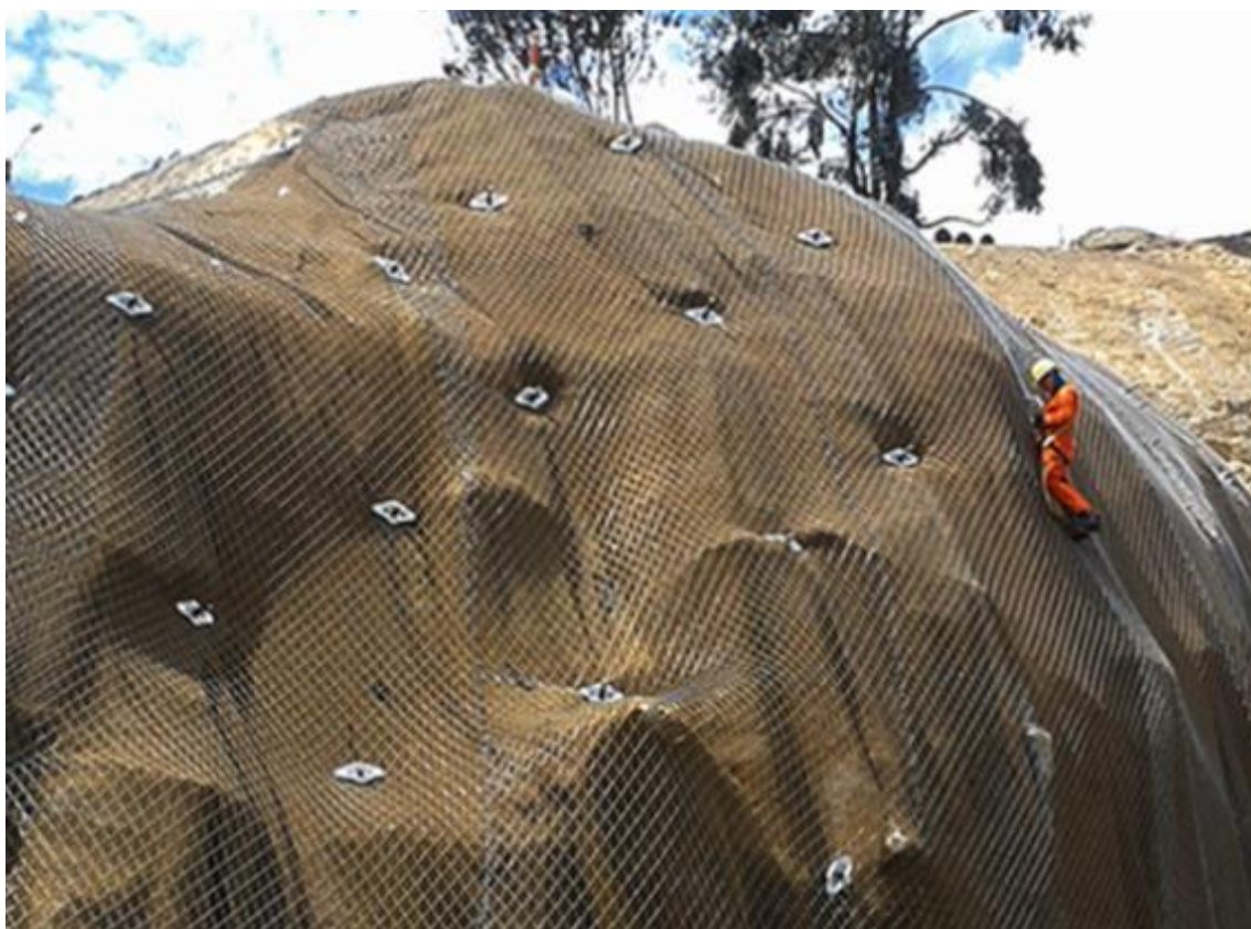
Figura 21. Ejemplo de pernos de anclaje y enmallado.
