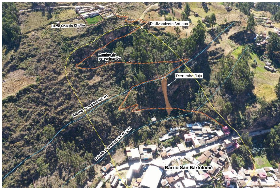
Figura 14. Vista del derrumbe-flujo y de las tuberías de conducción de agua hacia los reservorios 1, 2 y 3 que pasan por la ladera del cerro Cruz de Chullin.
