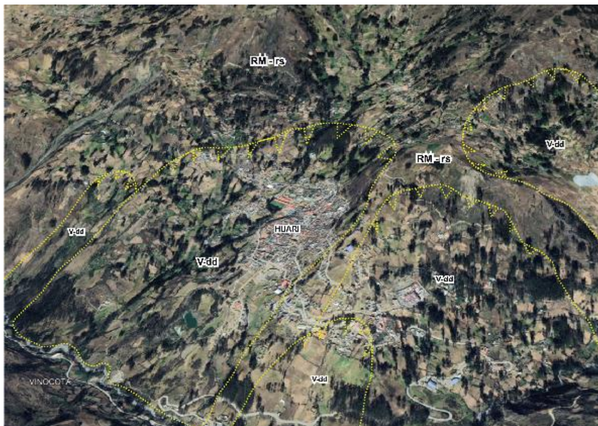
Figura 10. Vista de la Subunidad de vertiente con depósito de deslizamiento (V-dd), donde se evidencia que el poblado de Huari se asienta sobre el cuerpo de un deslizamiento antiguo.
