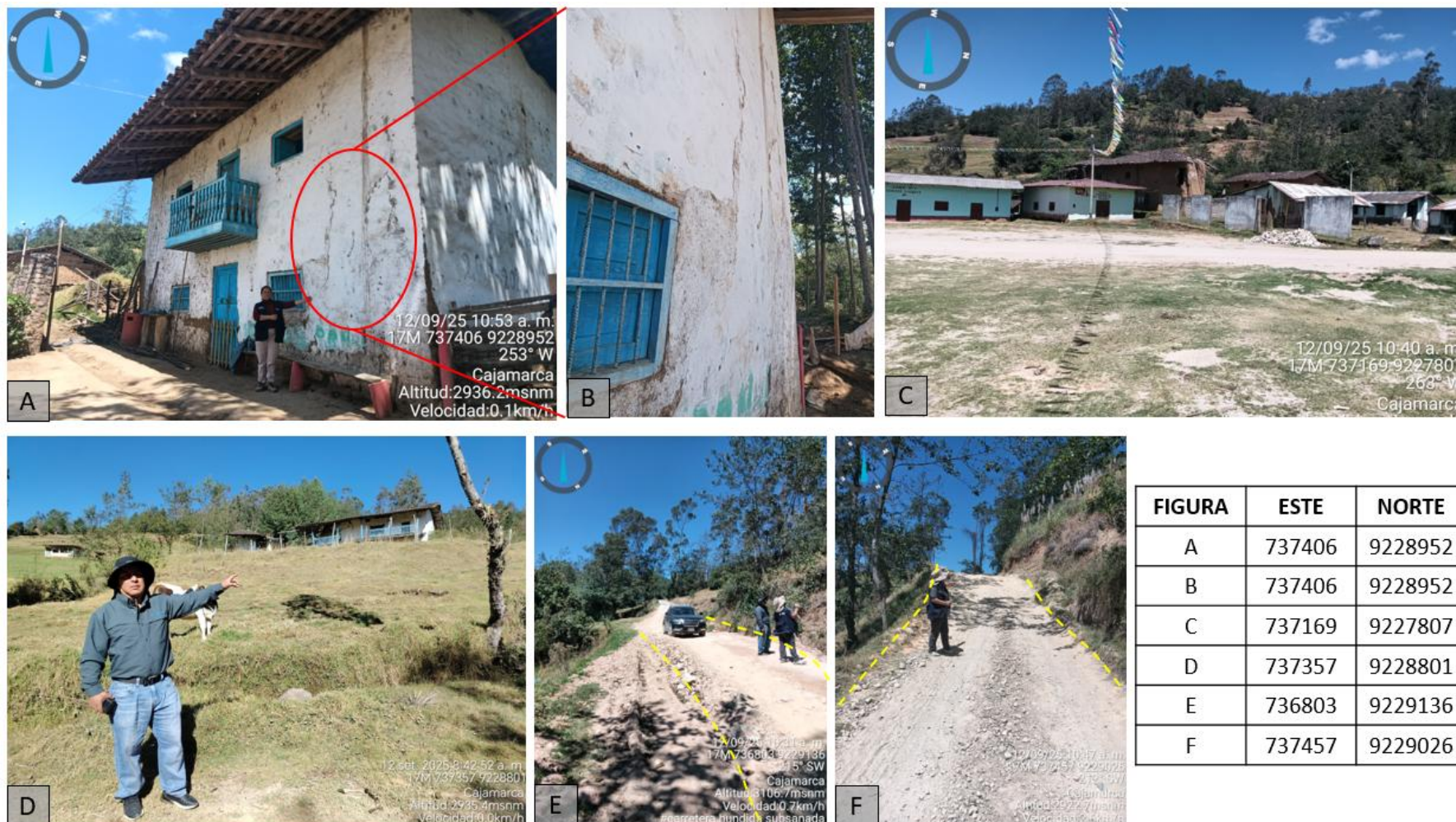
Figura 16: A. Vivienda con grietas, afectada por el deslizamiento. B. Acercamiento a grietas de la vivienda afectada. C. Viviendas afectadas por deslizamiento. D. Escuela antigua que fue destruida en el deslizamiento y huaico de 1998, ahora sin uso. E. Carretera afectada durante el deslizamiento, subsanada de forma artesanal con material de relleno. F. Carretera afectada por deslizamiento.
