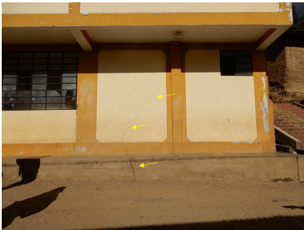
Figura 16. Grieta (flechas amarillas) que atraviesa transversalmente la vereda y pared frontal del establecimiento de salud del sector Huacash.
