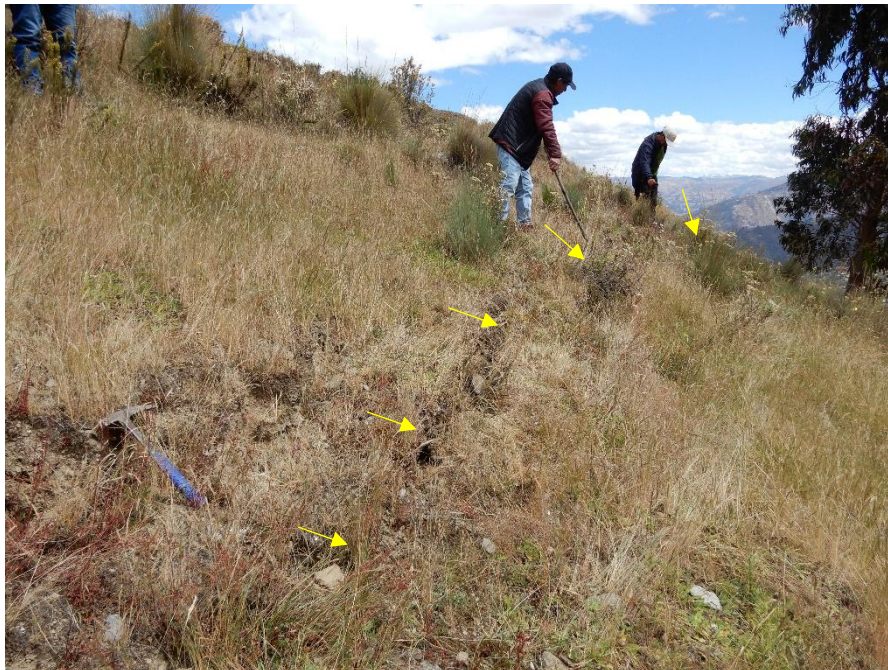
Figura 19. Grieta de tracción (flechas amarillas) sobre el escarpe del deslizamiento (D3), con ~10 m de longitud y profundidad visible de 40 cm. Vista mirando al sur.
