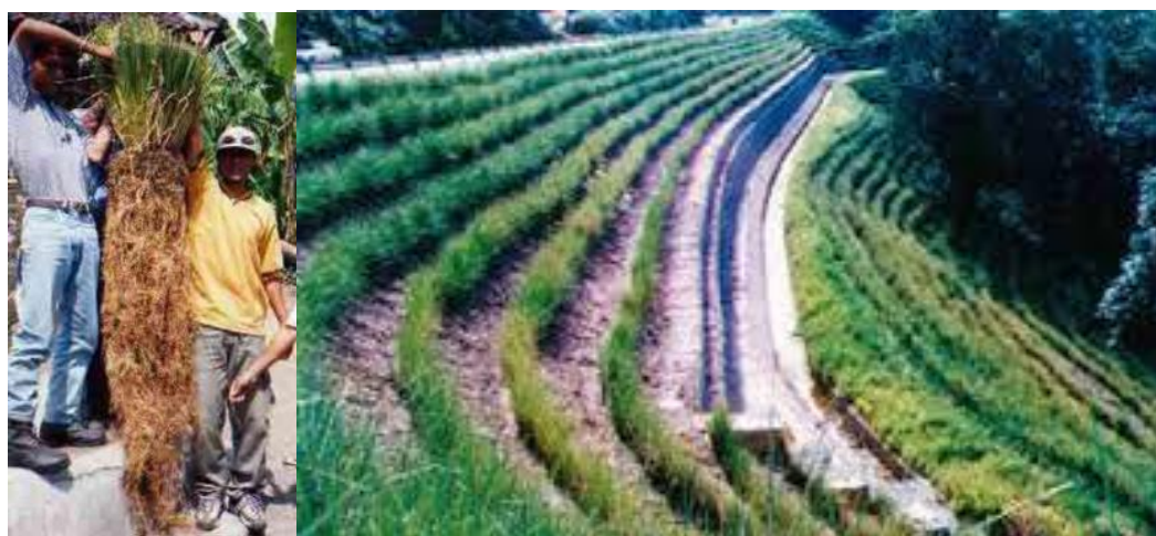
Figura 2.3. Ejemplo de bioingeniería con arbusto (vetiver) en taludes de materiales sueltos.
