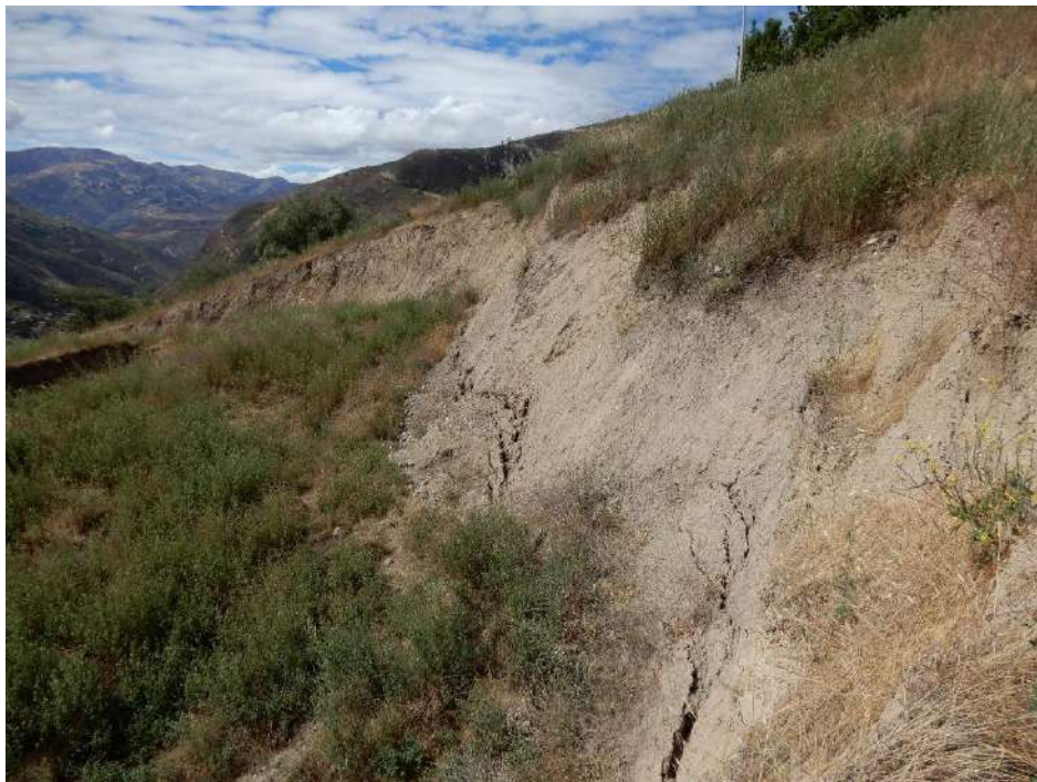
Fotografía 8. Escarpe principal en la corona del deslizamiento activo en el sector Santa Rosa-Pauca. Presenta un salto de hasta ~4 m de desnivel. Vista mirando al sur.
