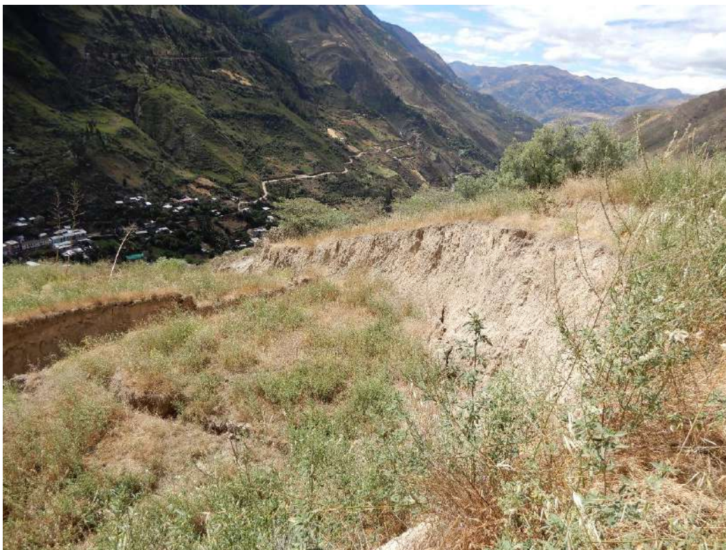
Fotografía 9. Detalle del flanco derecho que se prolonga hacia el río Sihuas, así también se observa el escarpe secundario. Vista mirando al sur.
