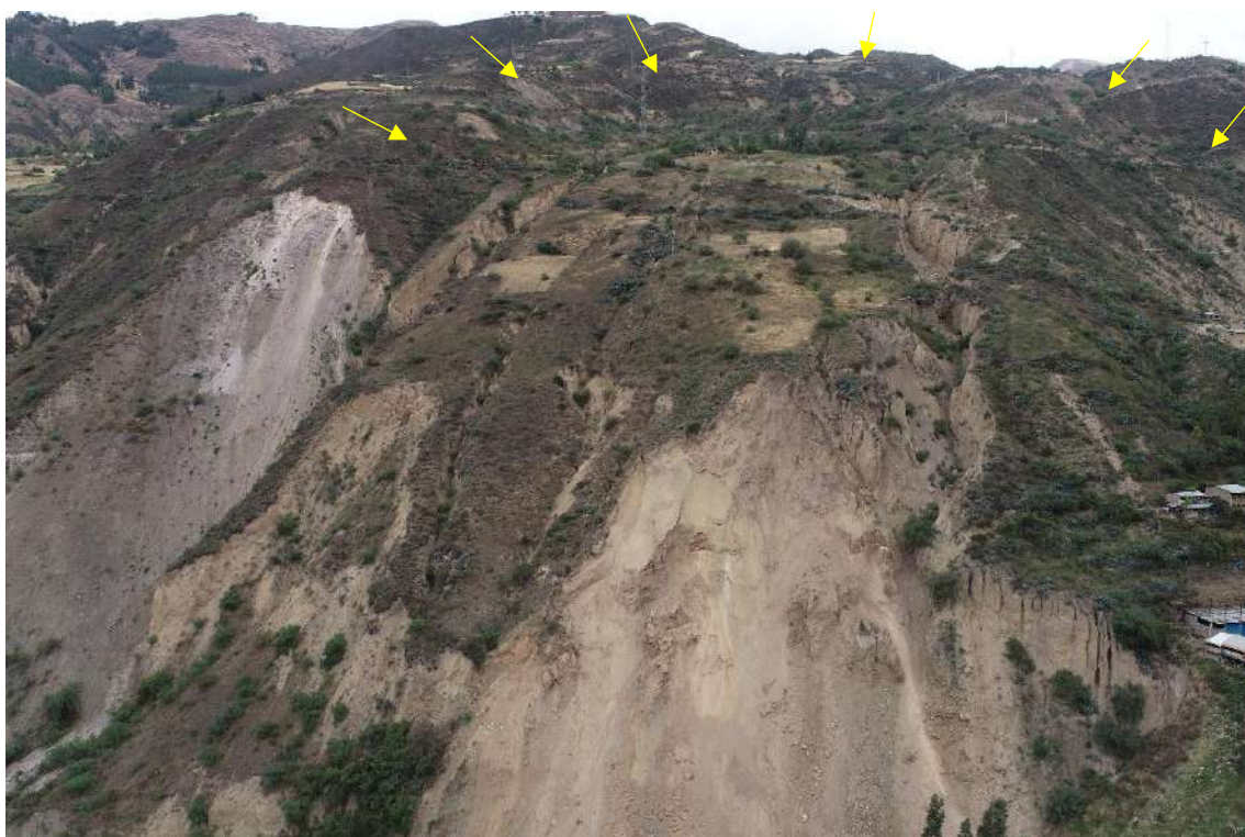
Fotografía 6. Deslizamiento antiguo (indican las flechas amarillas), donde actualmente se instala un deslizamiento activo hacia la parte distal. Vista mirando al sur.
