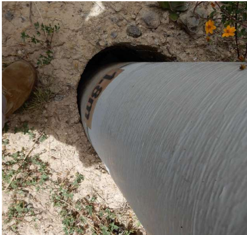
Fotografía 12. Ligero desplazamiento del poste de tendido eléctrico afectado por el movimiento de la masa inestable.
