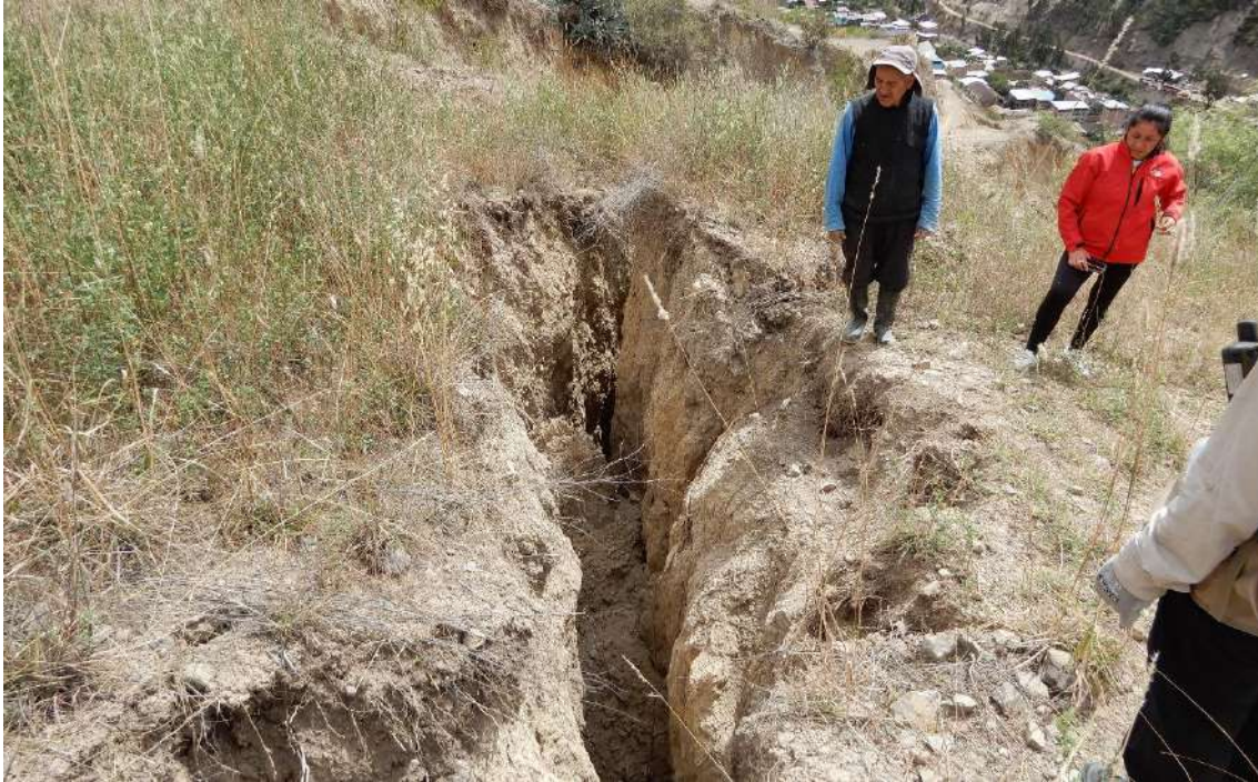
Fotografía 11. Grieta profunda de hasta 1.5 m de abertura y 5 m de profundidad visible ubicado en el cuerpo principal del deslizamiento.
