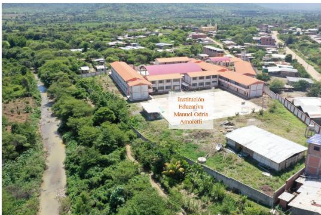
Figura 16. Institución Educativa Manuel Odría Amoretti del nivel inicial y primaria, ubicada el el margen derecho de la quebrada Chipillico. Ubicación: E: 596188, N: 9478135
