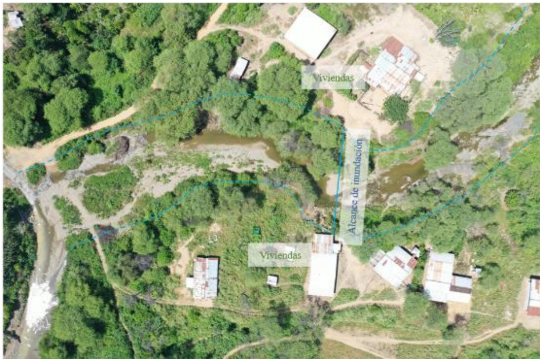
Figura 14. Viviendas susceptibles a inundación fluvial. Ubicación: E: 595995, N: 9477881
