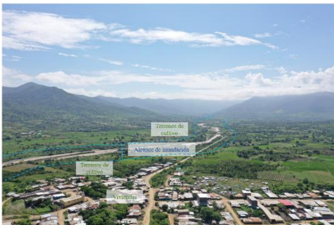
Figura 17. Terrenos de cultivo y viviendas susceptibles a inundación fluvial por desborde del río Chipillico. Ubicación: E: 596268, N: 9478767
