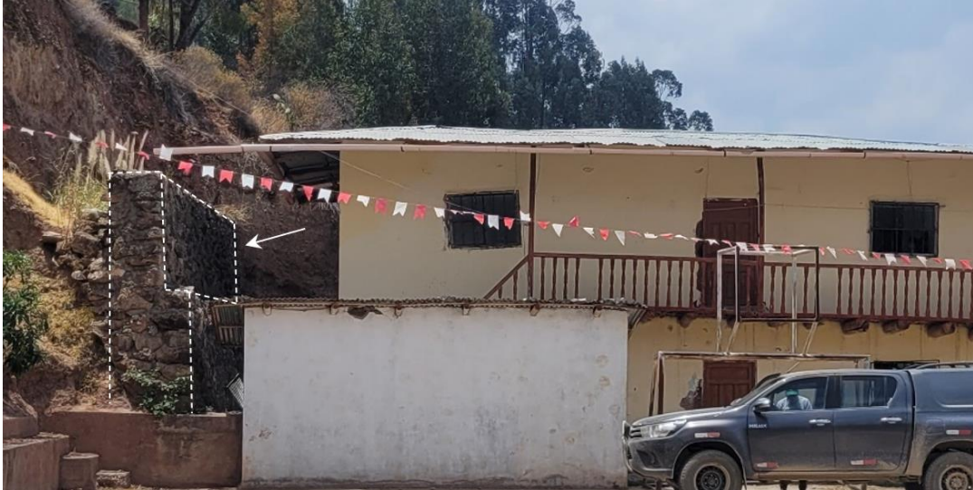
Figura 16. Muro ciclópeo (líneas blancas), construido para proteger pared lateral de Institución educativa de derrumbe.
