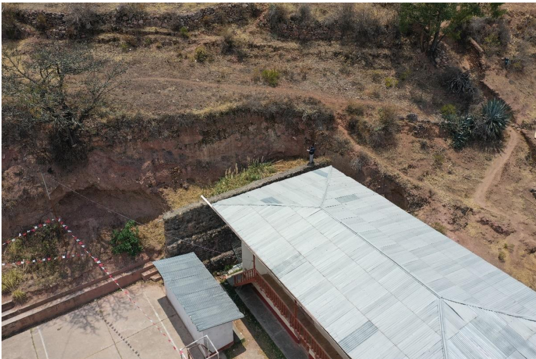
Figura 2. Vista de la parte alta del cuerpo de la zona de reptación de suelos, se observa la escasa vegetación y remoción del terreno para instalación de cultivos agrícolas.
