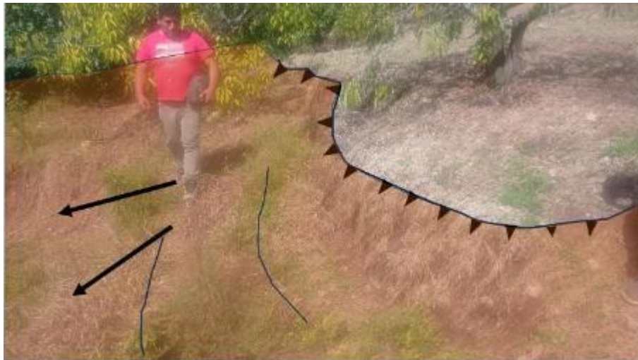
Figura 11: la escarpa de deslizamiento activa que genera movimientos del terreno muy lentos.
