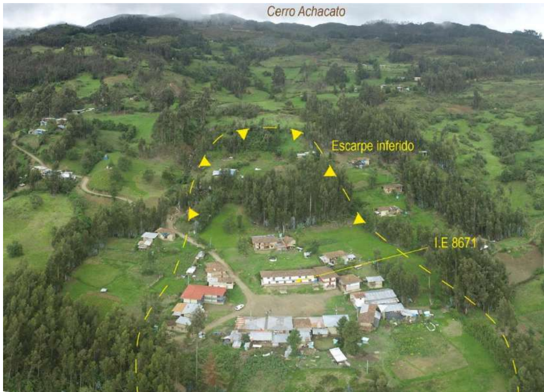
Figura 11. Deslizamiento en proceso de formación en el sector Huanchilca que afecta parte de la población y a la institución educativa I.E. N°80671. Este evento se desarrolla sobre una ladera con pendiente fuerte al norte del cerro Achacato. Vista mirando al sur.
