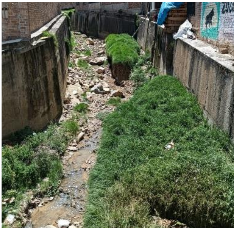
Figura 9. Depósito fluvial del Río Tres Ríos, el mismo que cursa la zona urbana del distrito de Cajamarca.
