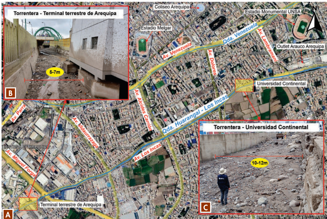
Figura 5. A) Curso inferior de la quebrada Huarangal-Los Incas. B) Sector del Terminal Terrestre de Arequipa, donde el ancho de la quebrada Huarangal-Los Incas tiene menos de 7 m. C) Sector de la Universidad Continental. El área en amarillo indica el ancho de la quebrada.
