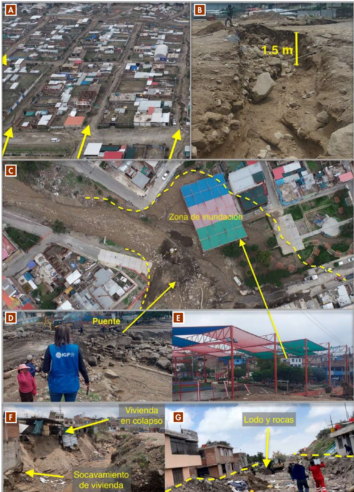
Figura 20. A y B) Asociación de vivienda Cabrerías, afectada por las intensas lluvias que provocaron surcos debido a la erosión del suelo constituido de material volcánico. C y D) Zona de Villa Continental: puente sobre la quebrada Azufral afectado y sobrepasado por un lahar con bloques de más de 1.5 m de diámetro. E) Losa deportiva de Villa continental inundada, con cerco derribado por lahares. F) Colapso de viviendas en Villa Continental. G) Afectación por lahar en Juan Pablo II.
