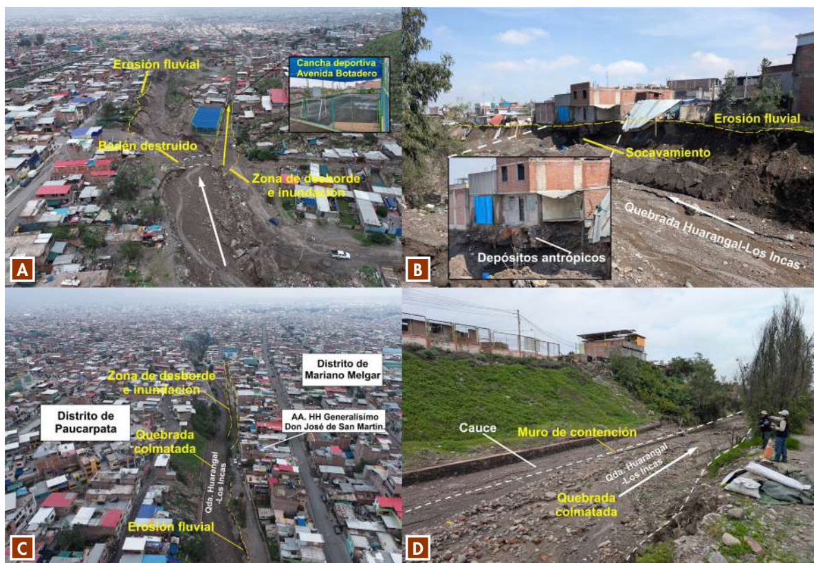
Figura 26. Vista de la quebrada Huarangal-Los Incas y áreas aledañas. A) Socavamiento de las laderas de ambos márgenes de la quebrada. B) Vivienda en el sector de Los Pinos colgada sobre el talud. C) Desborde del lahar en el A. H. Generalísimo Don José de San Martín. D) Colmatación de la quebrada en el A. H. Generalísimo Don José de San Martín.
