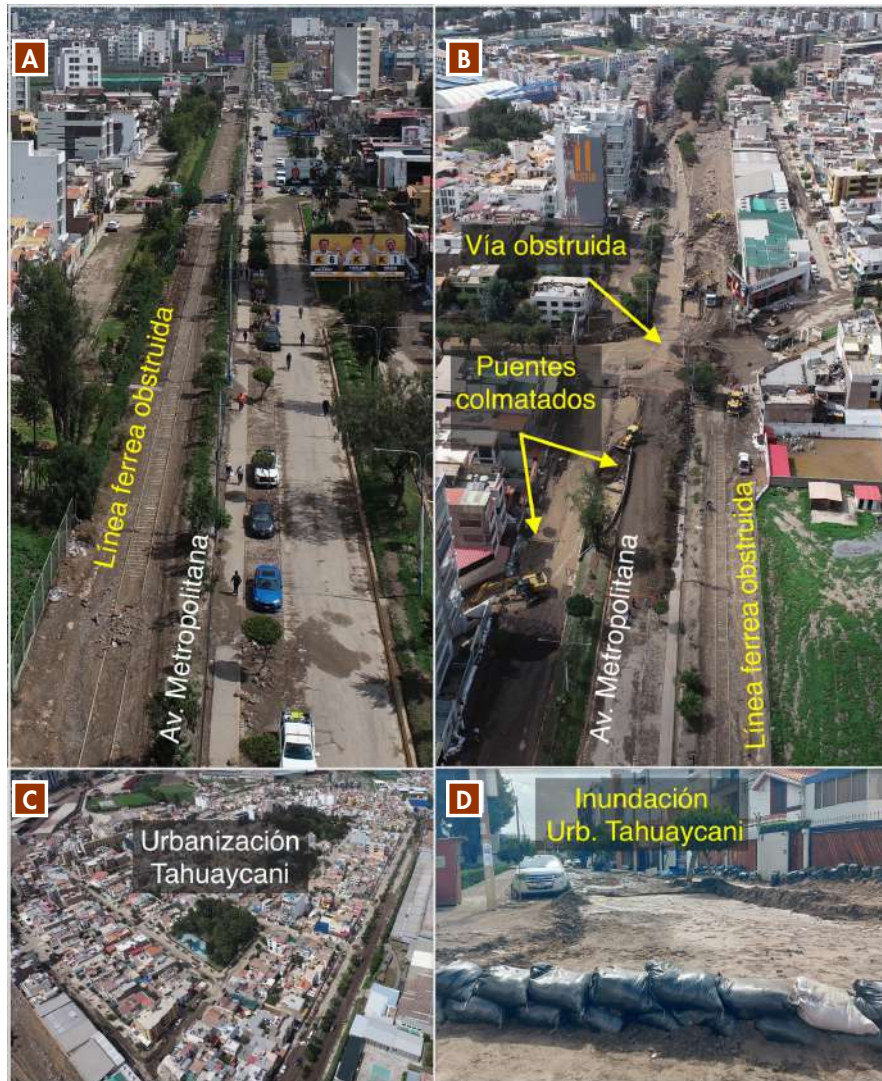
Figura 18. A y B) Avenida Metropolitana afectada por el ingreso de lahares que dañaron calles, vías férreas y colmataron puentes. C y D) Vista de la urbanización Tahuaycani, inundada como consecuencia del desborde de la quebrada Chullo.
