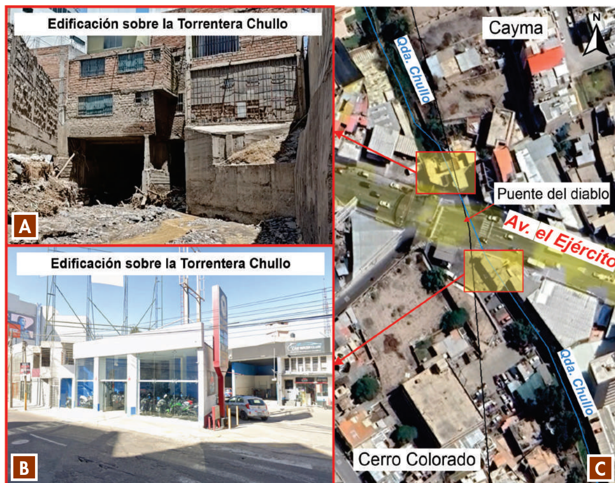
Figura 36. A) Vivienda construida sobre la quebrada Chullo. B) Segunda edificación ubicada sobre la quebrada Chullo. C) Cruce de la quebrada en la avenida Ejército, en el sector Puente del Diablo.
