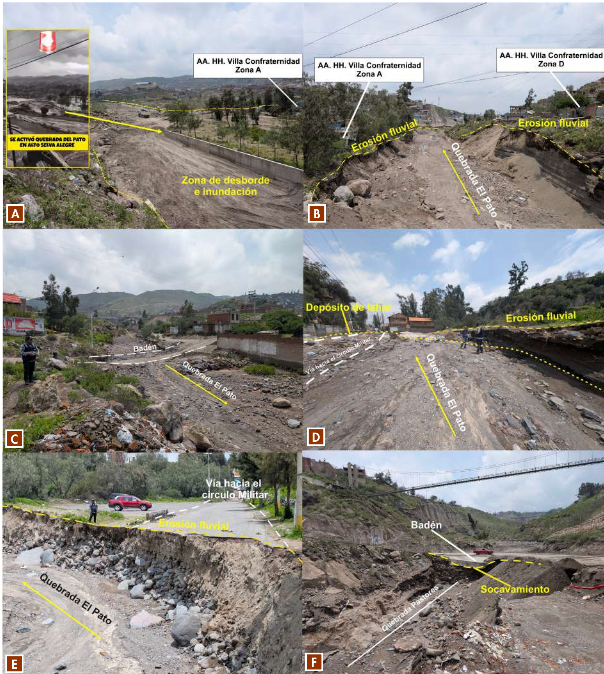
Figura 24. Vista de la quebrada El Pato y áreas aledañas. A) Desborde e inundación del A. H. Villa Confraternidad, zona A. B) Erosión a ambos márgenes de la quebrada. C) Badén totalmente destruido en el A. H. Villa Confraternidad, zona C. D) Depósito de lahar que bloqueó la vía de acceso hacia el Círculo Militar. E) Destrucción de 15 m de vía hacia el Círculo Militar. F) Socavamiento en el badén hacia los Andenes de Chilina.
