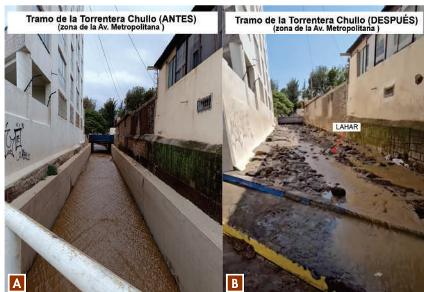
Figura 19. A) Tramo de la torrentera Chullo en el cruce de la avenida Metropolitana y Belaúnde, antes de ser afectadas por el lahar. B) Torrentera colmatada por bloques de roca y sedimentos luego del paso del lahar.
