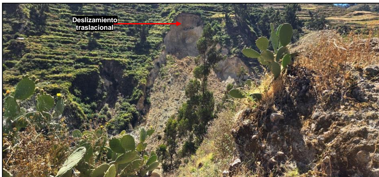
Figura 13. Vista frontal del deslizamiento traslacional en Cuchumbaya
