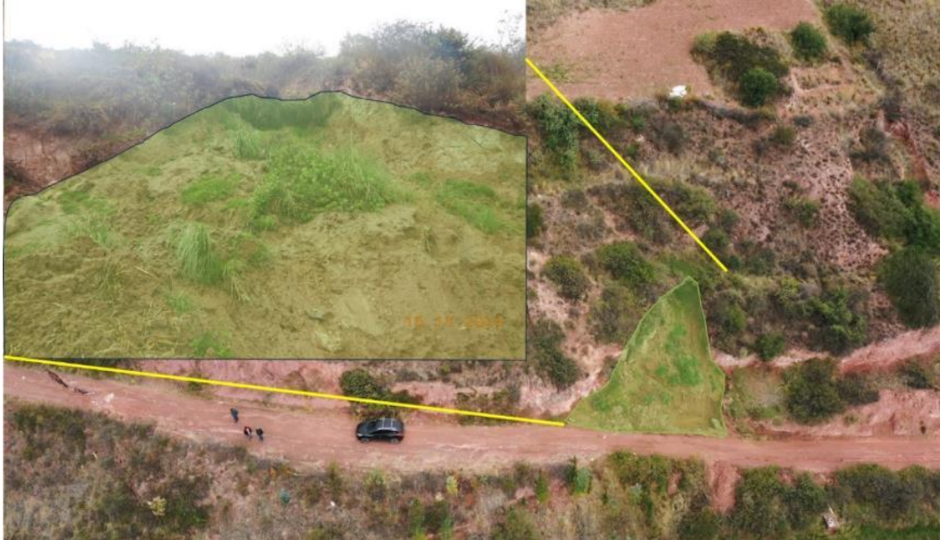
Figura 13. Cárcava ubicada a la izquierda del deslizamiento, generada por surgencia de agua en el sector.
