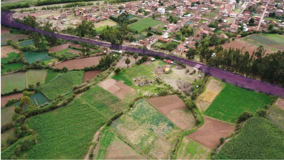
Figura 8. Posible trayecto del flujo de detritos por el río Wuaycco y su posible afectación a viviendas y áreas de cultivos.
