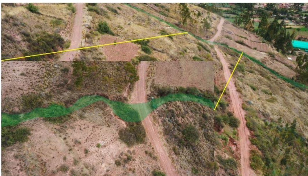
Figura 14. Se aprecia un tramo de vía sin canal de drenaje que puede ser afectada por la cárcava.
