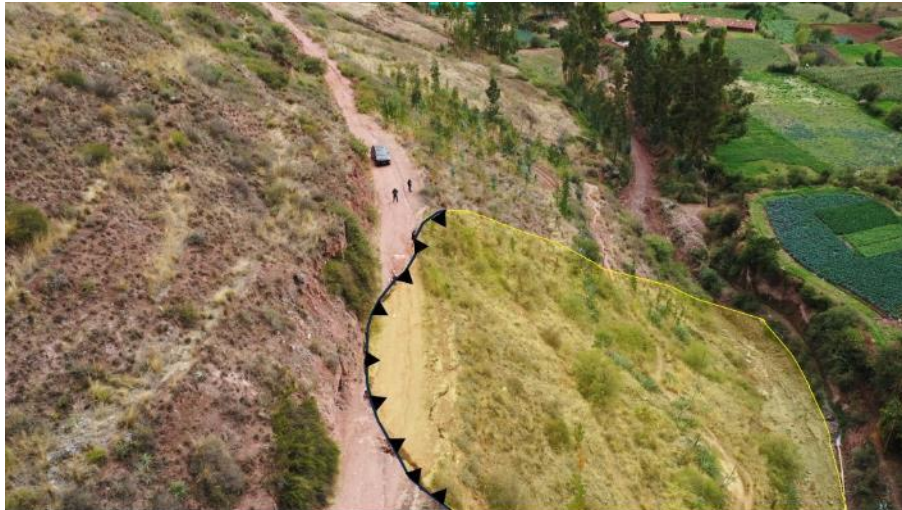
Figura 6 Deslizamiento que afecta 30 m de la carretera y obstruyendo parte del canal del río Waycco.
