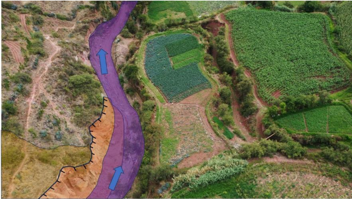
Figura 9. Posible flujo de detritos en el río Waycco y puede alcanzar viviendas y áreas de cultivos.
