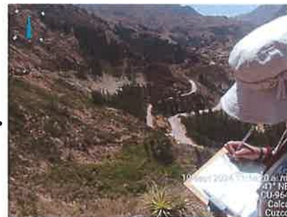
Figura 110. Deslizamientos rotacionales en la parte alta y baja de la pista de acceso principal al parque arqueológico de Pisac. Ubicado en las coordenadas 8516084 N, 192315 E
