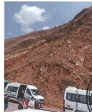
Figura 109. Bloques de rocas se encuentran en suspensión con bastante fracturamiento a una altura de 5 m y el talud tiene alta pendiente y cárcavas en la base. Ubicado en las coordenadas 8516344N, 192345 E.
