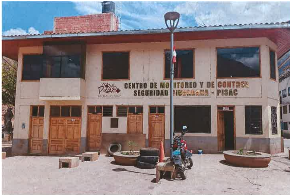
Figura 31. Centro de Monitoreo y de Control Seguridad Ciudadana – Pisac.
