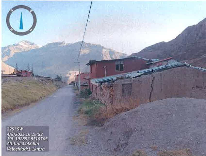
Figura 126. Viviendas construidas con material de adobe y techo de calmina, las paredes se encuentra con grietas muy grandes, su estado de conservación muy mala.
