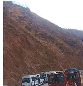
Figura 108. Deslizamiento ocurrido encima de la vía principal, el cual tiene una escarpa de 3 m y genero cárcavas activas por precipitación muy cercanas a los puestos de ventas. Ubicado en las coordenadas 8516234 N, 192281 E.
