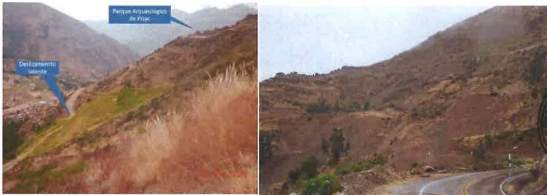
Figura 111. Deslizamiento de la parte baja de la vía hacia el Parque Arqueológico de Pisac
