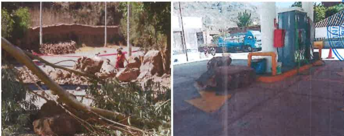
Figura 113. Bloques de rocas en la carretera, en el grifo del sector de Huanohuano T'uqu, postes afectados, canal de riego destruidos por caída de rocas en el cerro Huanohuano.
