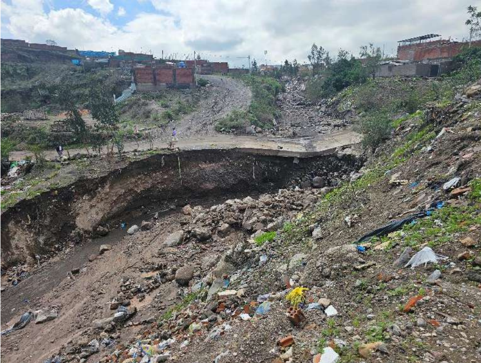
Fotografía 34. Parte alta de la quebrada Los Incas, donde se juntan la quebrada Huarangal, Huarangueros y Pampa Blanca. Sector de Villa Los Olivos (Paucarpata). Se puede observar que el cauce de la quebrada mide al menos 30 m.
