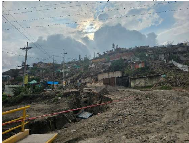
Fotografía 56. Erosión y socavamiento del terreno en el sector de Villa Confraternidad (Alto Selva Alegre). Se puede visualizar que las viviendas se encuentran en un terreno inestable.
