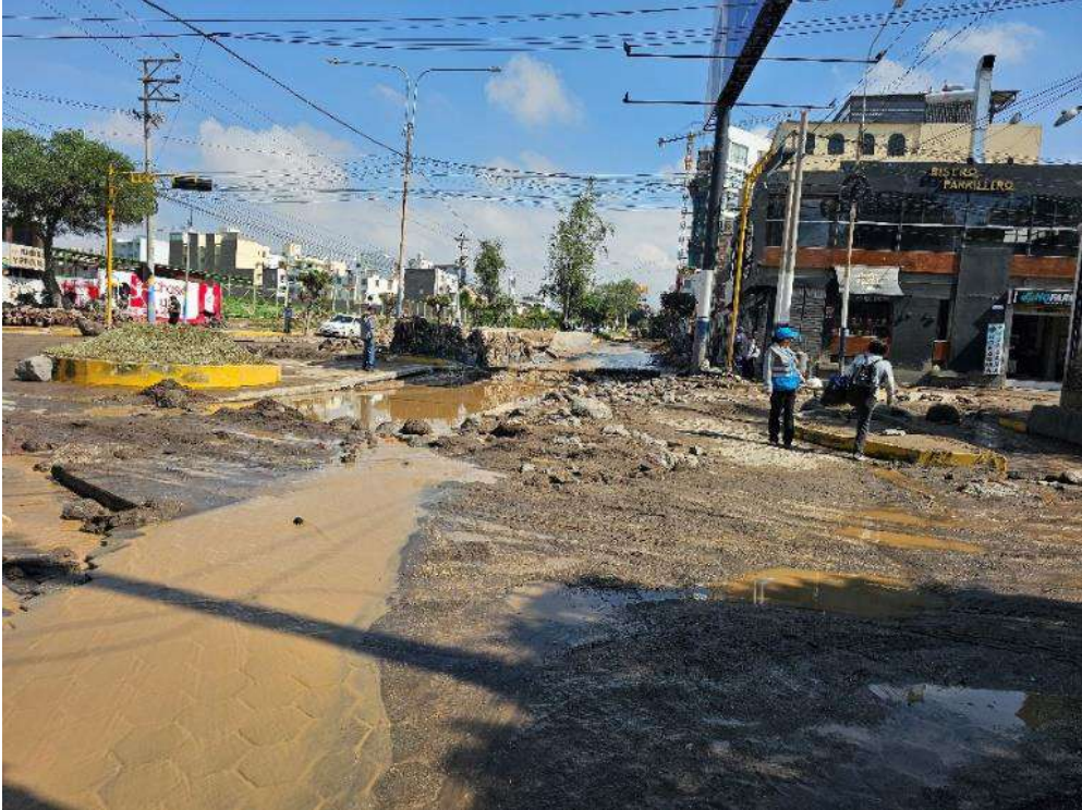
Fotografía 26. Av. Metropolitana – Tahuaycani, donde la quebrada desbordo completamente trayendo consigo, lodo y bloques de más de 2 m (Cercado de Arequipa).
