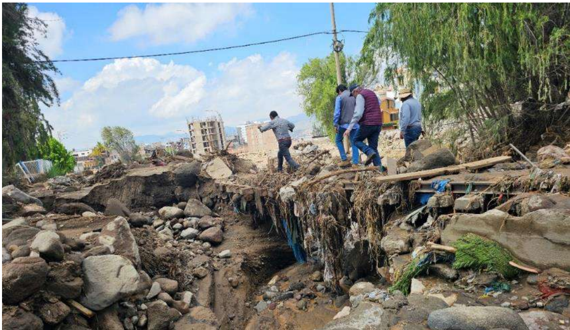
Fotografía 31. Vías de ferrocarril afectadas por el flujo de detritos en Flora Tristán (Cercado de Arequipa).
