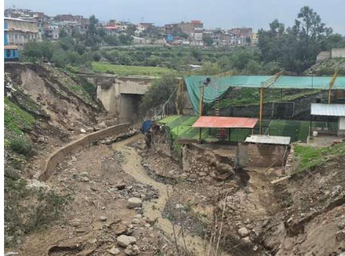
Fotografía 8. Afectación en el sector de Asentamiento Humano Buenos Aires (Cayma). Afectación de cancha sintética.
