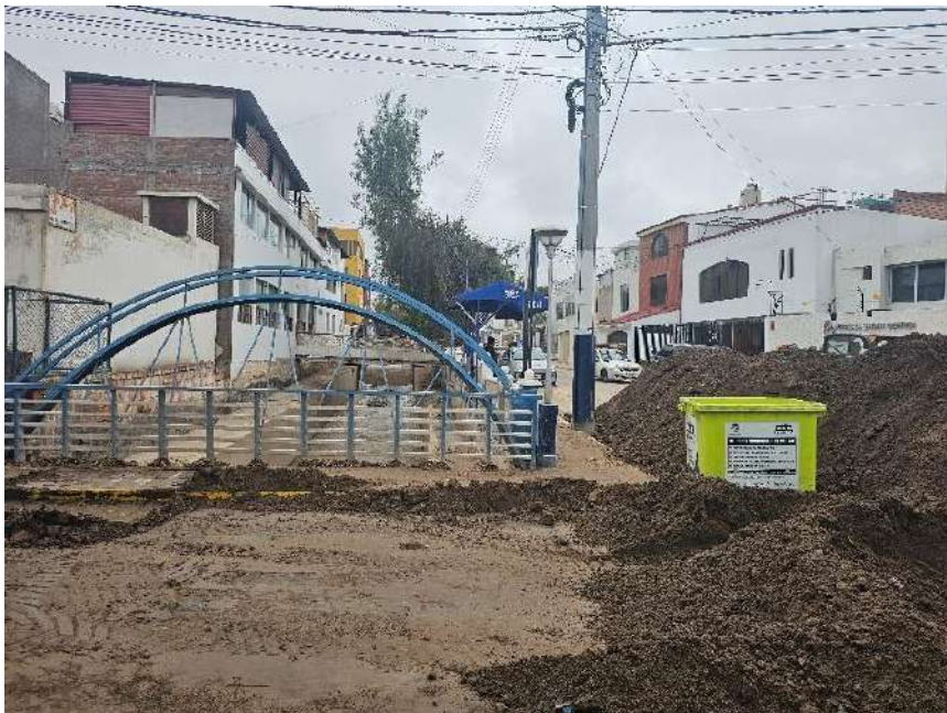
Fotografía 23. Desbordamiento de la quebrada Chullo en la Av. Tulipanes (Yanahuara).
