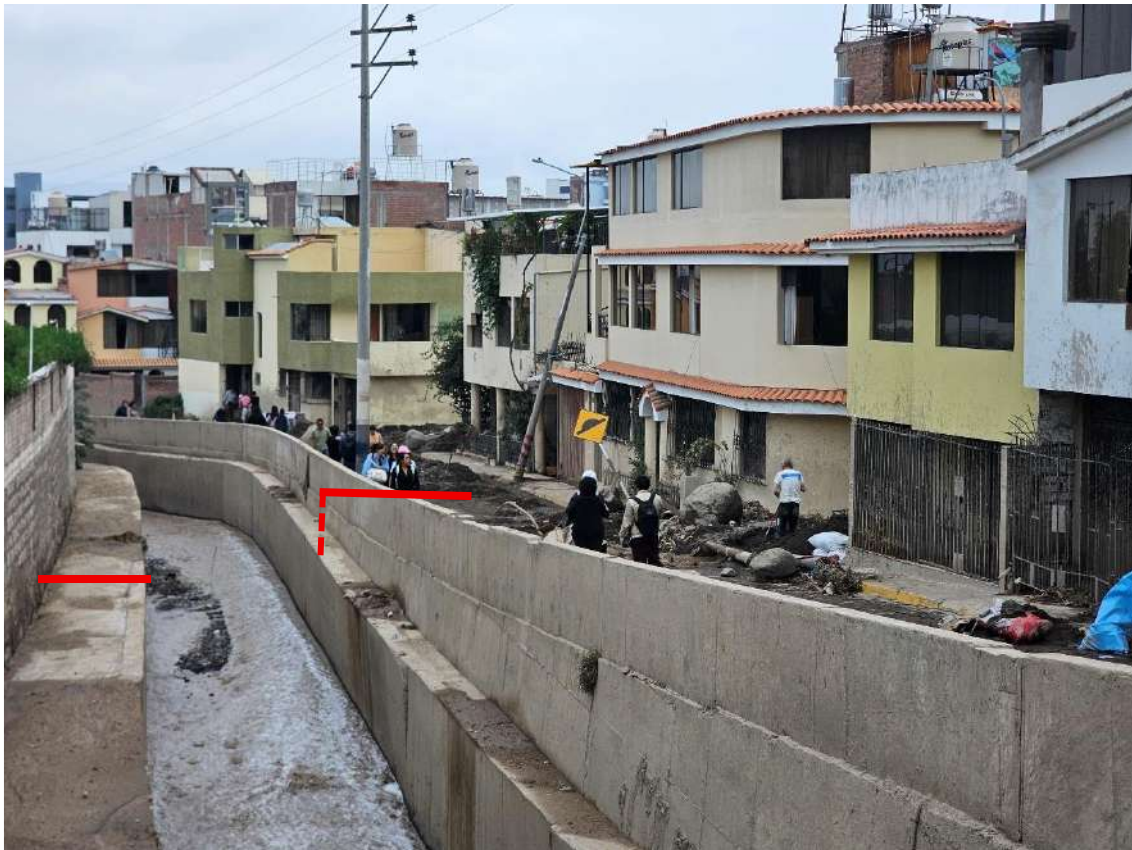
Fotografía 20. Se puede apreciar en la San Agustín (Yanahuara), la quebrada se ha reducido a menos de 5 m de ancho. Las líneas de color rojo indican el tramo reducido de la quebrada durante las obras de encauzamiento de la quebrada Chullo en el año 2022.
