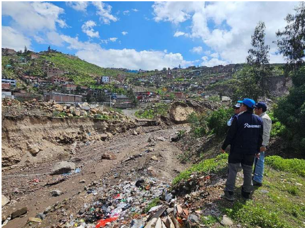
Fotografía 35. Sector entre la Calle Brasil y Miguel Grau (Paucarpata), donde se puede visualizar bastante material de desmonte que se encuentra en el cauce de la quebrada Los Incas.
