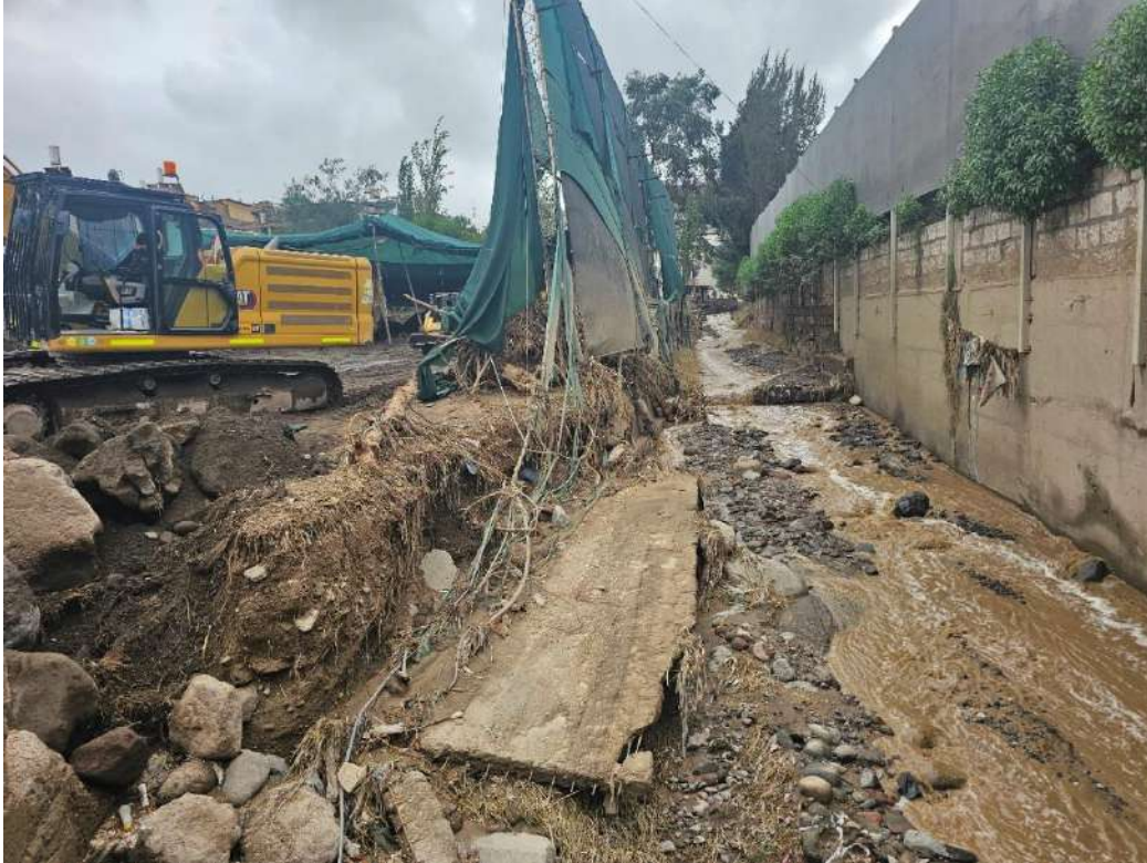
Fotografía 17. Cancha sintética totalmente destruida, por el desbordamiento de la quebrada el Chullo, al costado del colegio Lord Byron (Cayma - Yanahuara).
