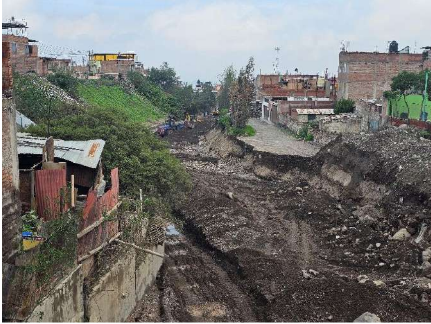
Fotografía 39. Desborde de la quebrada los Incas en el sector del puente 8 de octubre (Mariano Melgar).
