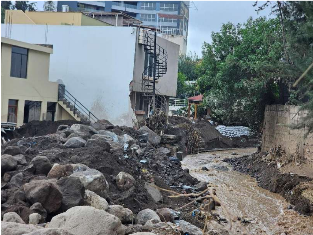
Fotografía 18. Se puede apreciar el estrangulamiento de la quebrada Chullo, incluso el desvío del cauce natural, al colocar estructuras y muros, afectando drásticamente a las viviendas e infraestructuras de las zonas laterales (Cayma - Yanahuara). Cabe resaltar que las viviendas se encuentran dentro del mismo cauce de la quebrada, dejando inexistente la faja marginal. Así mismo, el puente de la Concordia fue destruido por la Municipalidad para evitar obstrucciones de la quebrada.
