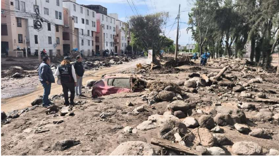
Fotografía 28. Flora Tristán afectada por el desbordamiento de la quebrada Chullo (Cercado de Arequipa). Casas destruidas, vehículos sepultados.
