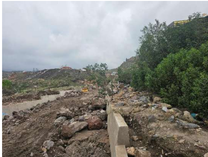
Fotografía 555. Desborde de la quebrada El Pato en el sector de Villa Confraternidad, dejando bloques de más de 1.5 m (Alto Selva Alegre).
