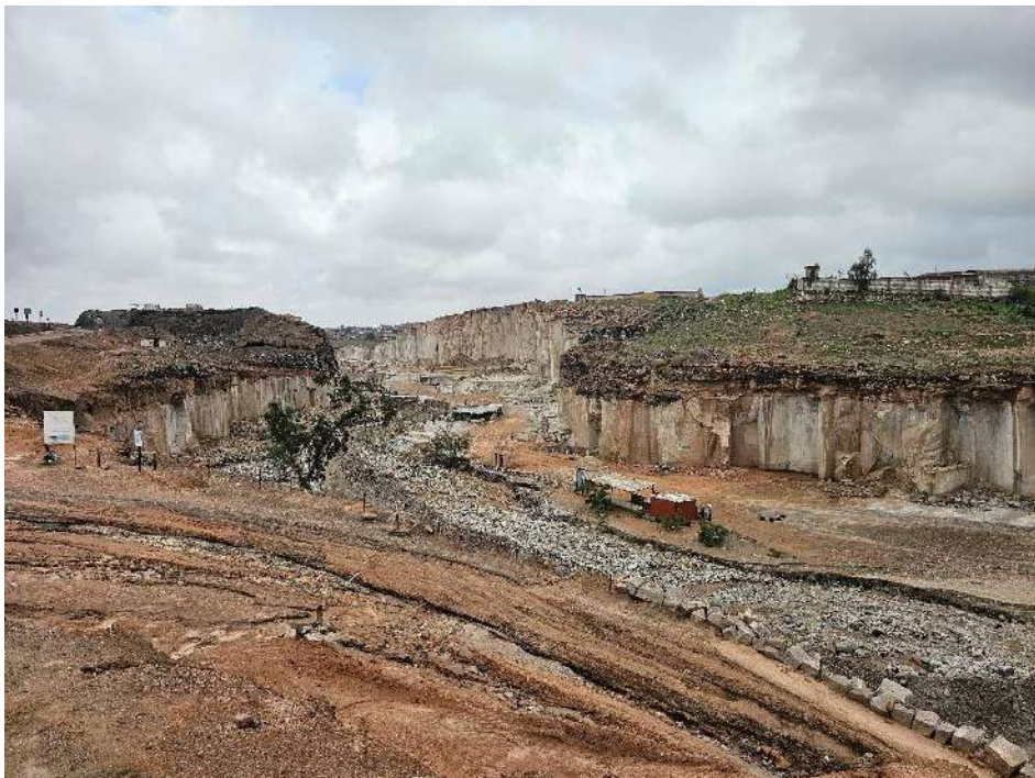
Fotografía 52. Canteras de Sillar de Añashuayco afectado por flujo de detritos en febrero de 2026 (Cerro Colorado).
