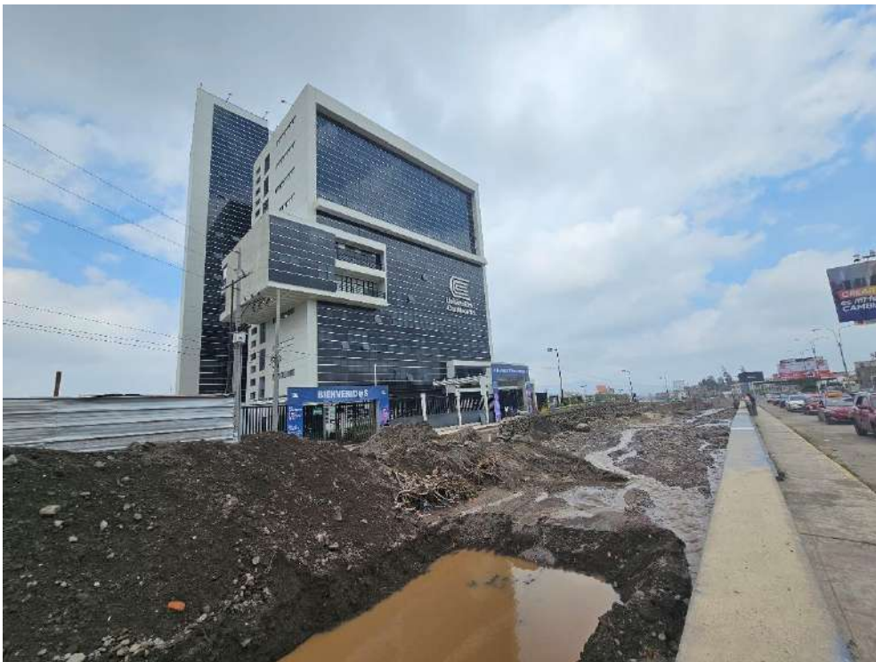
Fotografía 42. Desborde de la quebrada los Incas, que afectó la Universidad Continental de Arequipa, afectando la infraestructura y vehículos (José Luis Bustamante y Rivero).
