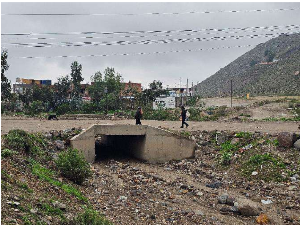
Fotografía 48. Sector Hernan Bedoya - Las Torres, donde se puede ver que la quebrada Añashuayco se restringe a solo un puente pequeño de 2 m de ancho (Cerro Colorado).
