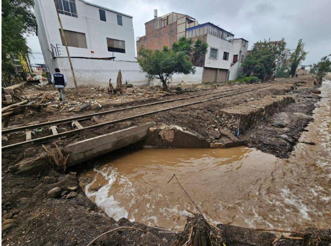
Fotografía 30. Se puede apreciar en Flora Tristán, la quebrada se ha reducido a menos de 3 m de ancho, incluso al parecer es una acequia. Además, que se evidencia el desvió del cauce natural de la quebrada (Cercado de Arequipa).
