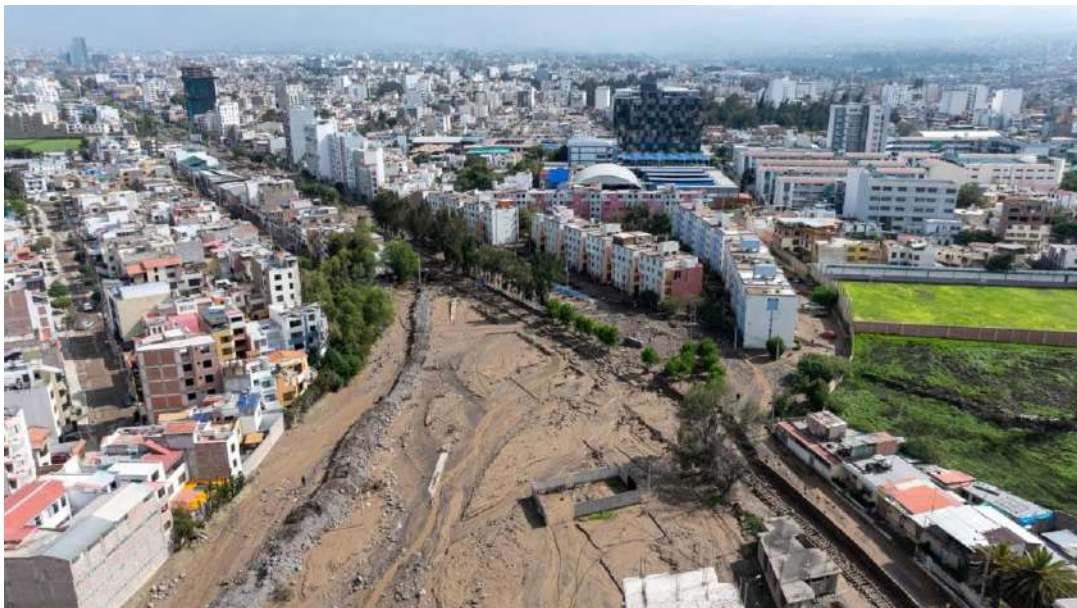
Fotografía 27. Vista aérea de Flora Tristán afectada por el desbordamiento de la quebrada Chullo (Cercado de Arequipa).
