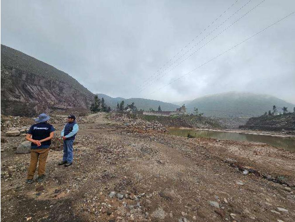
Fotografía 47. Agua estancada en el sector de Villa Cerrillos (Cerro Colorado). Se puede observar que el cauce de la quebrada Añashuayco mide al menos 70 m.
