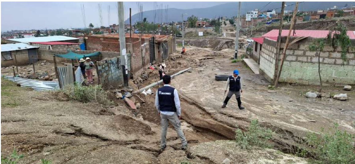
Fotografía 2. Trabajos de campo, realizados en la Asociación de Vivienda Pallpata (Cayma).
