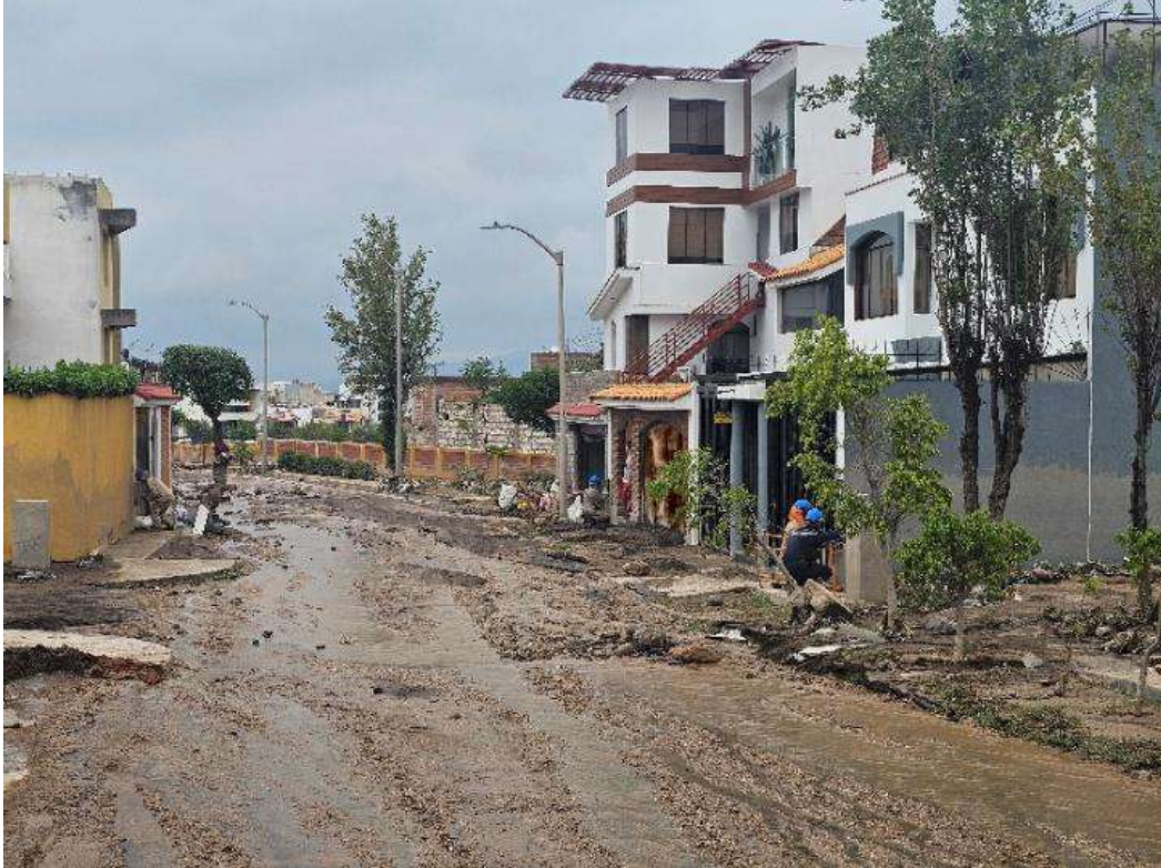
Fotografía 14. Casas inundadas con lodo en la Urbanización Los Frutales (Cayma).
