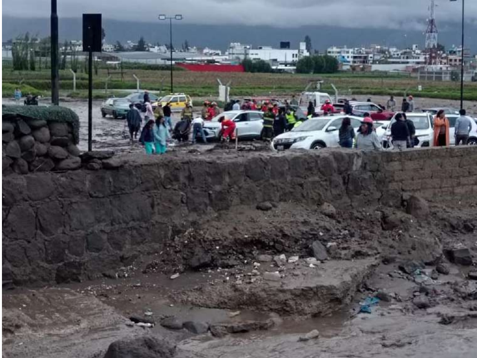
Fotografía 41. Desborde de la quebrada los Incas, que afectó la Universidad Continental de Arequipa, afectando la infraestructura y vehículos (José Luis Bustamante y Rivero).
