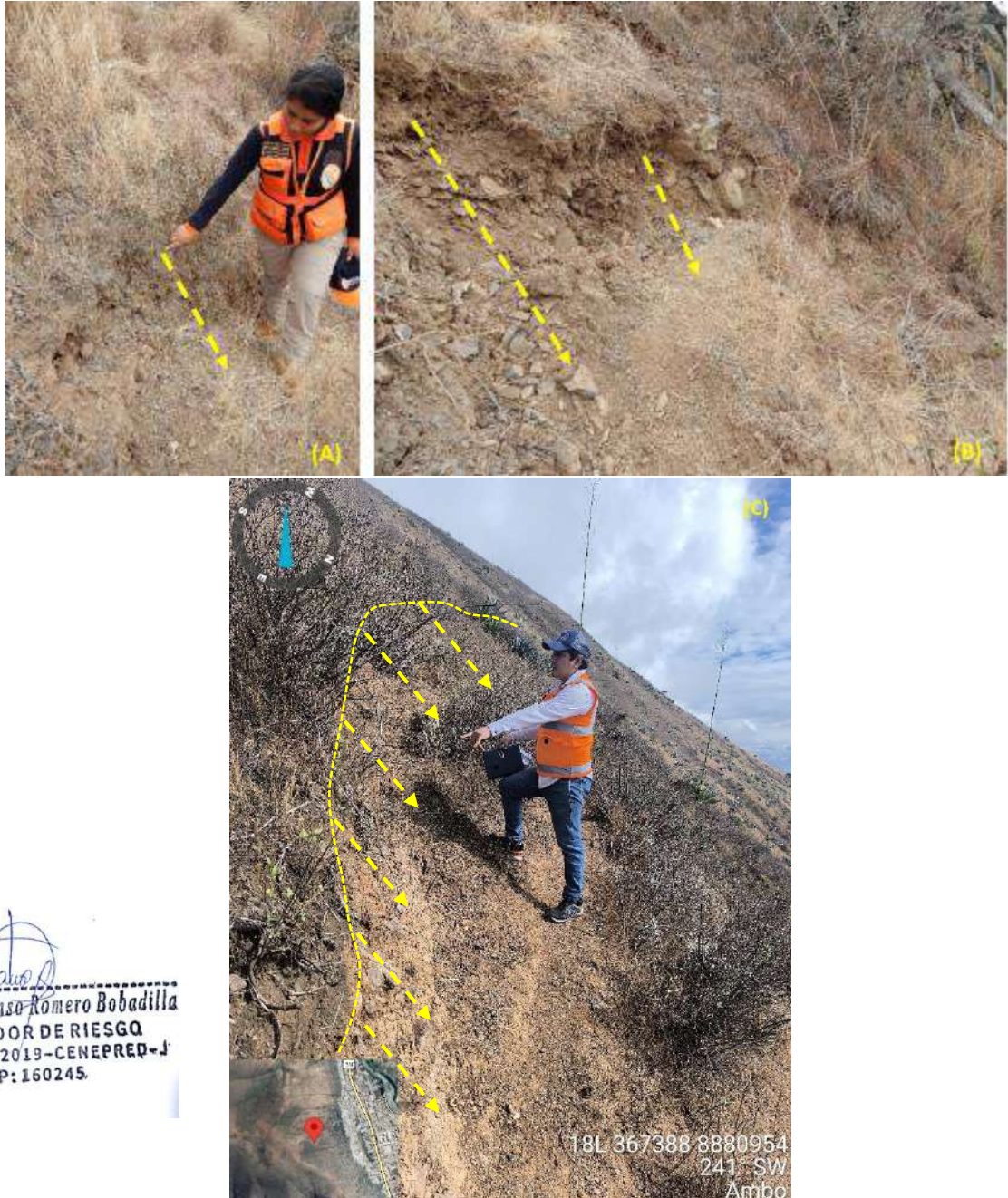
Figura 16: Se muestra el deslizamiento (A) y (B). del terreno. (C) Se muestra el agrietamiento del terreno.
