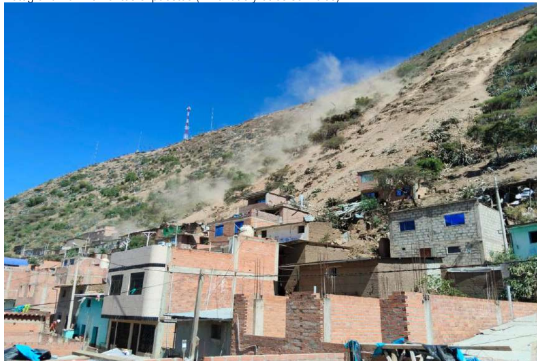
Fotografía 15: Elementos expuestos (viviendas y otros servicios)
