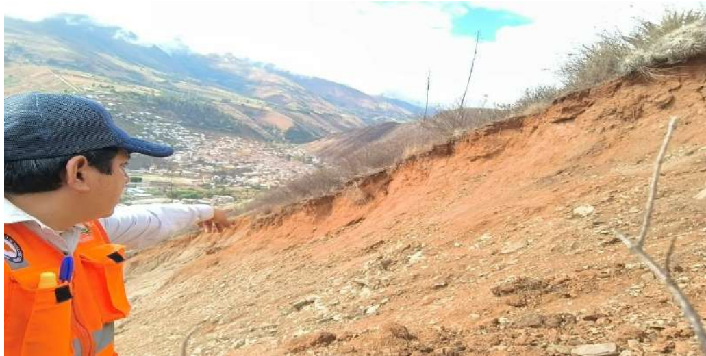
Material inestable en la parte superior del deslizamiento
