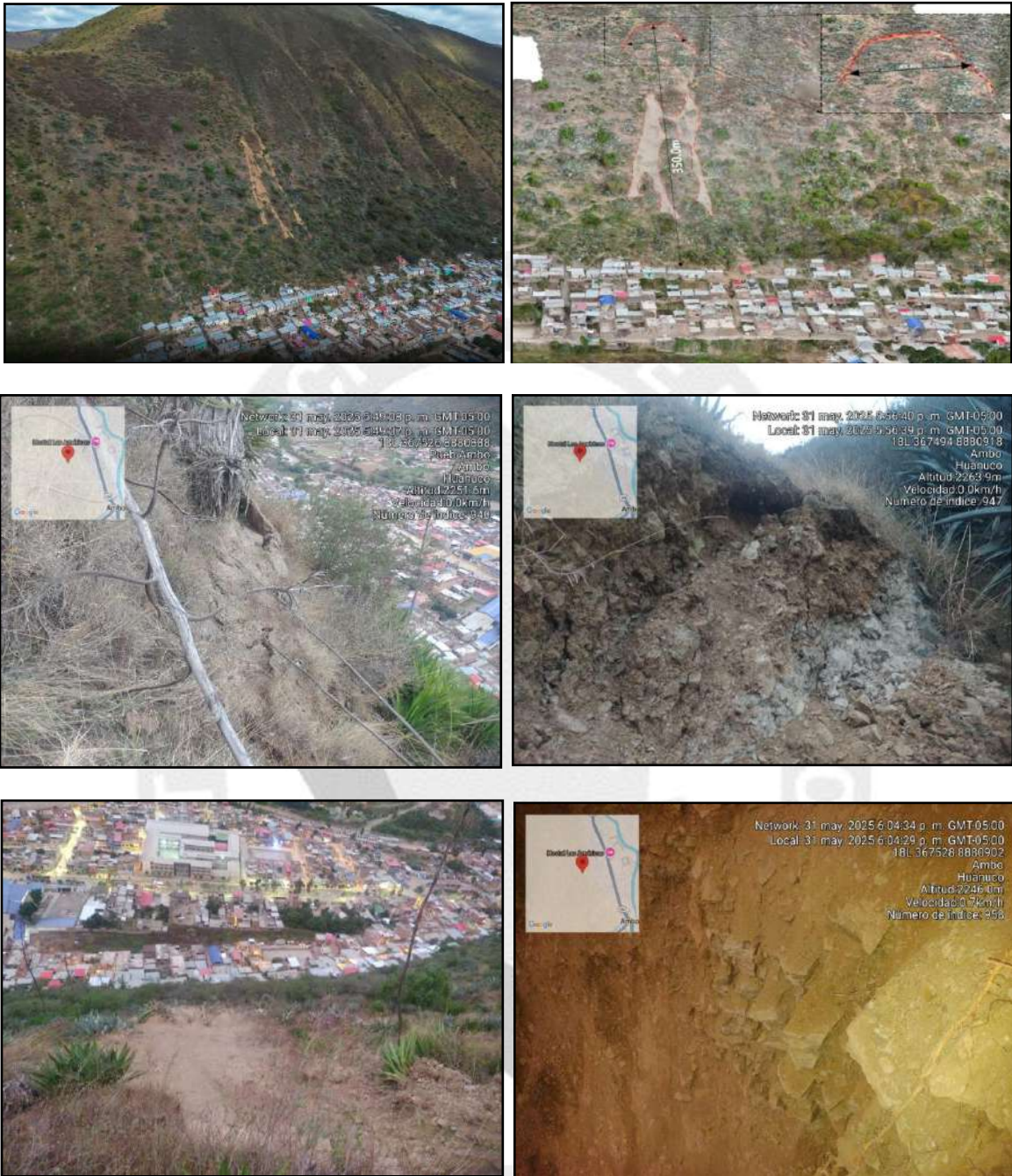
Deslizamiento en el distrito de Ambo
