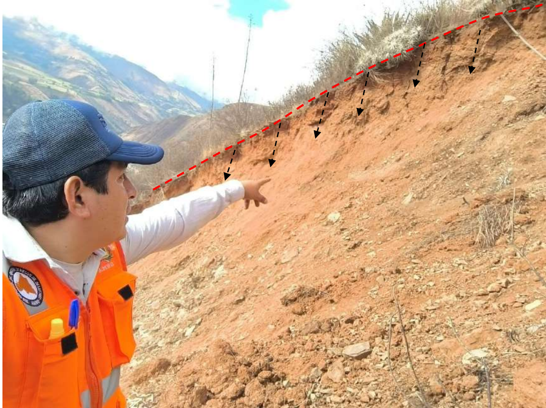
Fotografía 13: Tipo de material y grado de remoción en la cabeza del deslizamiento activo
