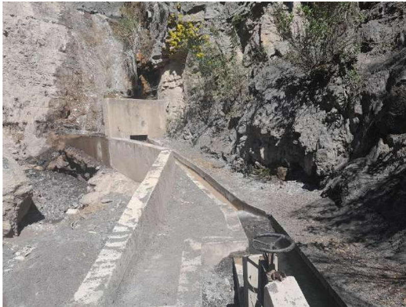
Fotografía9. Vista frontal de la bocatoma del canal Muichi Uran, se observa el basamento rocoso de la infraestructura, se ubica al costado de la quebrada muichi uran a 2 km SW aprox. de la plaza de la localidad.
