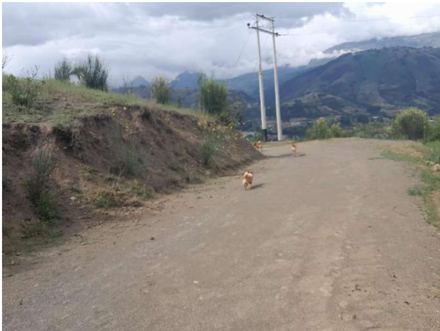
Fotografía29.Vista frontal de torre de alta tensión ubicado a 500 m N aprox. de la plaza de Mallhuapampa.
