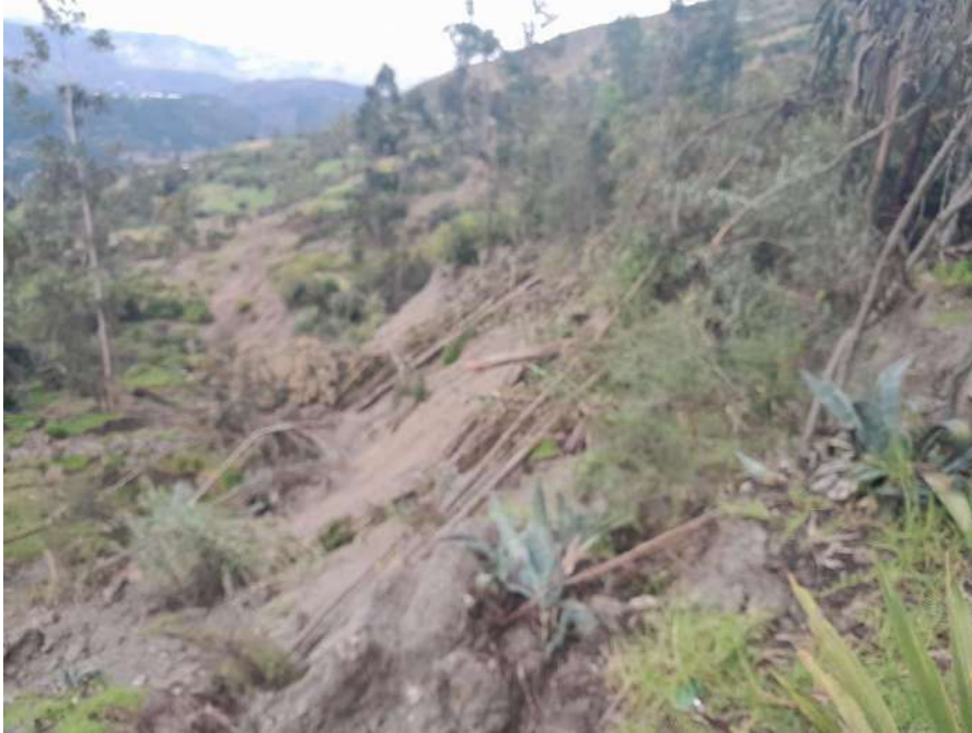
Foto 18. Escarpe de deslizamiento secundario ocurrido en marzo del 2025
