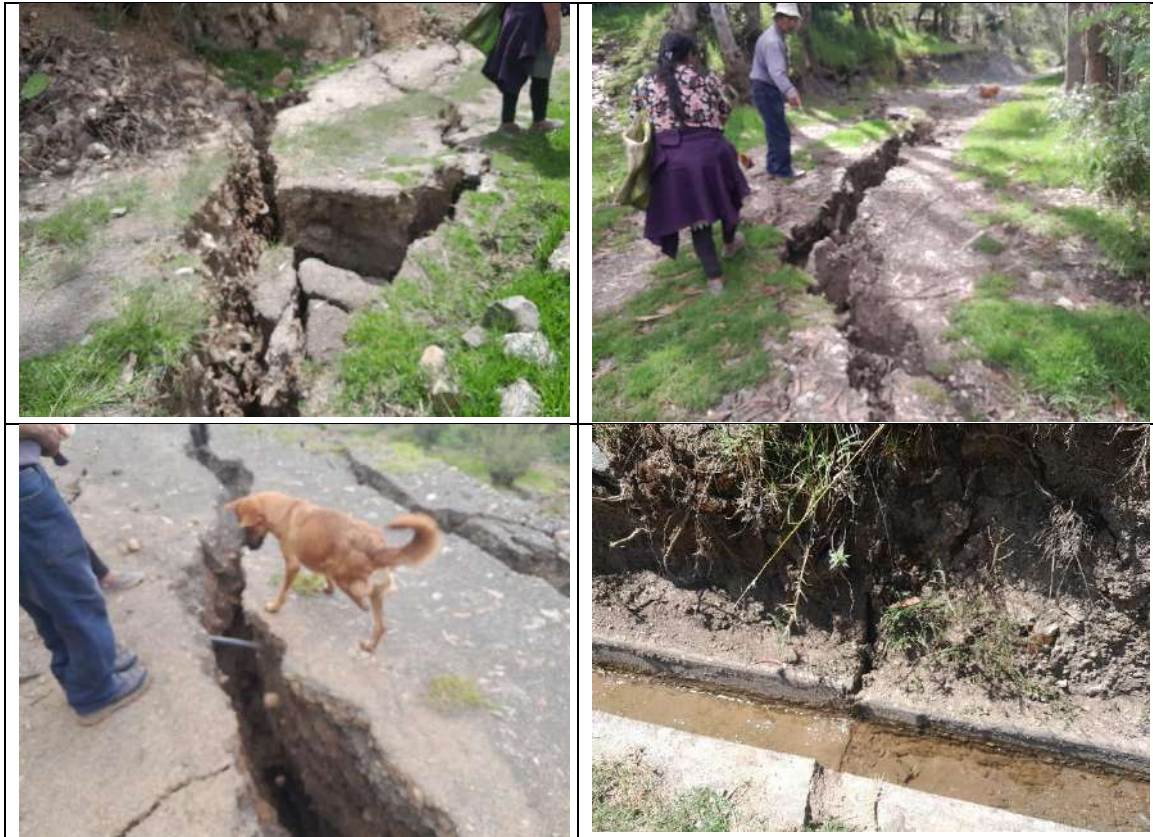
Foto 20. Grietas en trocha debido al deslizamiento.
