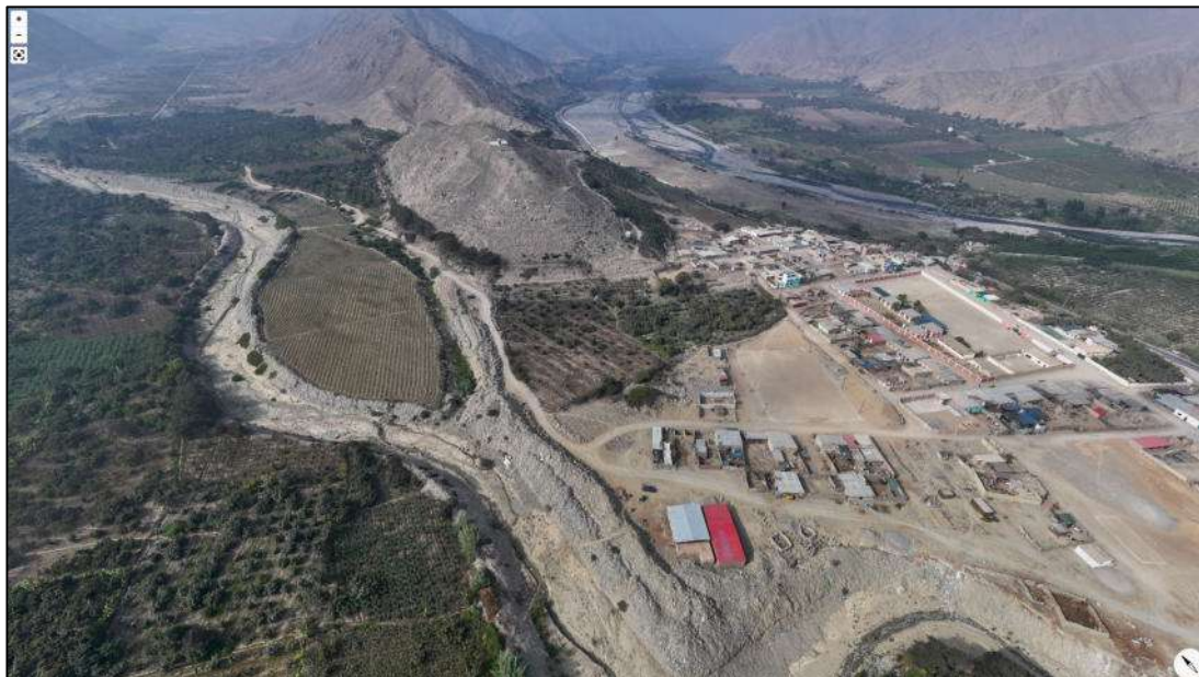
Foto 4: El cauce de la Quebrada Lumbra, resultado de acumulación de sedimentos que han sido erosionados por cursos de agua de gran intensidad en diferentes temporadas.
