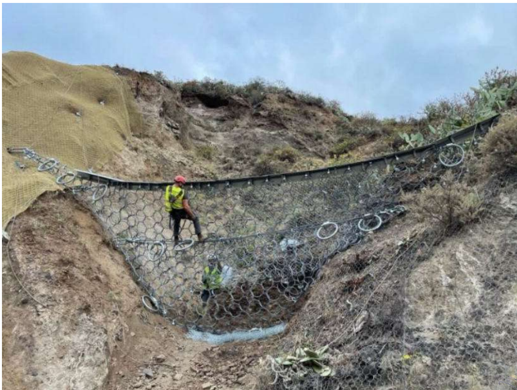
Figura 14: Detalle de una barrera dinámica para frenar el avance de grandes volúmenes de material.
