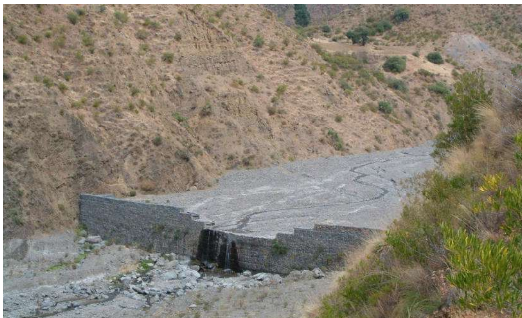
Figura 13: Detalle de mampostería gavionada formando una represa de sedimentos.
