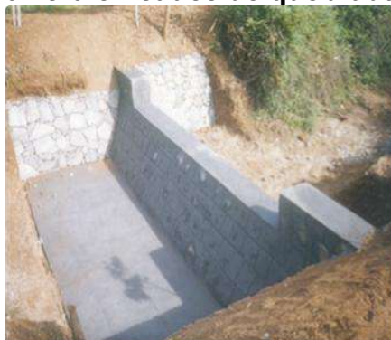
Figura N° 23. Barrera en cauce de quebrada ante flujo de detritos
