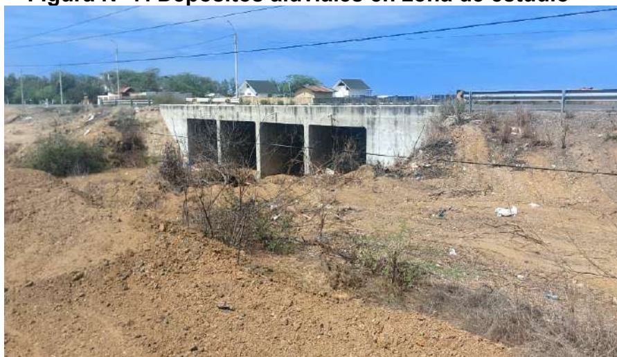
Figura N° 7. Depósitos aluviales en zona de estudio
