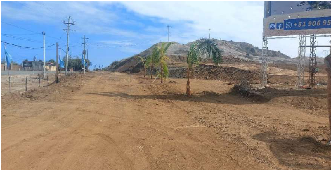
Acceso hacia zona de proyecto
