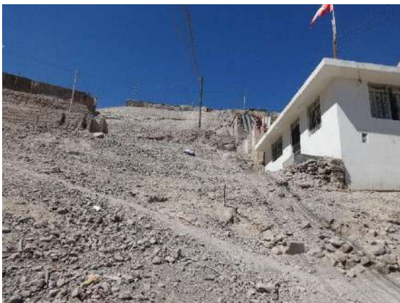
FOTO N° 13: Pendiente muy fuerte (25° - 45°)
