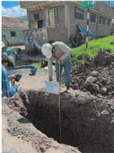
Imagen 6 Calicata para estudio de mecánica de suelos.
