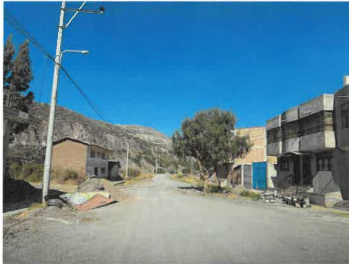
Imagen 4 Alumbrado público y estado de la vía.
