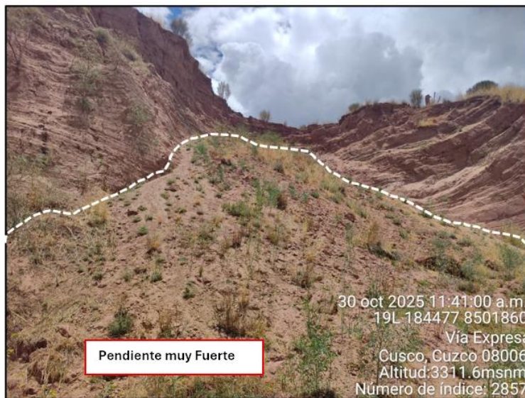
Figura 15: Pendiente escarpada o muy fuerte
