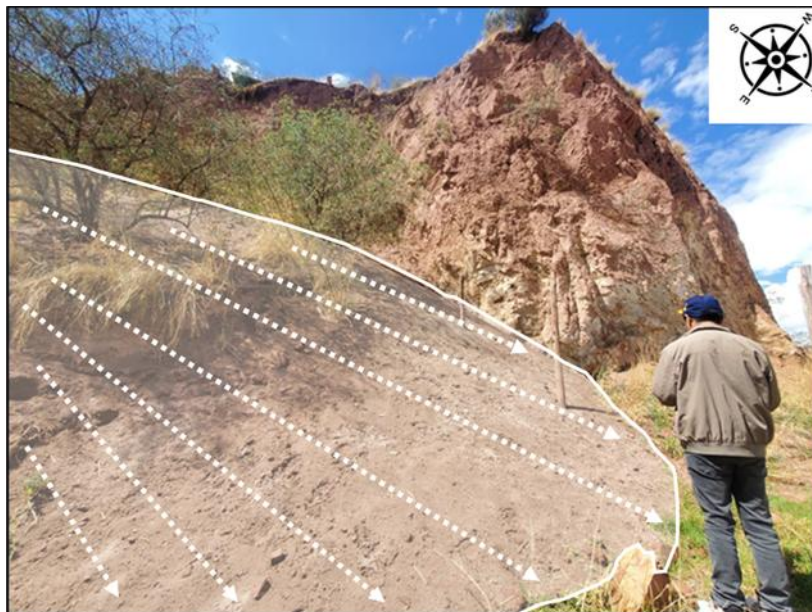
Figura 36: Deslizamiento en el sector central este de la zona de estudio
