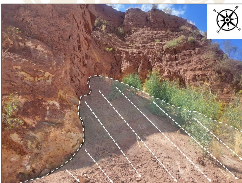
Figura 37: Deslizamiento en la parte Central del área de estudio
