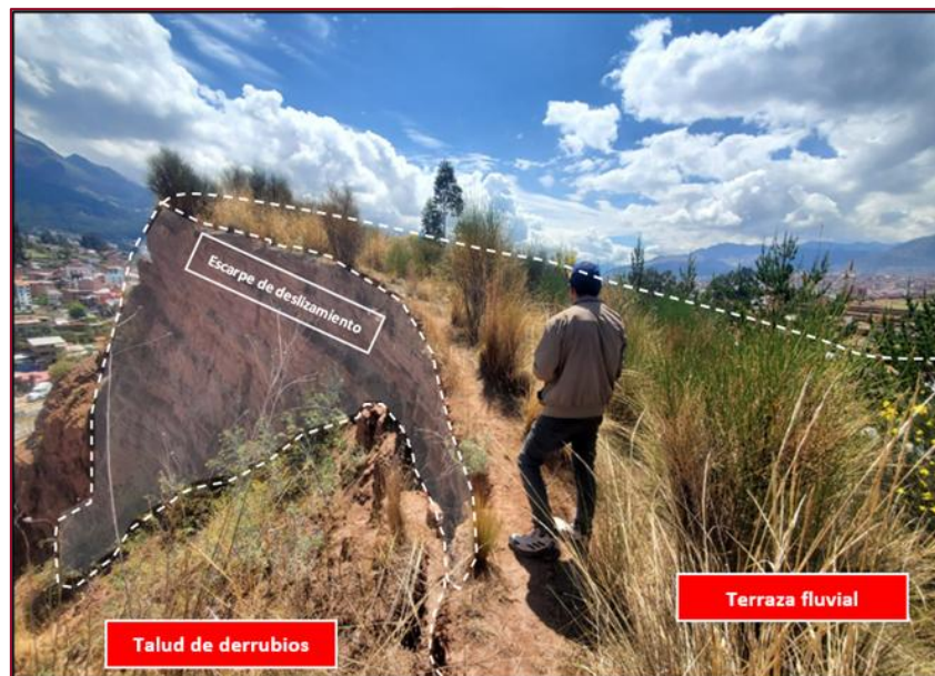
Figura 19: Escarpe de deslizamiento en la parte central del área de estudio
