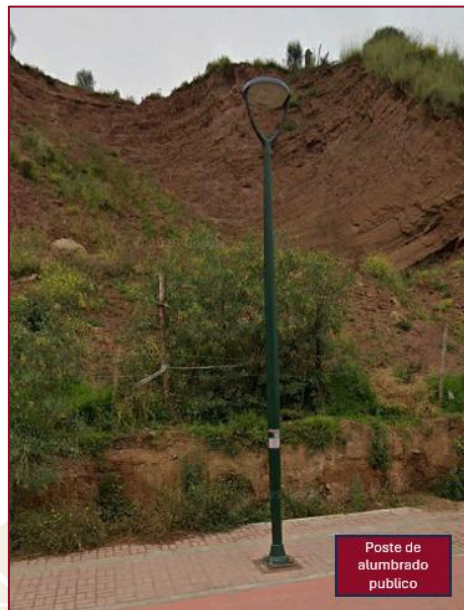
Figura 10: Elemento expuesto de poste de alumbrado público en la zona de estudio
