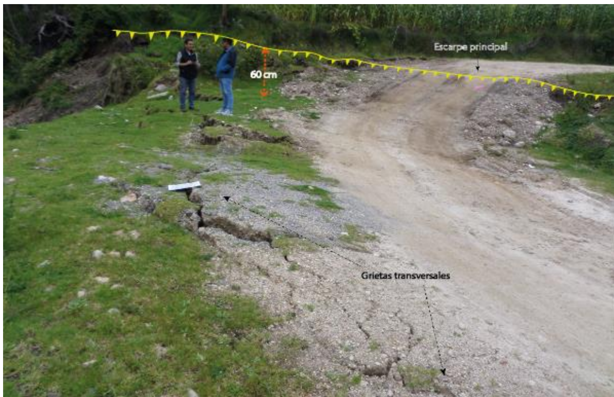
Figura 8. Vista del desnivel de 60 cm sobre la vía Cayas-Colcas que corresponde al flanco derecho del deslizamiento rotacional activo, ubicado con coordenadas 262281 E; 8970102 N, y la presencia de grietas transversales sobre el terreno.
