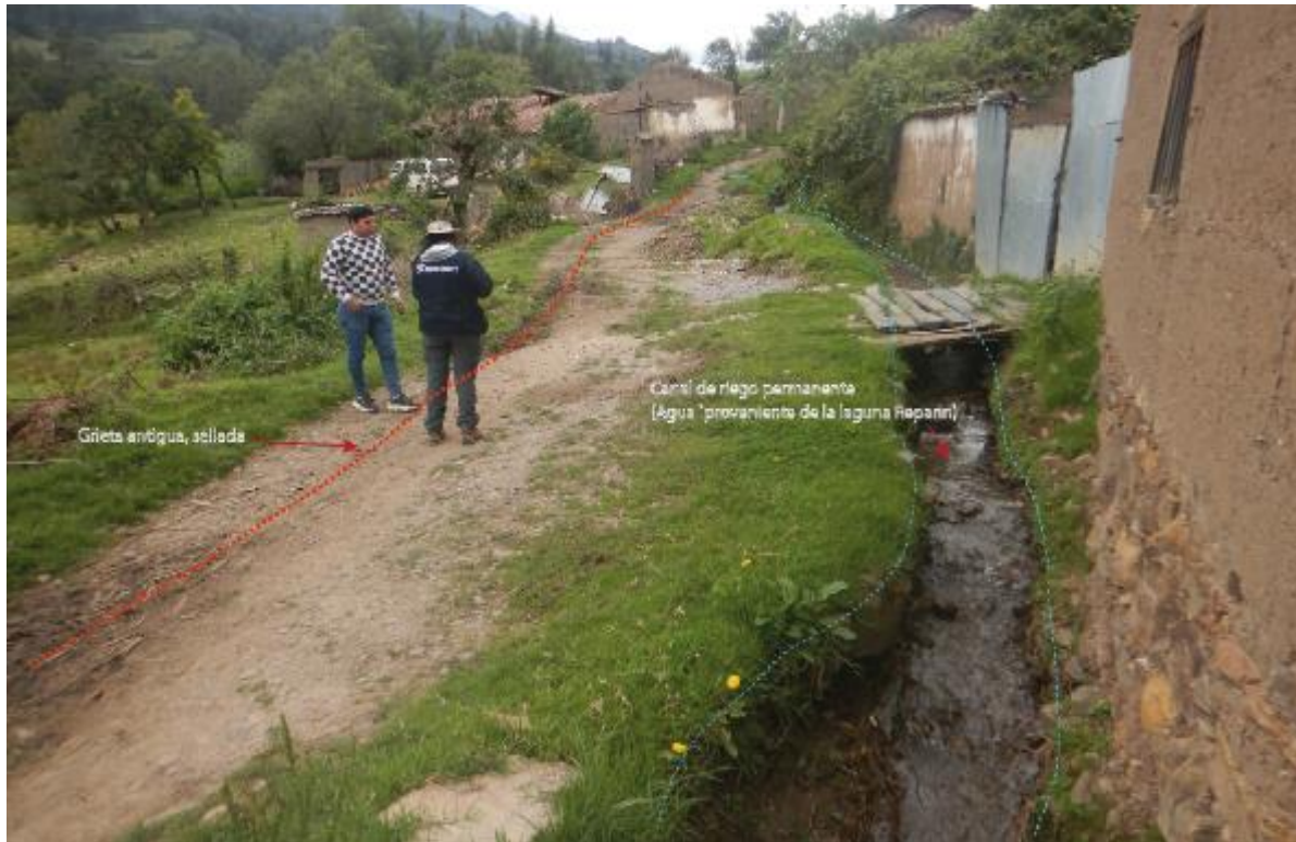
Figura 12. Vista de canales de riego no revestidos, por el cual discurre agua permanente durante todo el año. En líneas entrecortadas de color rojo se muestra una proyección del que podría ser una grieta transversal que fue sellada el año 2023, el cual fue obtenida por testimonios de la población. (actualmente no se evidencia alguna grieta)
