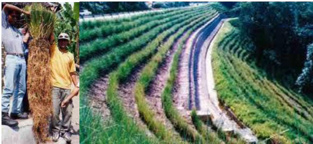
Figura 2.3. Ejemplo de bioingeniería con arbusto (vetiver) en taludes de materiales sueltos.
